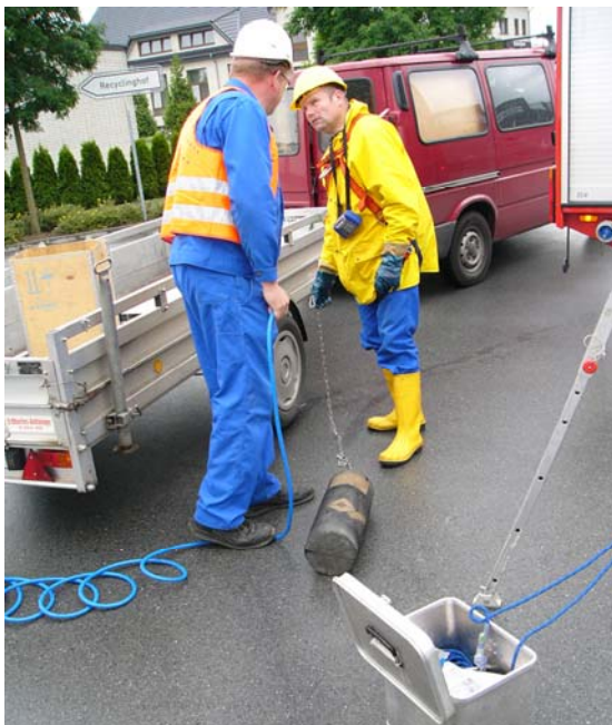
Abbildung 5: Vorbereitung zum Absperrn der Abwasserleitung [FITR]
