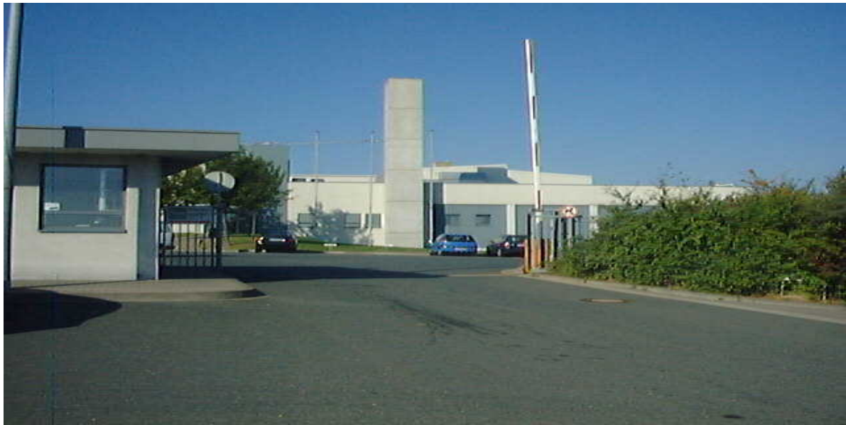
Abbildung 24: Werkseinfahrt Weimarer Wurstwaren GmbH [FITR]
