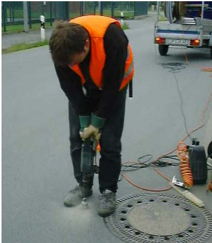
Abbildung 44: Vorbereitung für den Transpondereinbau (anbohren) [FITR]
