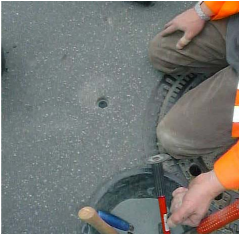
Abbildung 45: Absenden des Transponders für eine gleichmäßige Auflage [FITR]
