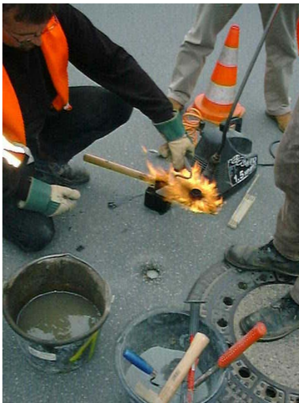
Abbildung 47: Erwärmen eines Verschluss-Stopfens [FITR]
