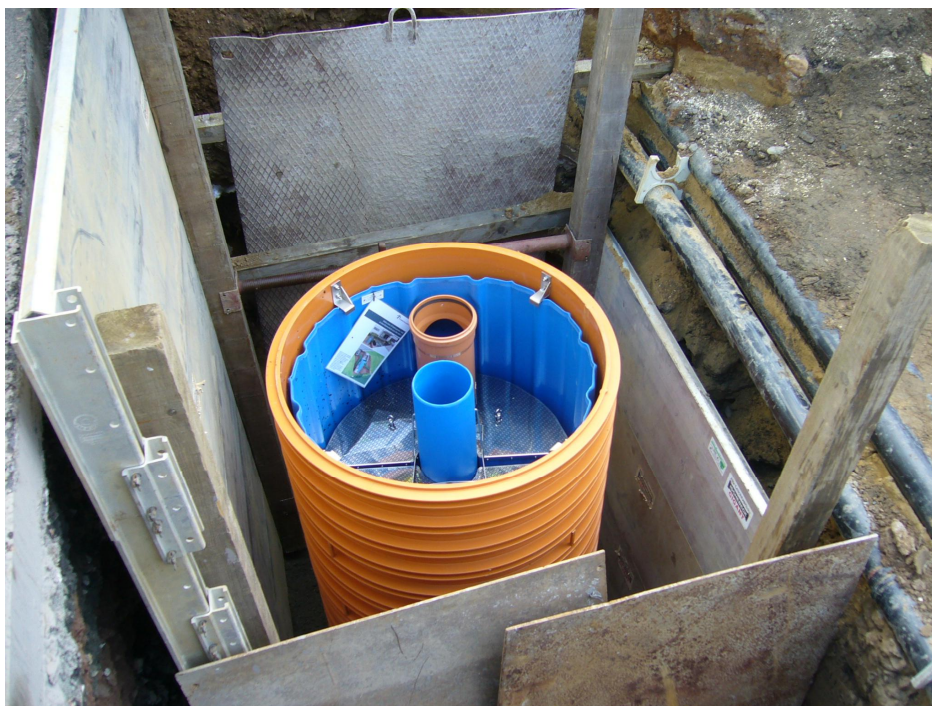
Abbildung 59: 3P ohne Schachtdeckel in der Baugrube
