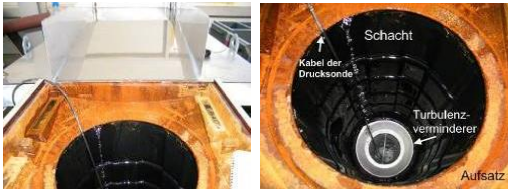
Abbildung 23: Links: Anschluss an die Versuchsanlage. Rechts: Draufsicht des eingebauten Separationsstraßenablauf SSA.
