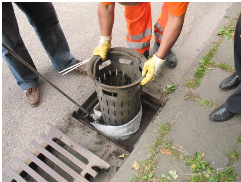
Abbildung 1: Einsatz des Geotextil-Filtersacks
