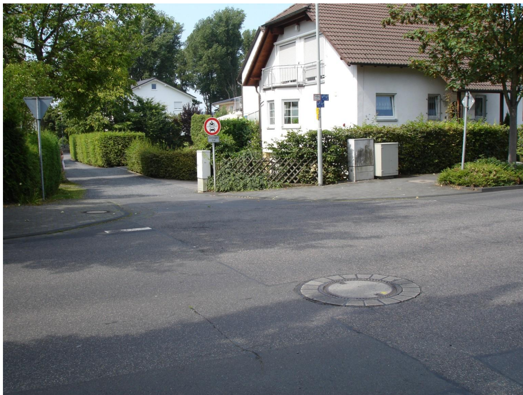
Abbildung 56: Situation vor dem Einbau
