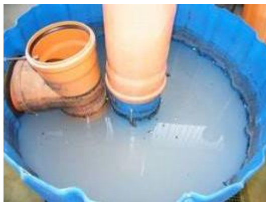
Abbildung 48: Blick von oben in das 3P Hydrosystem während der Teilprüfung 1.
