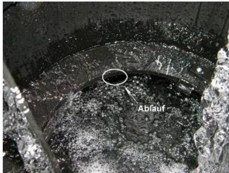
Abbildung 19: Aktivierung des Ablaufs in der mittleren Kammer bei einer Beaufschlagung mit 2,25 l/s.
