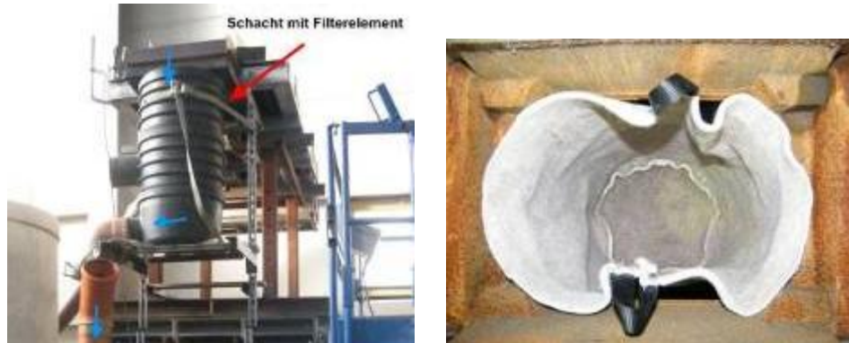
Abbildung 12: Versuchsaufbau mit Filterelement im Schachtkörper, Ansicht.
