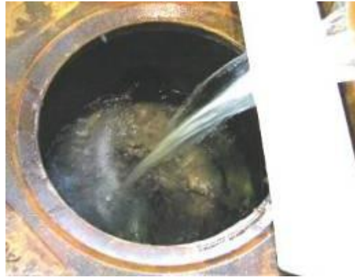
Abbildung 37: Abschlag des Centrifoeel® über den Überlauf beim ersten Teilversuch 1 Kies-Sand/Schwebstoffe.
