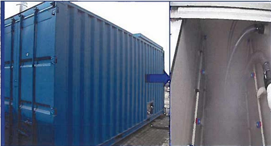
Abb. 4-7: Neue externe Waschzelle – Sprüheinrichtung in der Membrankammer.
