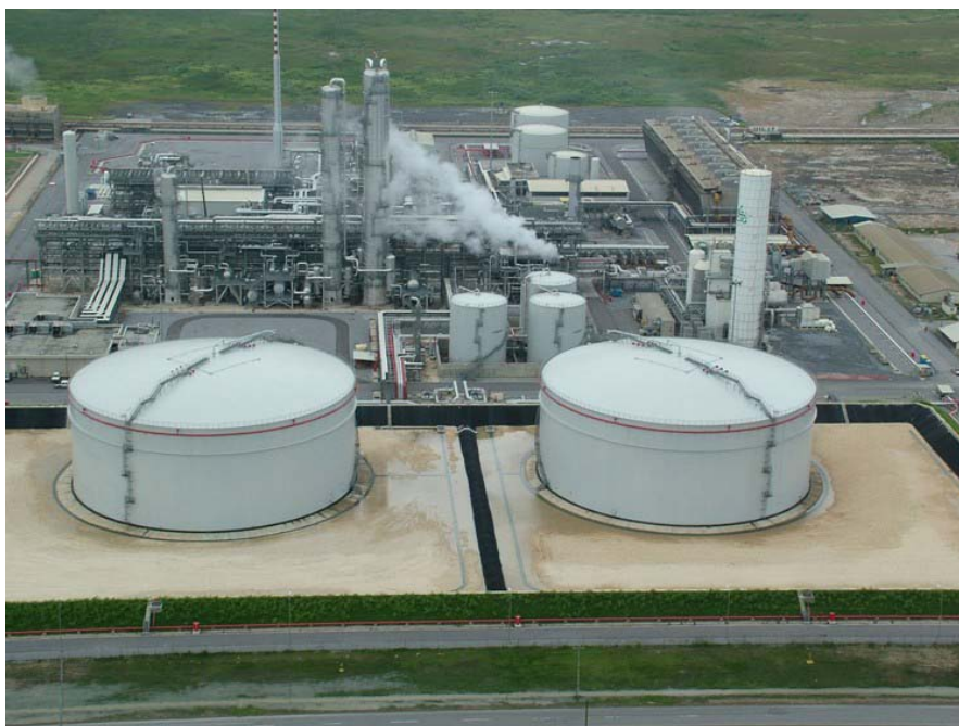
Bild 3-10: ATLAS MegaMethanol Anlage, gebaut durch die Lurgi GmbH [39]
