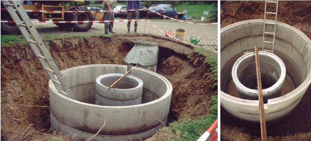
Abbildung 9: Filterschacht mit Einhausung (das Außenringssystem wurde später mit einem zusätzlichen 5. Ring erhöht)
