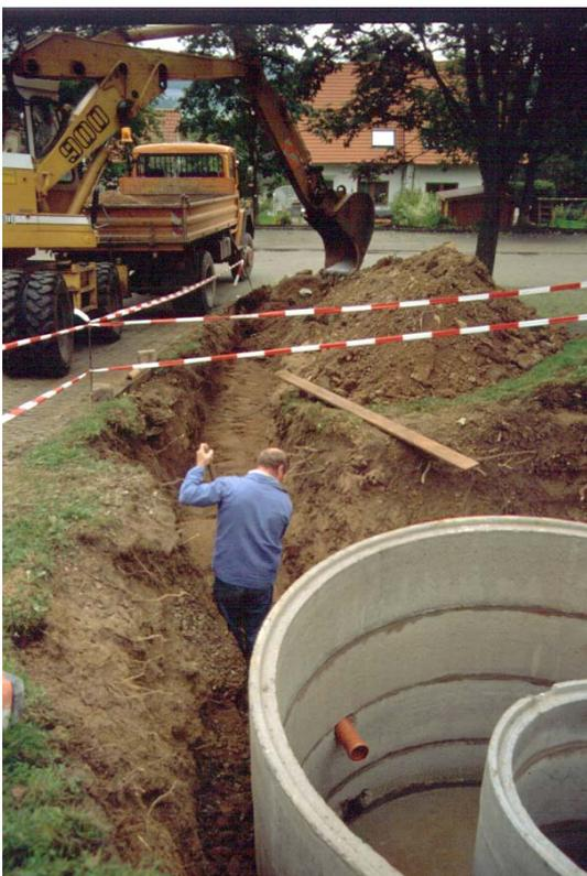
Abbildung 10: Ausschachten der Ableitungsstrecke für die Einleitung in die Kanalisation
