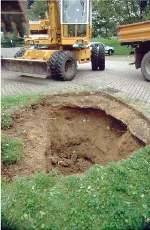
Abbildung 6: Ausheben der Grube für den Absetzschacht
