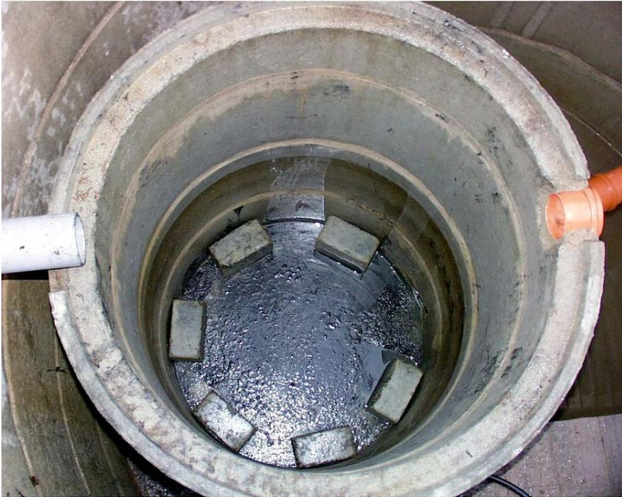
Abbildung 52: Blick in den geräumten Filterschacht nach Entnahme aller Siebkorbbeinsätze; im Bodenbereich sind die Betonsteine als Abstandshalter und Lager für den unteren Aktivkohlekorb zu erkennen
