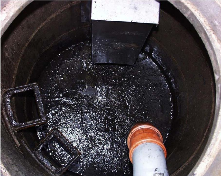
Abbildung 47: Blick in den Absetzschacht nach dem Abpumpen der Klarphase
