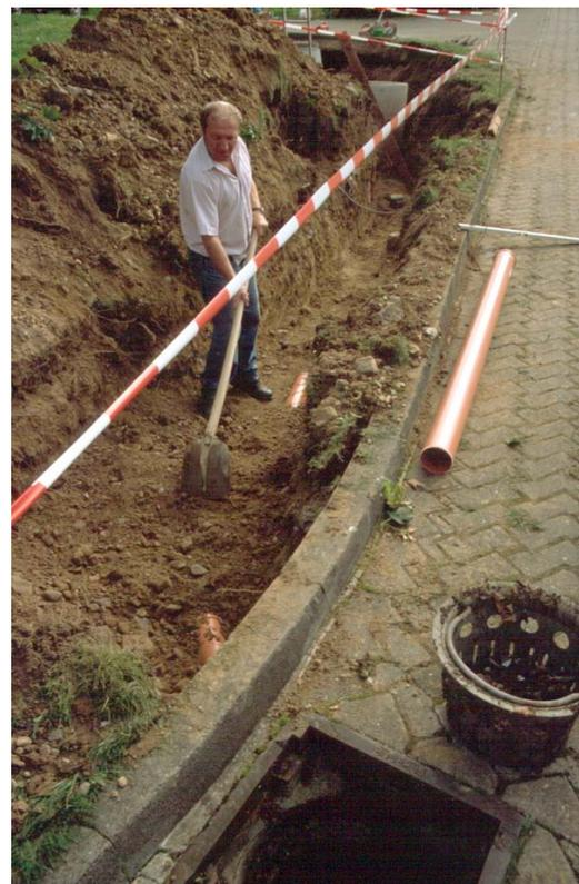
Abbildung 11: Anschluß des Anlagenablaufes an die Kanalisation
