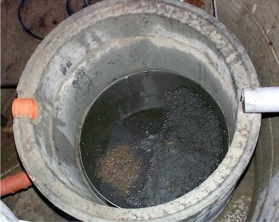
Abbildung 48: Blick auf die obere Kiesschüttung im Filterschacht; die Belegung mit erdigem Material ist deutlich zu erkennen
