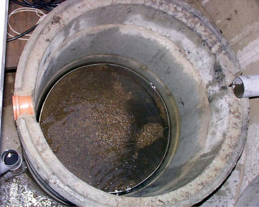
Abbildung 50: Blick auf die untere Kiesschüttung im Filterschacht vor dem Ziehen
