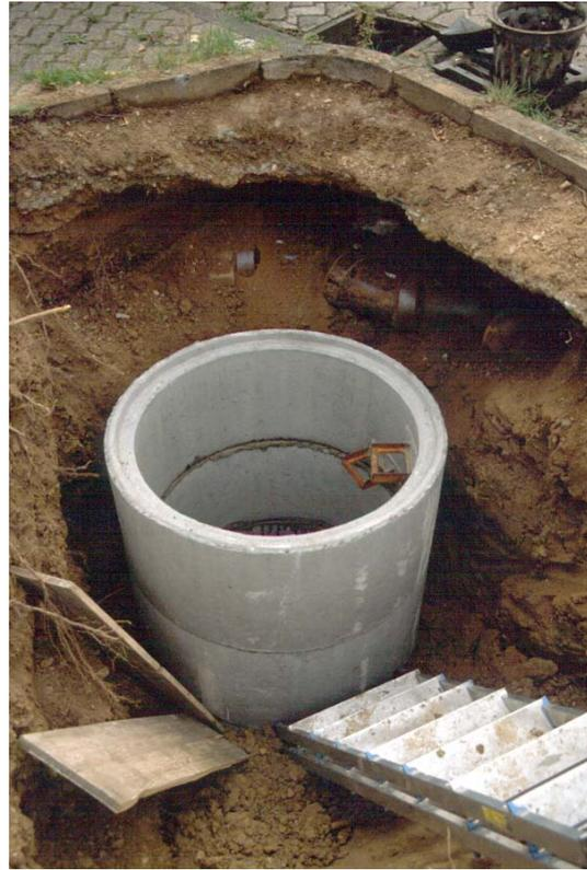
Abbildung 7: Absetzschacht ohne Konus; im Hintergrund ist der Straßeneinlauf zu erkennen, der an den Schacht angeschlossen wurde
