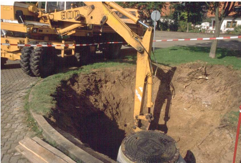
Abbildung 8: Ausheben der Grube für den Filterschacht
