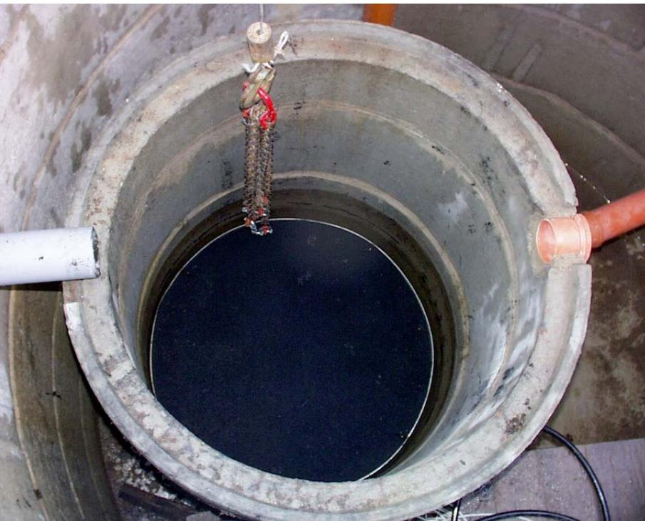
Abbildung 51: Blick auf den oberen Aktivkohleeinsatz im Filterschacht vor dem Ziehen
