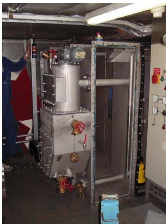
Abbildung 35: Einbringen der Anlagenteile in den vorderen Maschinenraum der MS Asbach über vorhandene Einstiegs Luke
