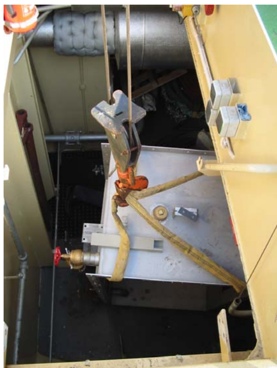
Abbildung 35: Einbringen der Anlagenteile in den vorderen Maschinenraum der MS Asbach über vorhandene Einstiegs Luke
