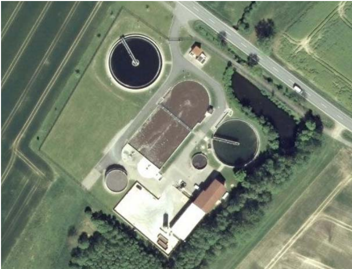
Abbildung 3-1: Luftbild Kläranlage der Stadt Bartrup (Quelle: Google 2013)
