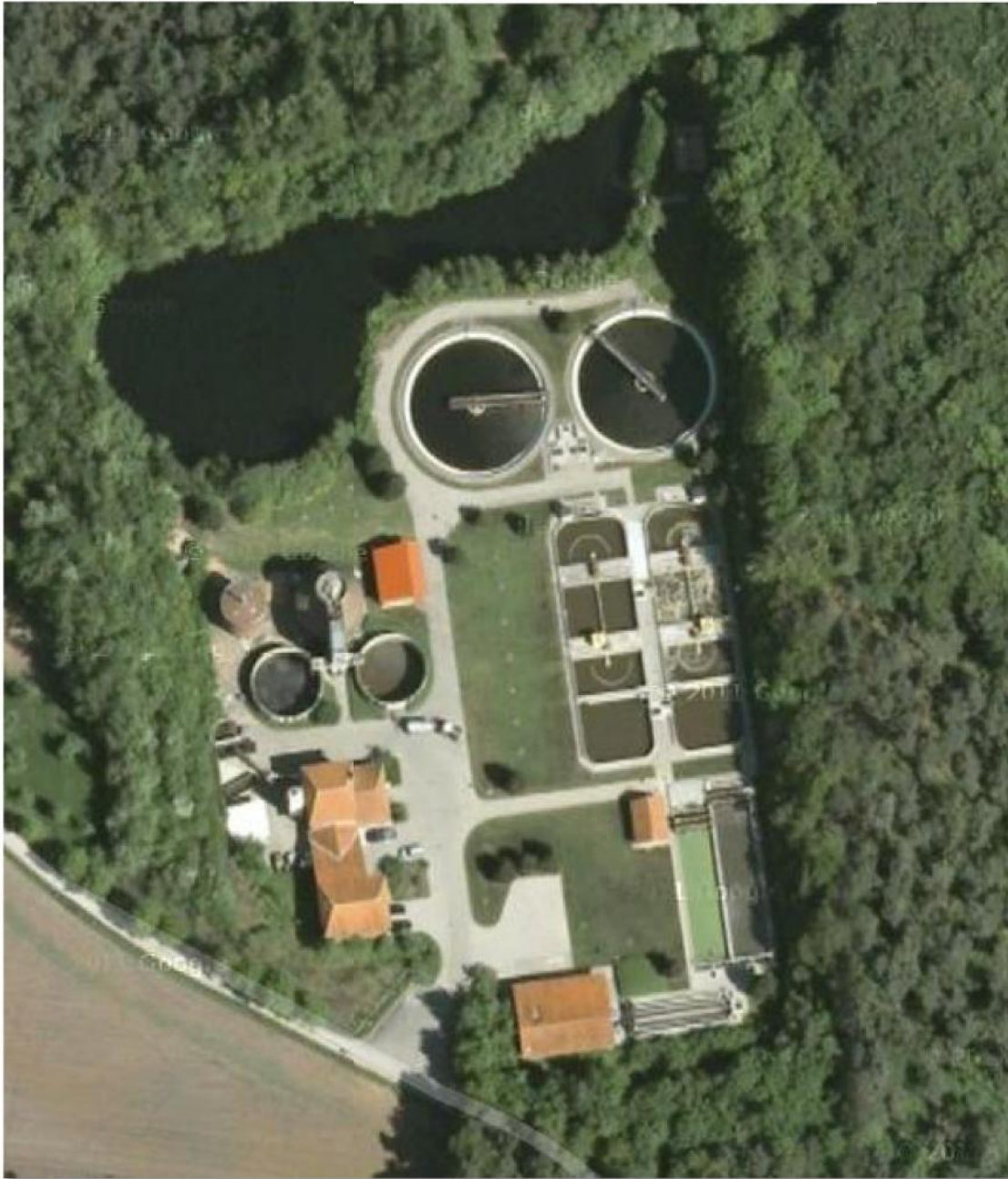
Abbildung 4.1: Nördlich ausgerichtetes Luftbild der Kläranlage Stadtlohn (Google, 2013)
