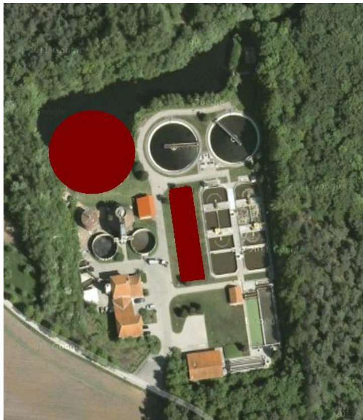
Abbildung 7.1: Mögliche Flächen für den Bau einer vierten Reinigungsstufe (verändert nach Google, 2013)
