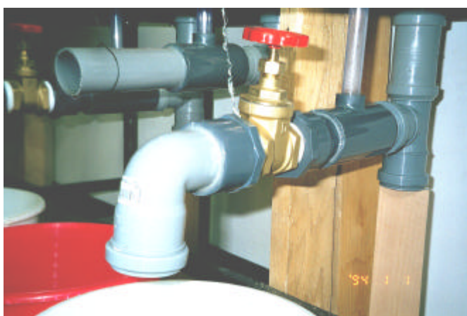
Bild 5.2: Foto der Ablaufvorrichtungen einer gedrosselten und einer freien Ablaufvariante
