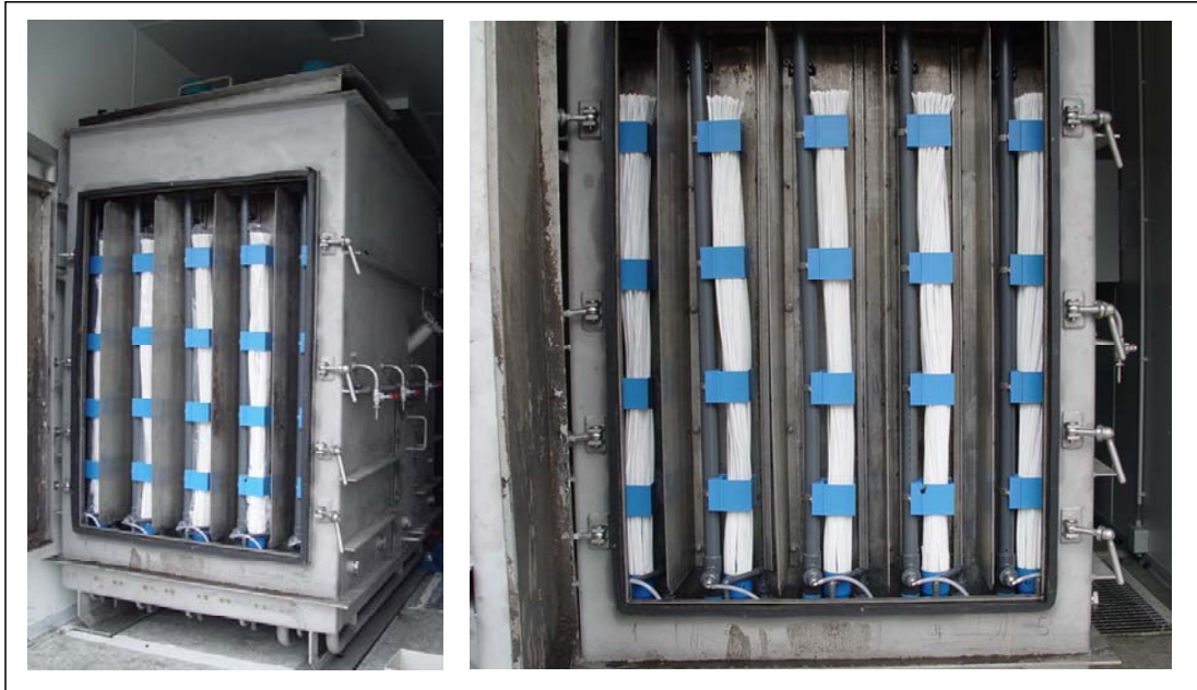
Bild 5-15: Anordnung der Membranen – MBR-Versuchsanlage Eilendorf
