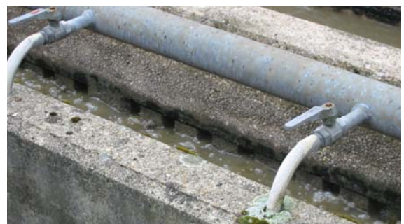
Bild 6-30: Füllstandsproblematik im Sand- und Fettfang der KA
