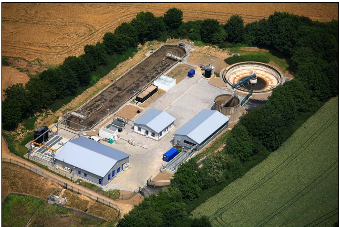
Bild 8-4: Luftbild der Membranbelebungsanlage Glessen
