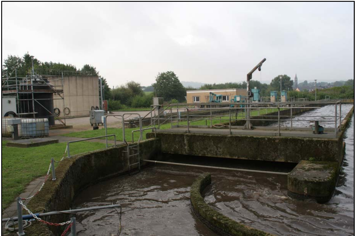
Bild 8-2: Ansicht der bestehenden Kläranlage Glessen
