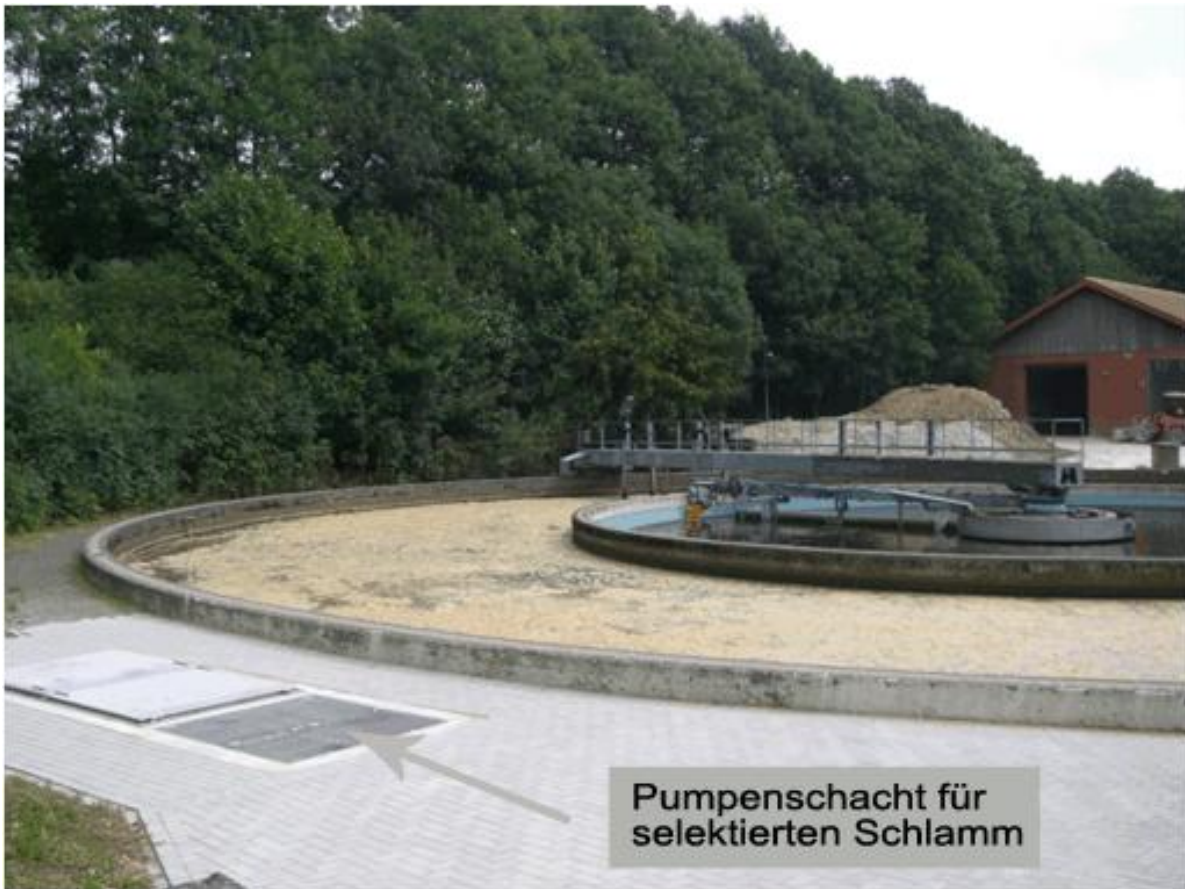
Abbildung 7.6 Einbau von der ÜS-Selekt Anlage auf der KA Oerlinghausen
