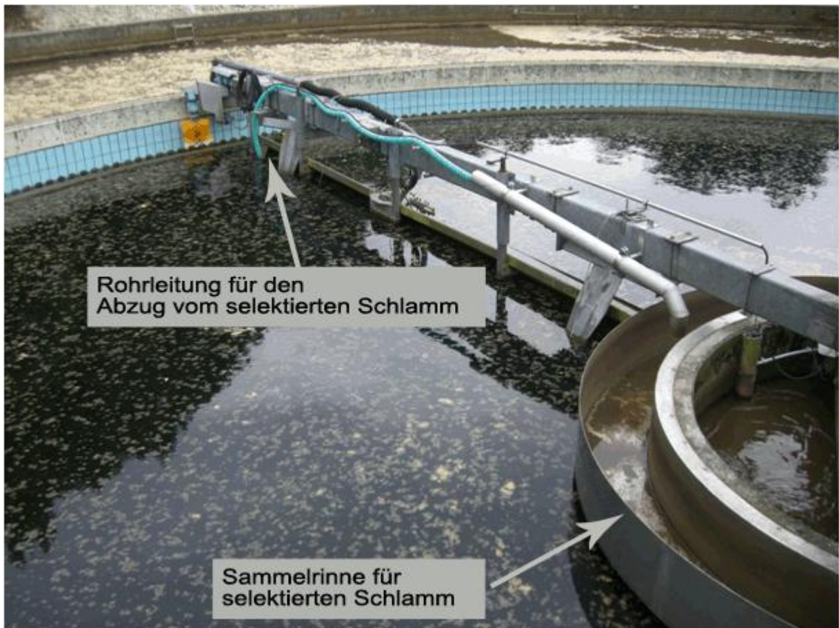
Abbildung 7.5 Einbau von der ÜS-Selekt Anlage im Belebungsbecken auf der KA Oerlinghausen
