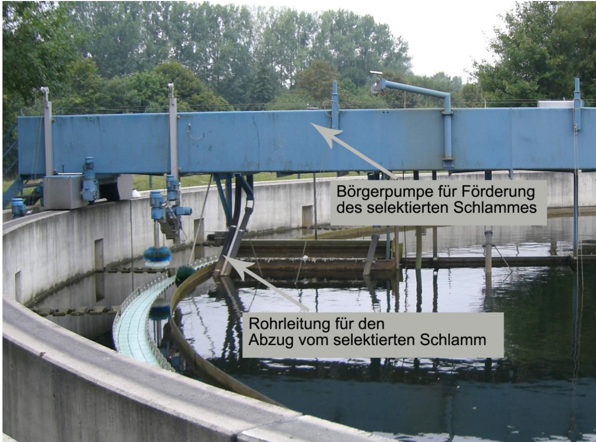
Abbildung 7.7 Einbau von der ÜS-Selekt Anlage auf der KA Bad Salzuflen
