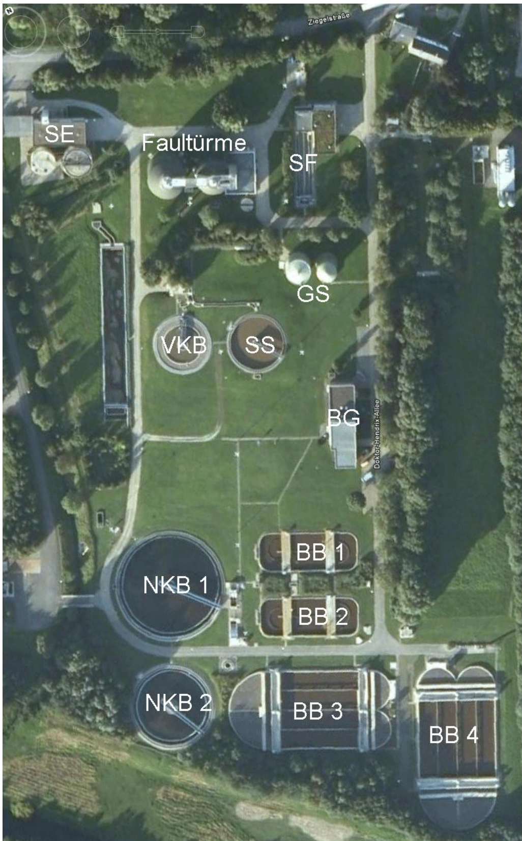
Abbildung 7.3 Übersicht der Kläranlage Bad Salzflen, Abkürzungen: SF – Sandfang, SE – Schlammwässerung, GS – Gasspeicher, VKB – Vorklärung, SS – Schlammwasserspeicher, BG – Betriebsgebäude, BB – Belebungsbecken, NKB - Nachklärung
