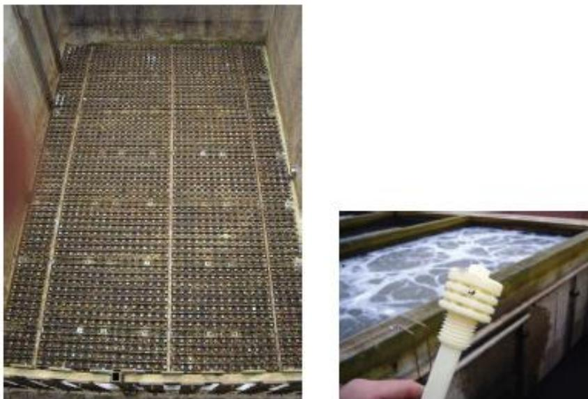
**Abbildung 6: Blick in den GA (links) vor der Befüllung mit Aktivkohle und auf eine der eingebauten Filterdüsen**
