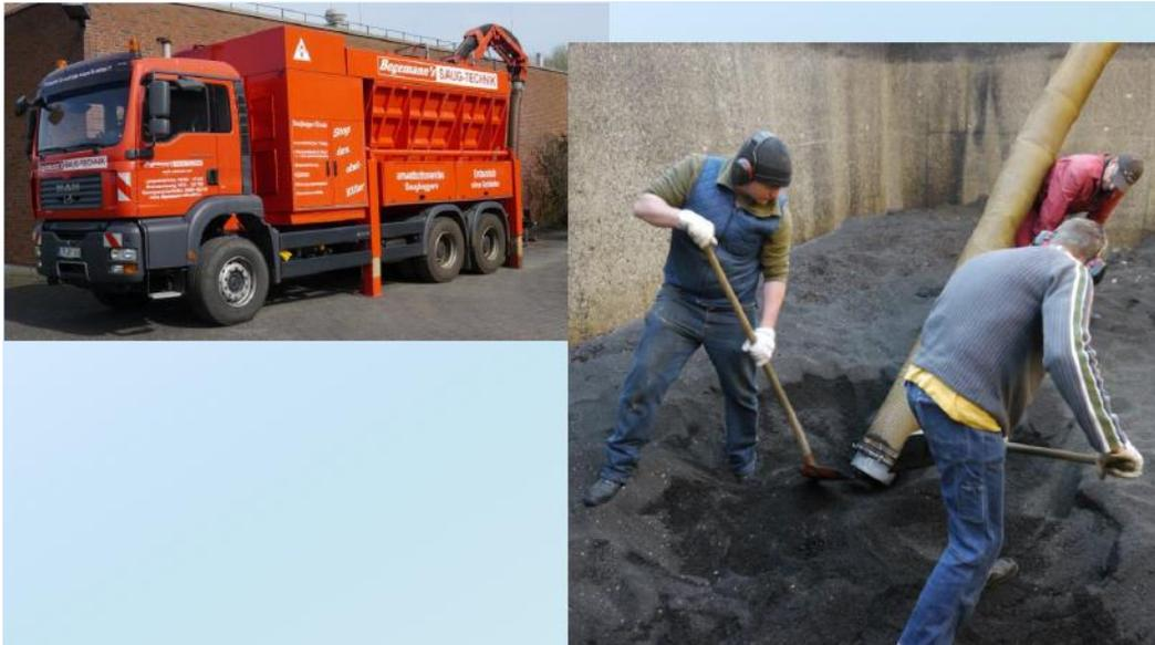
**Abbildung 5: Ausbau der alten Schüttung aus Biofor-Blähton und Stützkies mittels Absaugung**
