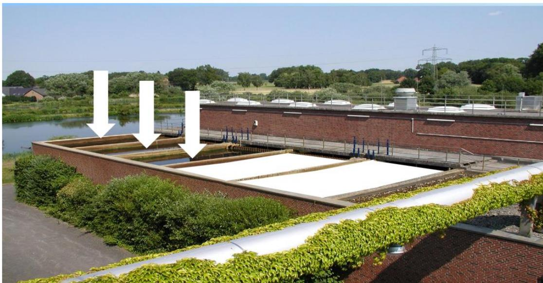
**Abbildung 1: Die drei umgerüsteten Filterkammern der Biofor-Stufe des AOL mit granulierter Aktivkohle**
