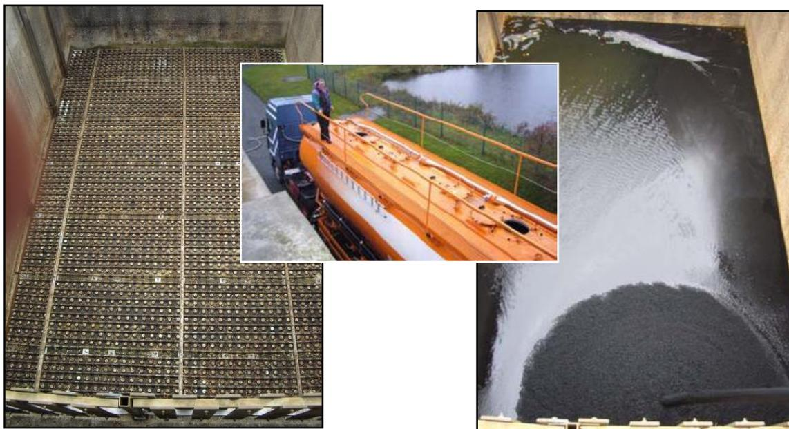
**Abbildung 7: Hydraulische Befüllung einer umgerüsteten Filterkammer mit granulierter Aktivkohle mit fliegender Leitung (A-Schlauch)**
