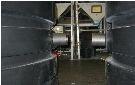
Abbildung 4: Angeschweißter Stutzen
