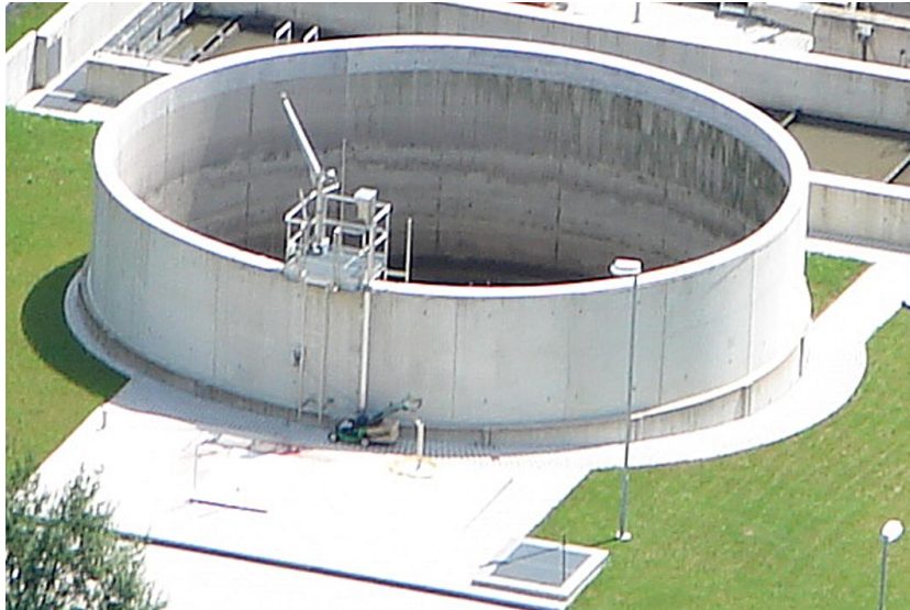
Abbildung 2-6: Verteilerschacht und Pufferbehälter
