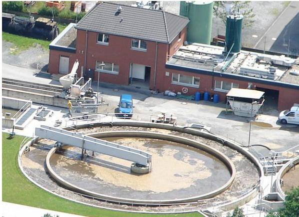
Abbildung 2-4: Kombibecken 1 mit Denitrifikation innen und Nitrifikationsbecken außen (links); Kombibecken 2 mit Nitrifikationsbecken 2 außen und Nachklärbecken innen und Faulbehälter im Vordergrund (rechts)
