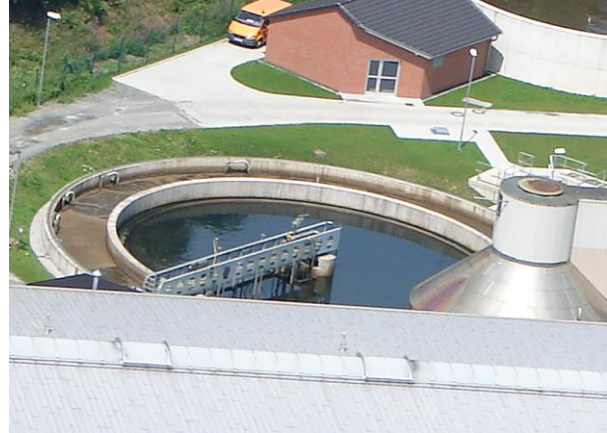
Abbildung 2-4: Kombibecken 1 mit Denitrifikation innen und Nitrifikationsbecken außen (links); Kombibecken 2 mit Nitrifikationsbecken 2 außen und Nachklärbecken innen und Faulbehälter im Vordergrund (rechts)
