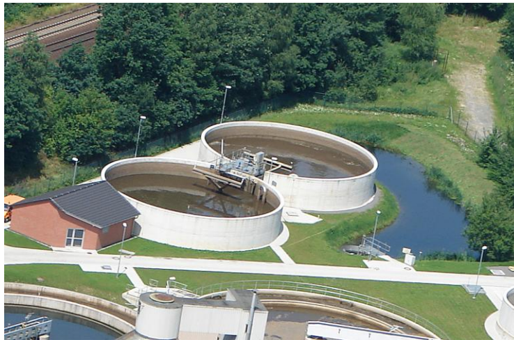
Abbildung 2-7: SBR1 und 2 mit Betriebsgebäude 2 (links) und Pufferteich (rechts)
