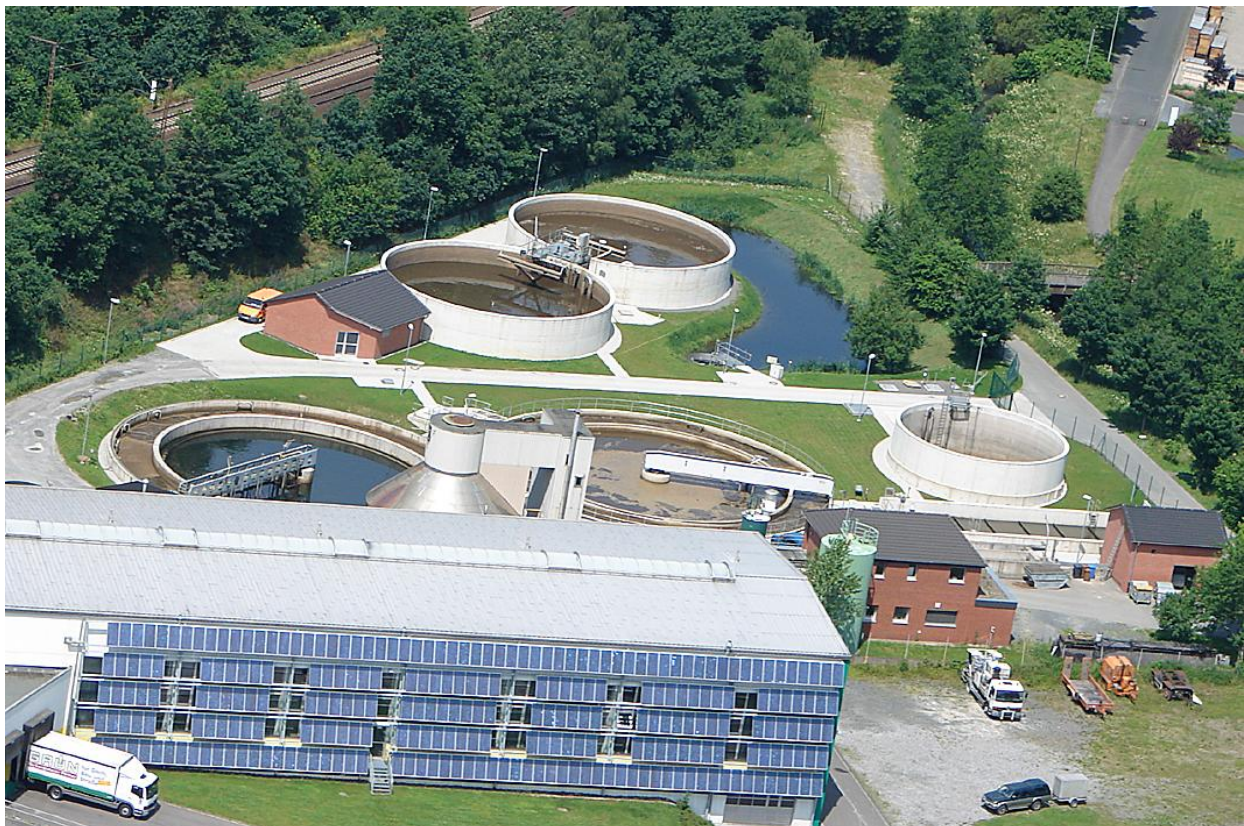
Abbildung 2-1: Übersichtsfoto zur Kläranlage Weißtal
