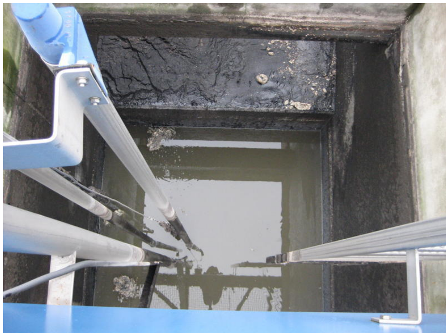
Abbildung 12: konstruktive Ausbildung des SFF-Bauwerkes im Ablaufbereich
