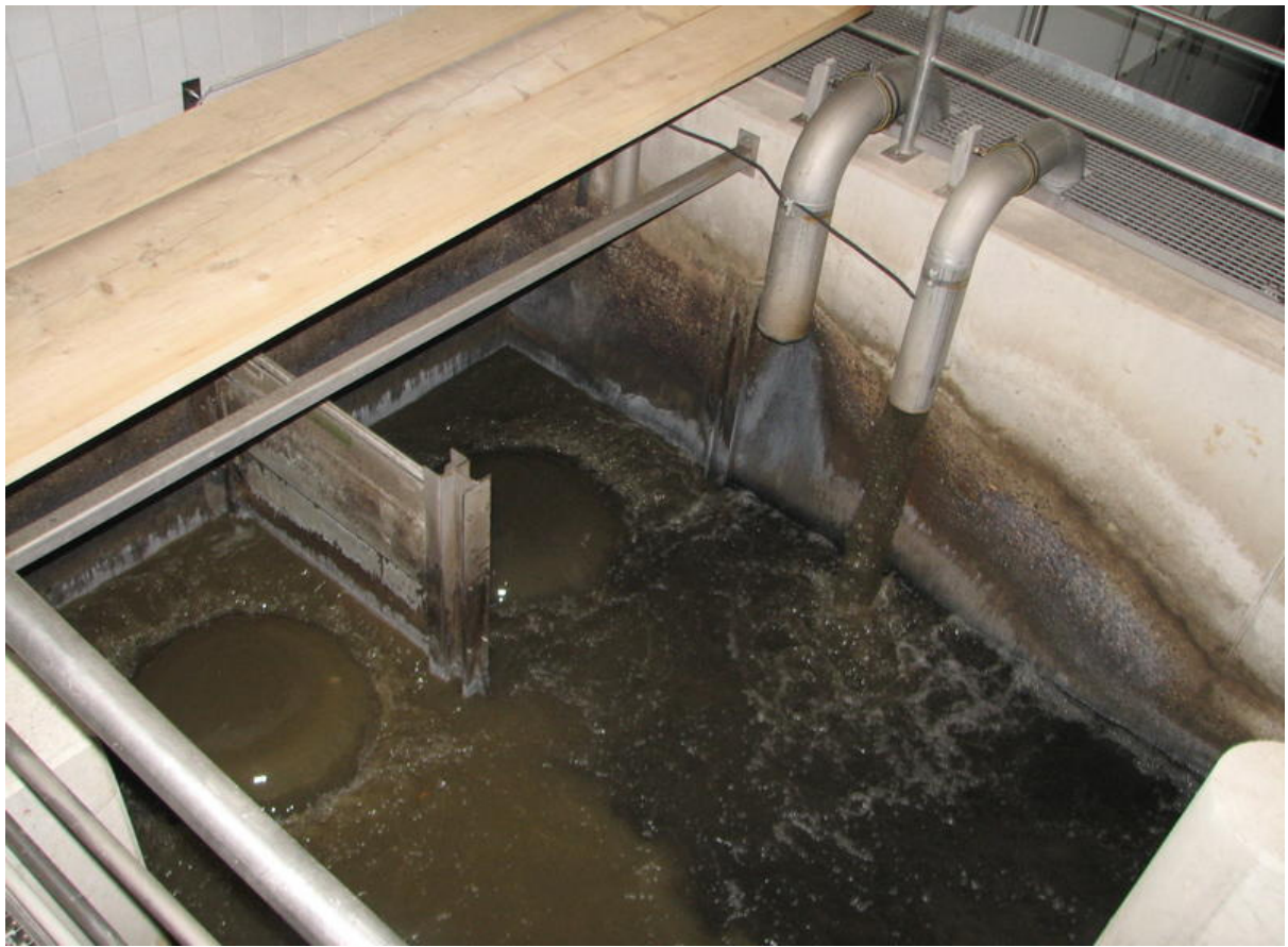
Abbildung 115: Fällungsreaktion im Zulaufbereich (Foto aufgenommen am 28.05.2008)
