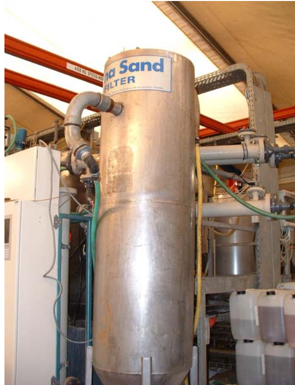
Abbildung 2.10: Dyna-Sand-Filter
