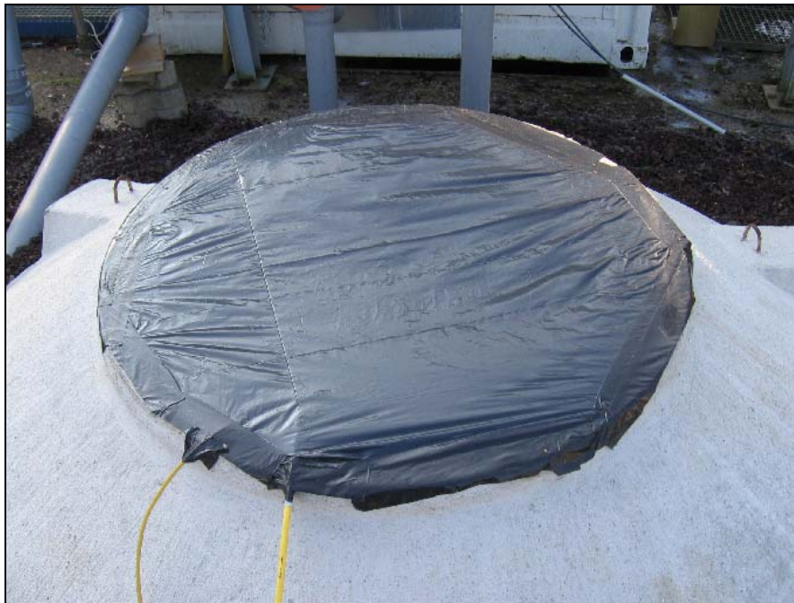
Abbildung 23: Abdichtung der Vorklärung
