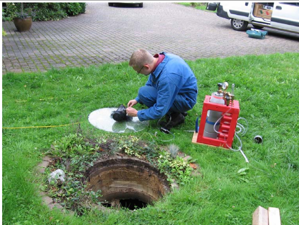
Abbildung 13: Installation der Messtechnik vor Ort
