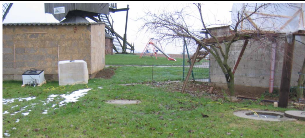
Abbildung 14: Installierte Messtechnik vor Ort
