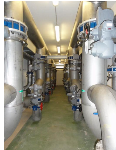
Abbildung 6: Spülpumpen Flockungsfiltration Kläranlage Detmold (links)
