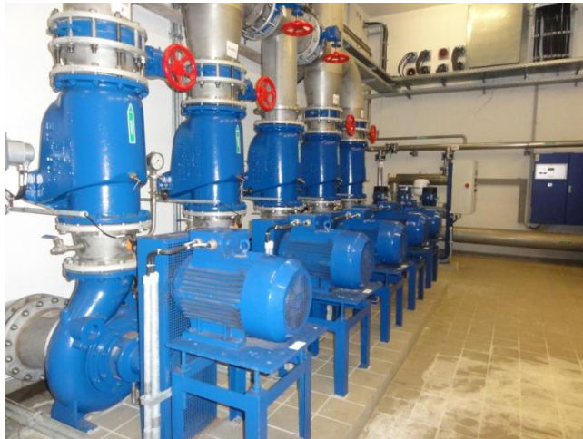
Abbildung 6: Spülpumpen Flockungsfiltration Kläranlage Detmold (links)
