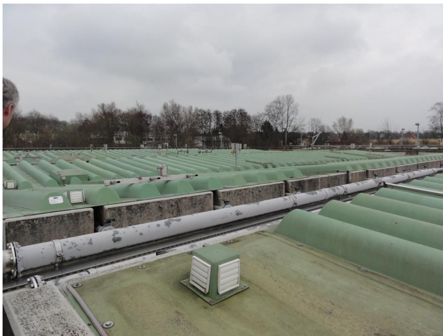
Abbildung 3: Abgedeckte Belebungsbecken der Kläranlage Detmold
