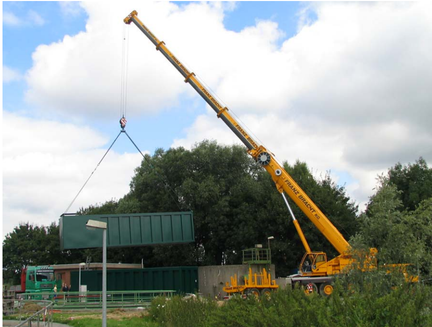
Abbildung 3-2 Abladen einer Containereinheit auf der KA Xanten-Vynen
