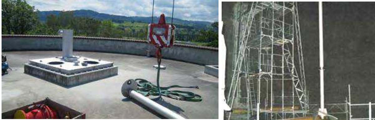
Bild 4.34: Nachrüsten eines Schlammstapelbehälters (AVA, 2012)
