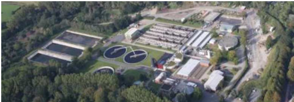
Bild 9.9: Luftbild der Kläranlage Lingen (Hüer, 2013)
