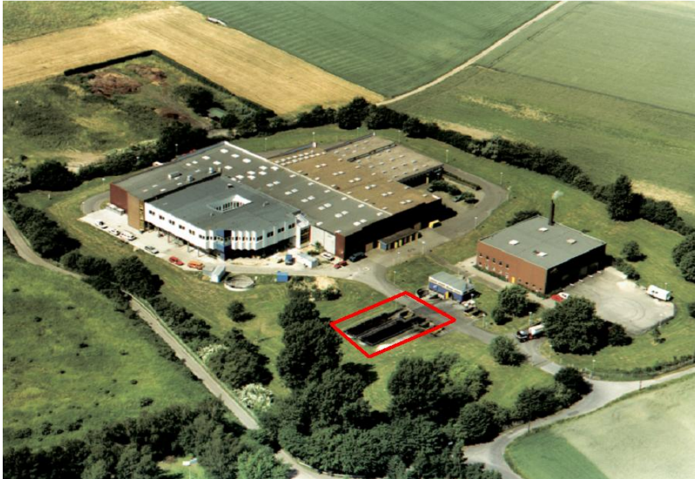
Abbildung 4: Trockenbeete im Wasserwerk Düsseldorf-Holthausen
