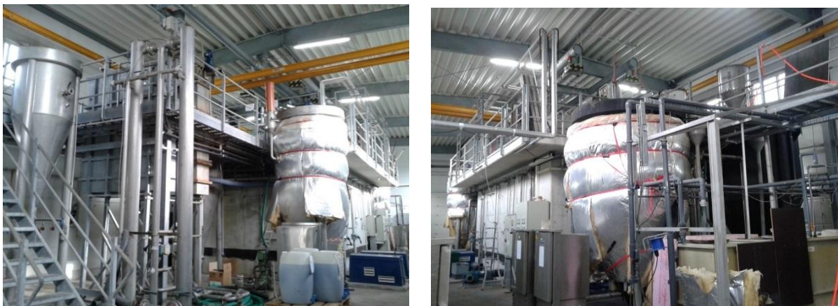
Abbildung 7: Ansicht der Versuchsanlage
