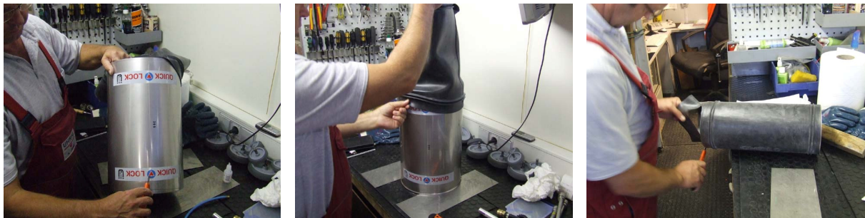
Abb. 46: Anschneiden der Transportsicherung (links), Überstülpen der EPDM-Gummidichtung über die Manschette (mittig), Abtrennen des Gummiüberstands an der EPDM-Gummidichtung (rechts)
