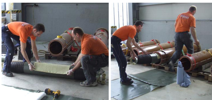
Abb. 16: Setzen eines Kurzliners für die ergänzenden Haftzugprüfungen
