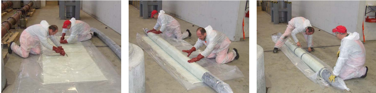
Abb. 40: Zusätzliches Einarbeiten des Harzes mit Laminierrollen (links), Umwickeln des Sanierungspackers mit der harzgetränkten Glasfasermatte (mittig), Fixieren auf dem Packer (rechts)
