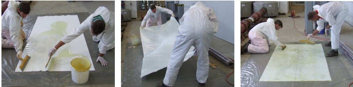
Abb. 29: Auftragen des Harzes (links), Umdrehen der Gewebelage (mittig), Auftragen des Harzes auf die Geweberückseite (rechts)
