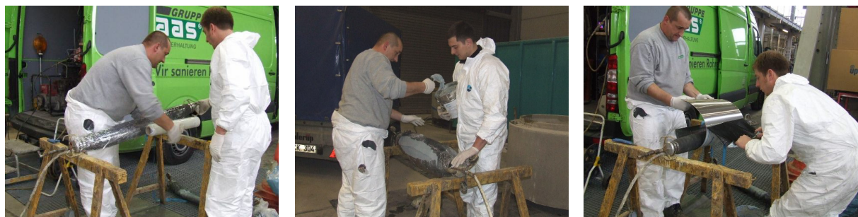
Abb. 49: Umwickeln des Packers mit Stretchfolie (links), Auftragen des Harzes zum Vorverpressen (mittig), Entfernen der Schutzfolie auf der Edelstahlhülse (rechts)
