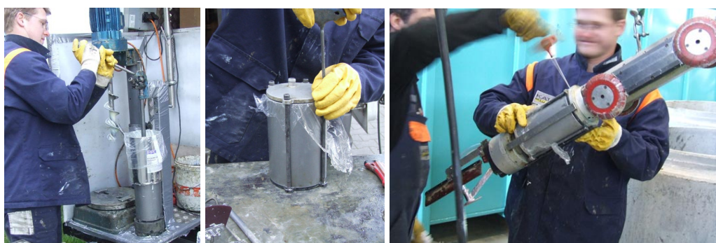
Abb. 26: Umfüllen des Harzgemisches in Kartusche (links), Verschließen der Kartusche (mittig), Einsetzen der Kartusche in den Spachtelroboter (rechts)
