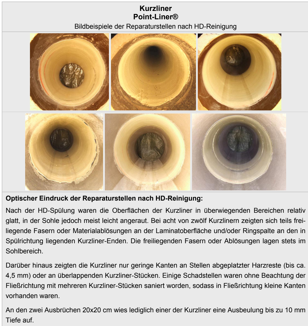
Abb. 59: Bildbeispiele und optischer Gesamteindruck - Reparaturstellen nach HD-Reinigung (Point-Liner®)
