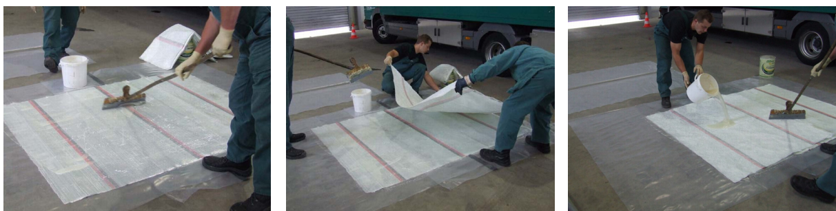
Abb. 36: Auftragen des Harzes auf das Glasfasergewebe (links), Auflegen einer weiteren Gewebelage (mittig), Auftragen des Harzes auf die zweite Gewebelage (rechts)
