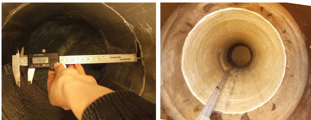
Abb. 8: Beispiel: Vermessung einer Kante (links) und einer Materialablösung (rechts) bei der Begutachtung der Reparaturkörper
