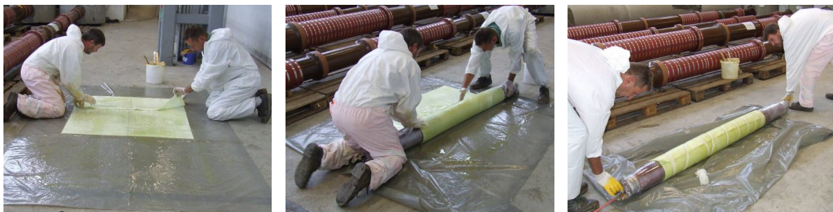
Abb. 30: Einschlagen des Glasfasergewebes zur Mitte hin (links), Aufwickeln des harzgetränkten Glasfasergewebes auf den Packer (mittig), Fixierung der Gewebematte mit Kreppband (rechts)
