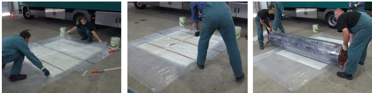
Abb. 37: Abdecken des harzgetränkten Glasfasergewebes mit Folie (links), Einarbeiten des Harzes mit Laminierrollen (mittig), Umwickeln des Packers mit dem harzgetränkten Glasfasergewebe (rechts)
