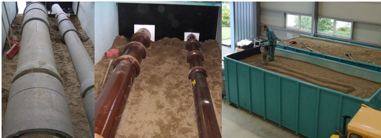
Abb. 3: Teststreckenaufbau für die Injektions- und Spachtel-/Verpressverfahren
