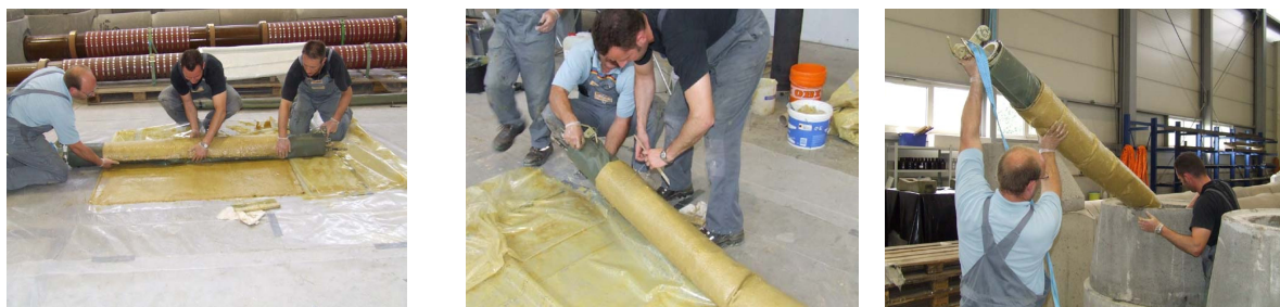
Abb. 34: Umwickeln des Sanierungspackers mit der harzgetränkten Glasfasermatte (links), Fixieren der harzgetränkten Glasfasermatte (mittig), Einsetzen des Packers in den Kanal (rechts)
