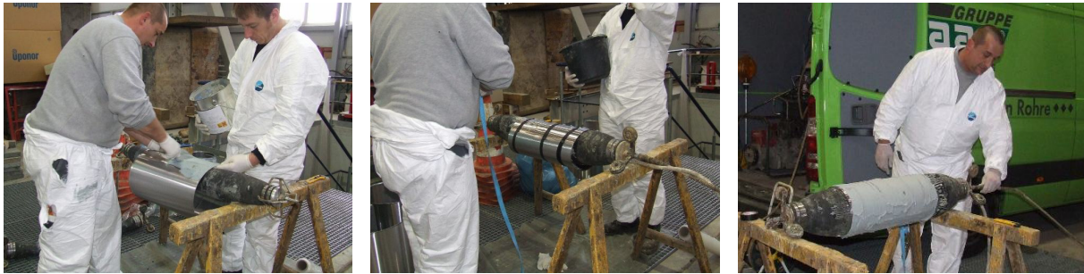
Abb. 50: Auftragen des Harzes auf die Edelstahlhülse (links), Durchmesserreduzierung der Edelstahlhülse (mittig), einbaufertige Stuttgarter Hülse (rechts)
