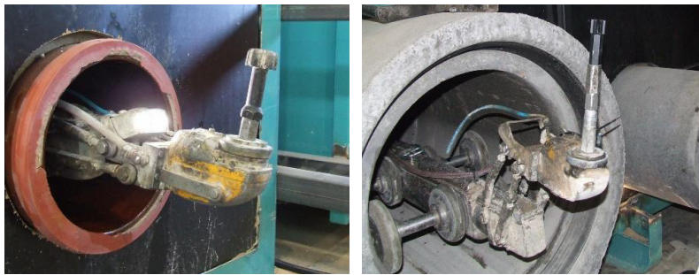
Abb. 17: Fräsroboter DN 200 mit „Fingerfräser“ (links), Fräsroboter DN 600 mit „Fingerfräser“ (rechts)
