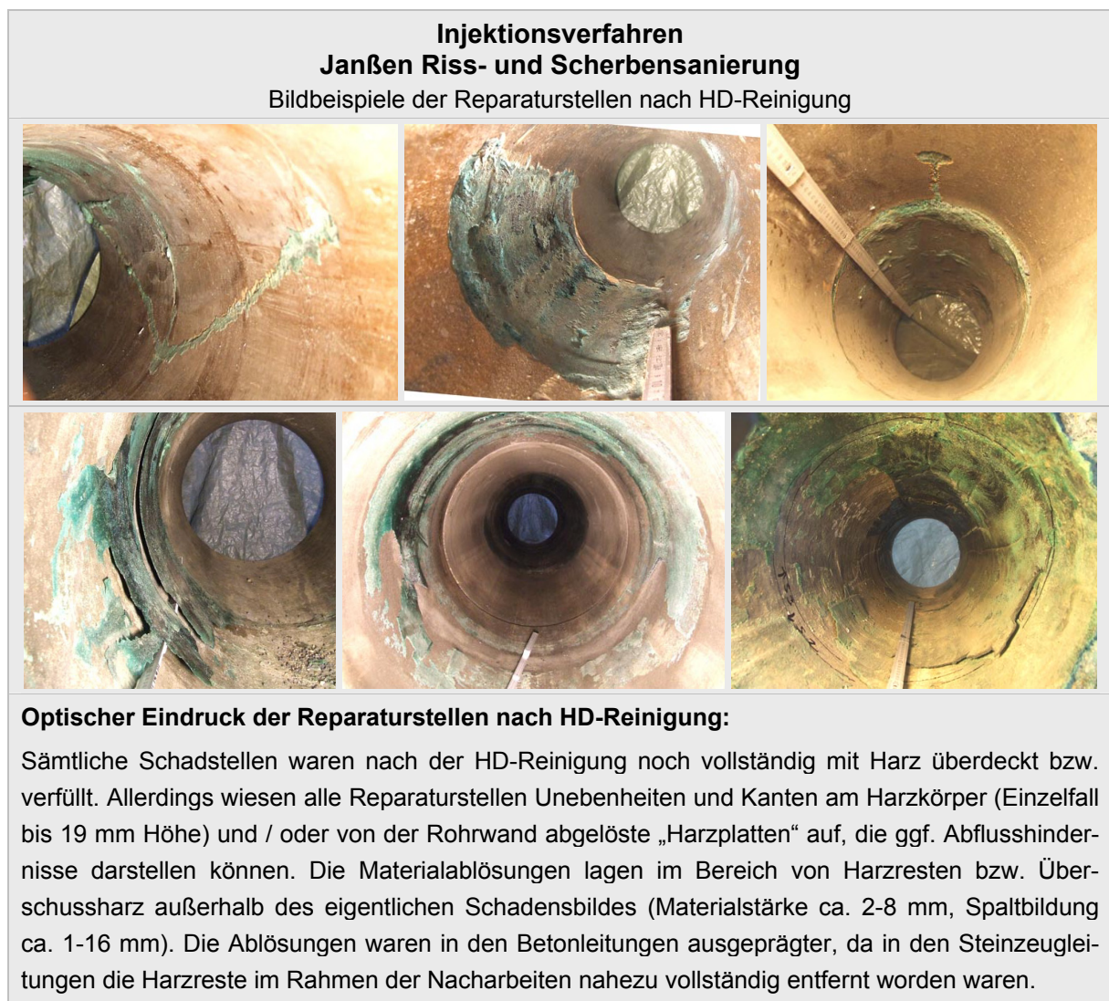
Abb. 51: Bildbeispiele und optischer Gesamteindruck - Reparaturstellen nach HD-Reinigung (Janßen Riss- und Scherbensanierung)
