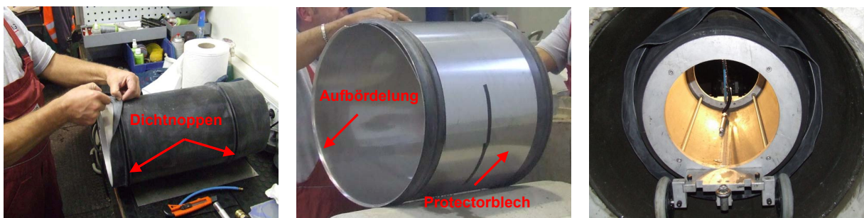
Abb. 47: Fixieren der EPDM-Gummidichtung mit Sekundenkleber (links), Manschette mit Protectorblech (mittig), Manschette auf dem Versetzpacker im Kanal (rechts)
