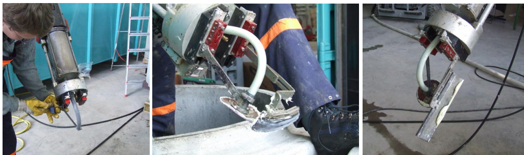
Abb. 25: Injektionsaufsatz (links), Verpressschuh mit Längsspachtel (mittig), Verpressschuh mit Radialspachtel (rechts)
