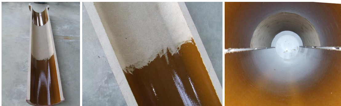
Abb. 15: Gefräste Oberfläche (links u. mittig), zusammengesetzte Rohrhalbschalen für die Sanierung (rechts)
