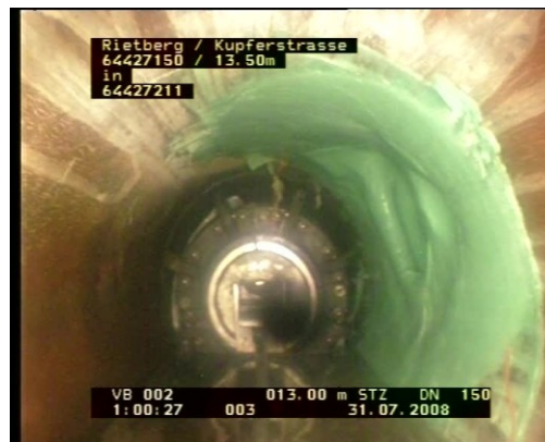
Abb. 149: Einlauf in der Kupferstraße nach der Sanierung
