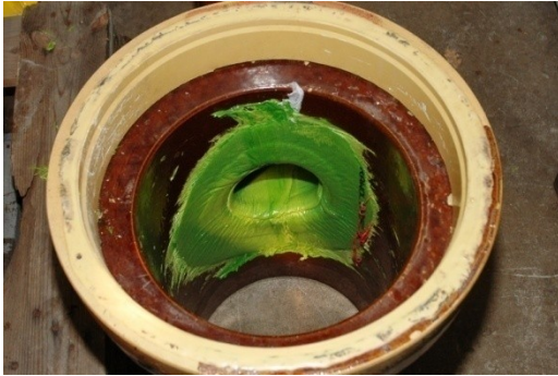
Abb. 62: Blick auf das Sanierungsergebnis am Hauptrohr des 90°-Abzweigs
