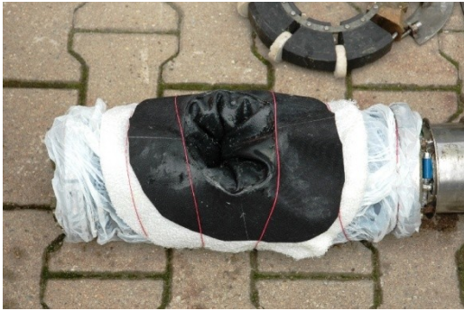
Abb. 14: Von Innen mit Gleitmittel behandeltes Gummihutprofil zusammen mit dem BRAWOLINER®-Hutprofil im Setzgerät
