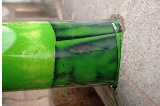
Abb. 19: Gummihutprofil und BRAWOLINER®-Hutprofil unmittelbar nach dem Inversionsvorgang, Ausbildung von Längsfalten
