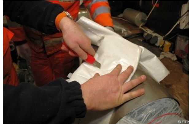
Abb. 115: V20, Einritzen der Folie am BRAWOLINER®-Hutprofil
