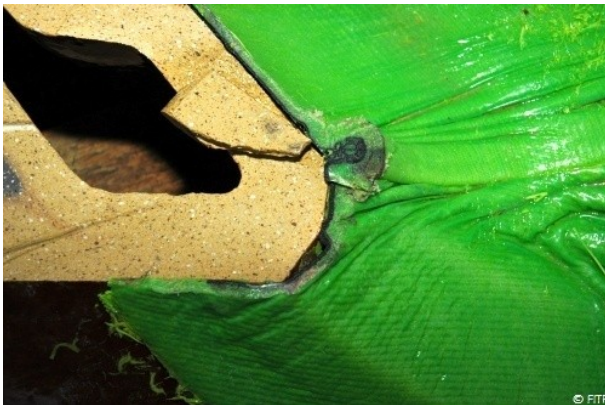
Abb. 112: V19, geringfügige Faltenbildung des Gummihutprofils im spitzen Winkel, größte Falte am Übergang von Hut und Krempe des BRAWOLINER®-Hutprofils
