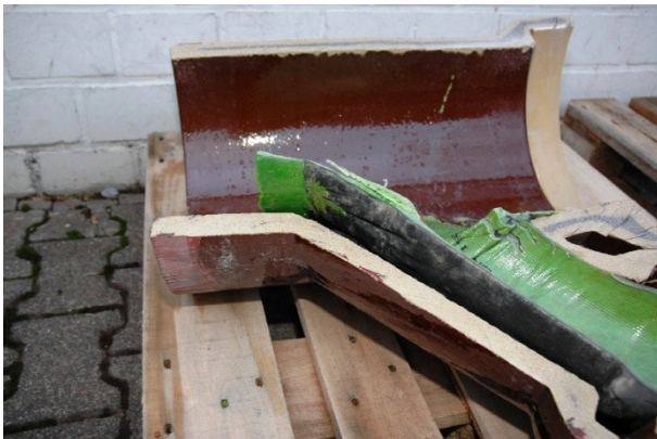
Abb. 84: V14, Schnitt 2, abgelöstes Gummihutprofil und BRAWOLINER®-Hutprofil im 45°-Abzweig, Ablösung vom Steinzeugrohr erfolgte ohne großen Kraftaufwand
