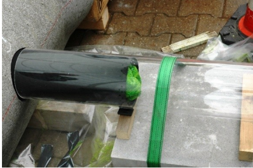
Abb. 29: Invertieren des BRAWOLINER®-Hutprofils
