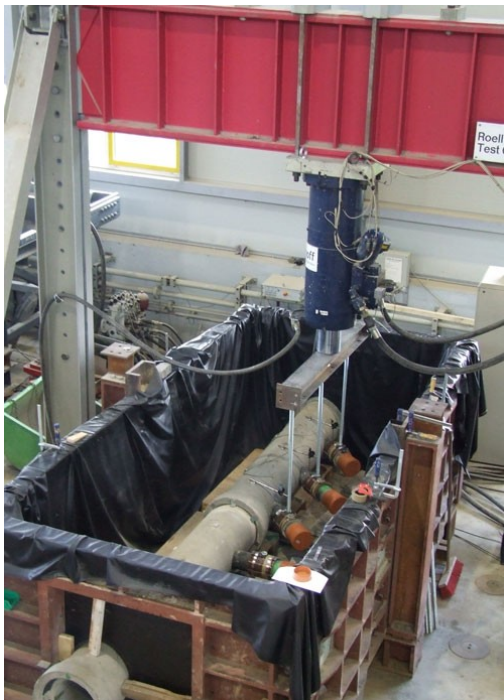
Abb. 132: Sanierte Einläufe nach Entfernen der Steinzeugrohre mit installierter Lasteinleitungskonstruktion
