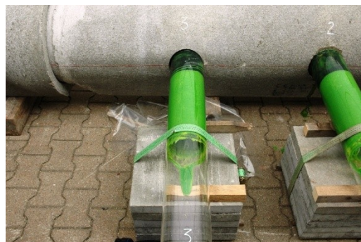
Abb. 26: Sanierungsergebnis nach der Aushärtzeit
