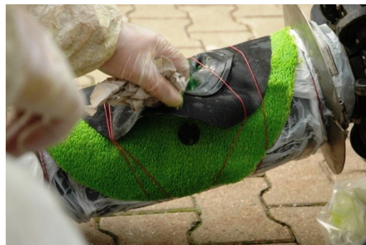
Abb. 24: Transponder zwischen BRAWOLINER®-Hutprofil und Krempe des Gummihutprofils eingelegt, am Harz selbsthaftend, Lage später am HA 12-Uhr
