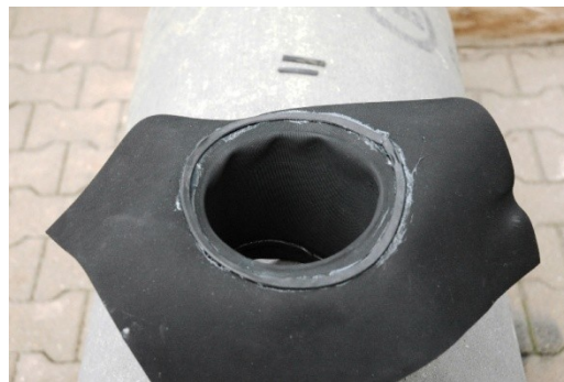
Abb. 22: Quellband an der Hutkrempe vor dem Inversionsvorgang
