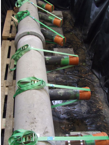
Abb. 127: Freigelegte Gummihutprofile nach dem Entfernen der Steinzeugrohre während der Dichtheitsprüfung
