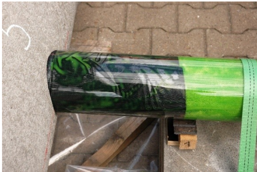
Abb. 32: Gummihutprofil unmittelbar nach dem Inversionsvorgang
