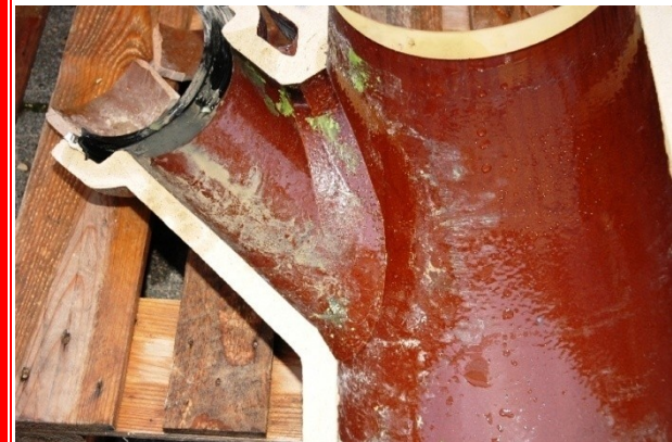
Abb. 91: Blick auf die Ausformung der Phasen am Übergang vom Abzweigrohr in das Hauptrohr
