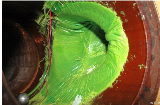
Abb. 107: V19, Sanierungsergebnis, Blick auf den stumpfen Winkel mit angefaster Fläche
