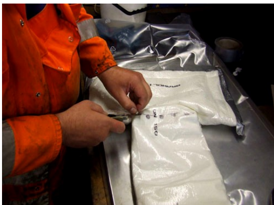
Abb. 135: Präparieren des BRAWOLINER®-Hutprofils vor dem Einharzen
