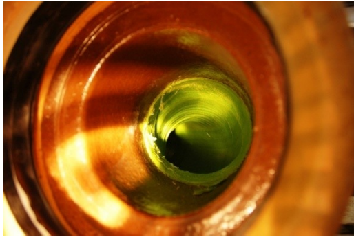
Abb. 59: Sanierungsergebnis am Ende des 45°-Bogens, Faltenbildung an der bogeninneren Seite
