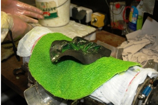
Abb. 18: Gummihutprofil in den zuvor mit Harz getränkten BRAWOLINER®-Hutprofil gesteckt und zusammen in das Setzgerät gezogen
