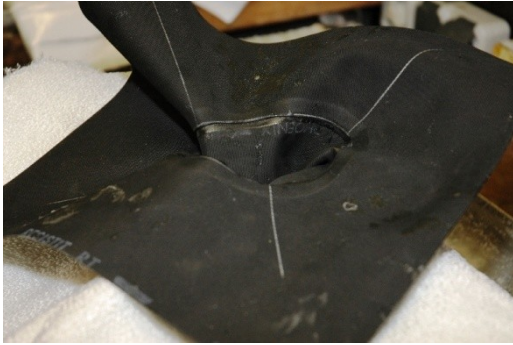
Abb. 12: Gummihutprofil seitenverkehrt in das BRAWOLINER®-Hutprofil eingeschoben und zusammen in das Setzgerät gezogen
