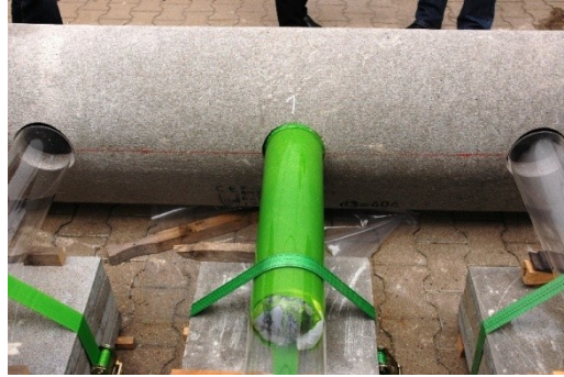
Abb. 11: Mit dem BRAWOLINER®-Hutprofil sanierter HA nach Aushärtzeit des Harzes
