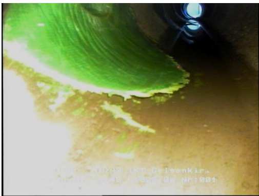
Abb. 44: Im Sohlbereich gelöste Hutkrempe des Stutzens V6
