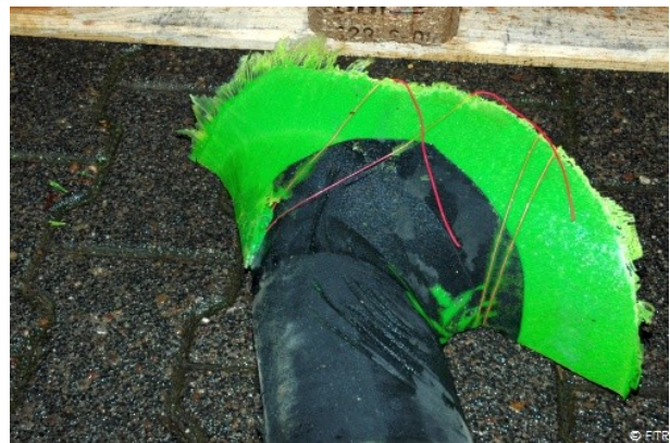
Abb. 105: V18, Blick auf die Krempe von BRAWOLINER®-Hutprofil und Gummihutprofil
