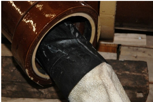
Abb. 51: Gummihutprofil 2 nach optimierter Faltung beim Einziehen in das Setzgerät erfolgreich in den 45°-Abzweig invertiert
