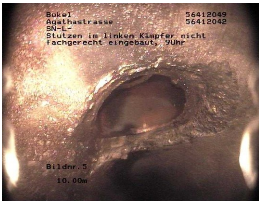
Abb. 152: Einlauf in der Agaathastraße vor der Sanierung
