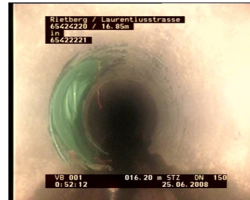
Abb. 151: Einlauf in der Laurentiusstraße nach der Sanierung
