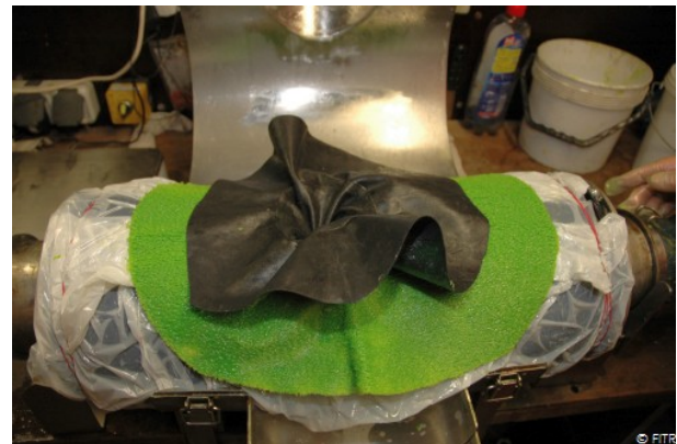
Abb. 93: V18, BRAWOLINER®-Hutprofil und Gummihutprofil nach dem Zuschnitt
