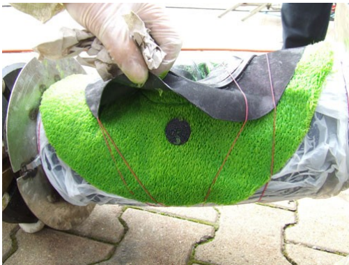
Abb. 46: Fixierung eines Transponders zwischen BRAWOLINER®-Hutprofil und Gummihutprofil
