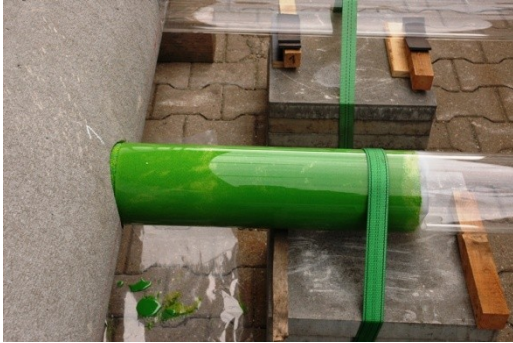
Abb. 10: Mit dem BRAWOLINER®-Hutprofil sanierter HA unmittelbar nach dem Inversieren
