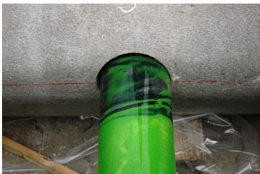
Abb. 25: Ergebnis des Inversionsvorganges, Bildung von Querfalten durch das Quellband am Ende des Hutzyinders
