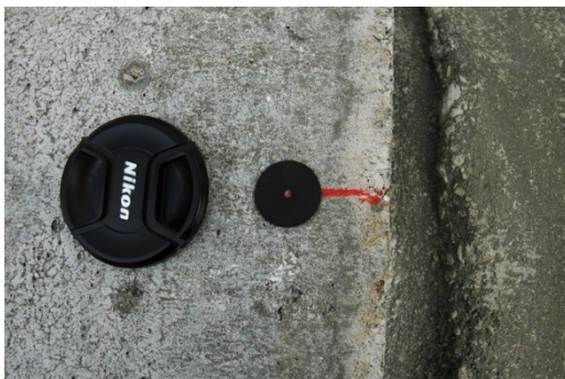
Abb. 23: Transponder zur Speicherung z. B. von betreiberspezifischer Daten über den HA
