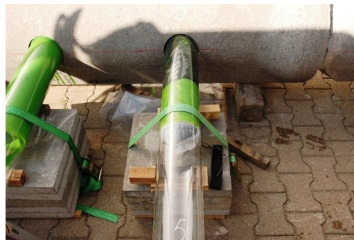
Abb. 35: Gummihutprofil und BRAWOLINER® nach Abschluss der Sanierung
