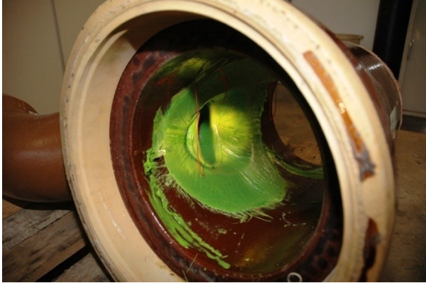
Abb. 70: V14, Sanierungsergebnis im Hauptrohr mit Blick auf den 45°-Abzweig
