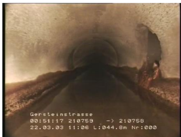
Abbildung 13: Schadenssituation im Hauptkanal (links) und im Bereich des Hausanschlusstutzens mit Blick in den Anschlusskanal (rechts)
