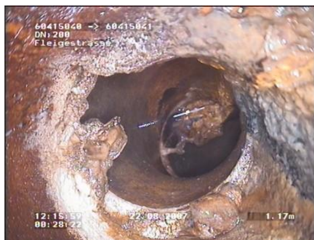
Abbildung 3: Schadenssituation im Hauptkanal (links) und im Bereich des Hausanschlussstutzens mit Blick in den Anschlusskanal (rechts)
