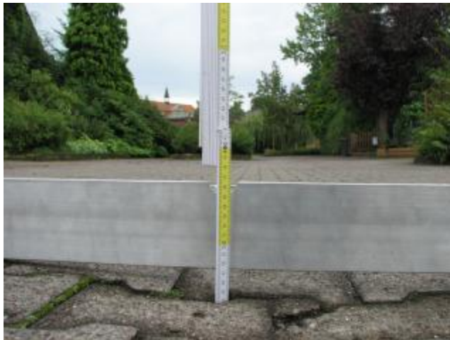
Abbildung 15: Fahrbahnschaden: Muldenartige Verformung, offene Pflasterfuge, zerbrochene Pflastersteine
