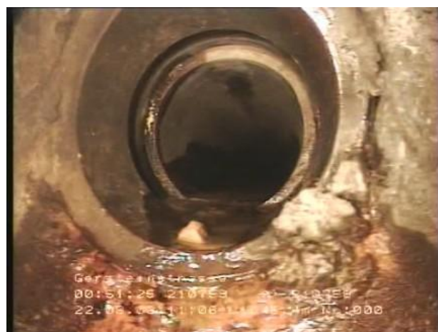
Abbildung 13: Schadenssituation im Hauptkanal (links) und im Bereich des Hausanschlusstutzens mit Blick in den Anschlusskanal (rechts)
