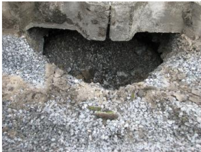
Abbildung 19: Verspannte Pflasterschicht überbrückt den entstandenen Hohlraum oberhalb des Sackungstrichters
