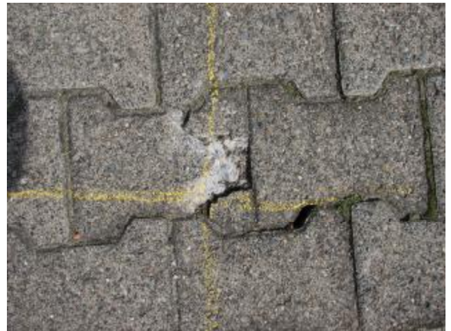
Abbildung 15: Fahrbahnschaden: Muldenartige Verformung, offene Pflasterfuge, zerbrochene Pflastersteine
