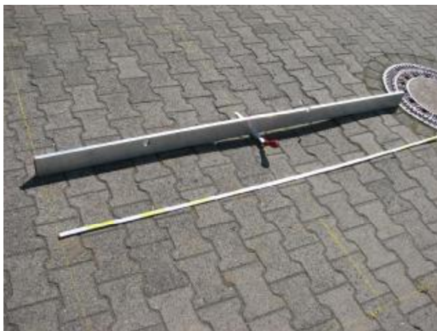
Abbildung 25: Fahrbahnschaden: Muldenartige Verformung, gerissene Pflastersteine
