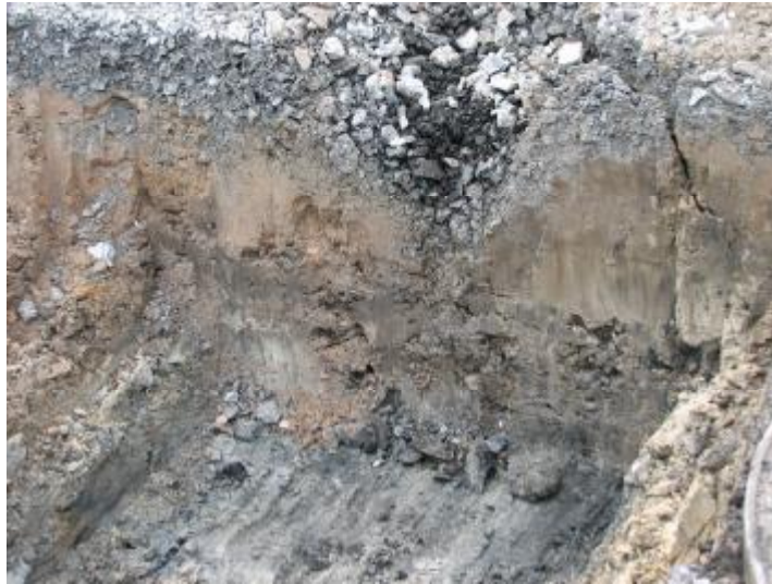
Abbildung 11: Seitlich freigelegter Sackungstrichter in der Tragschicht ohne Bindemittel
