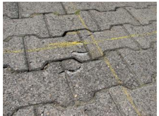
Abbildung 25: Fahrbahnschaden: Muldenartige Verformung, gerissene Pflastersteine
