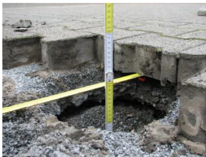
Abbildung 19: Verspannte Pflasterschicht überbrückt den entstandenen Hohlraum oberhalb des Sackungstrichters
