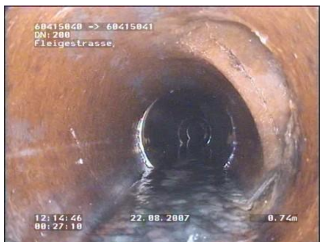
Abbildung 3: Schadenssituation im Hauptkanal (links) und im Bereich des Hausanschlussstutzens mit Blick in den Anschlusskanal (rechts)
