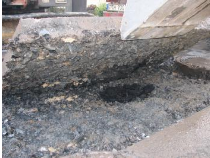
Abbildung 9: Oberfläche der Tragschicht ohne Bindemittel nach Entfernen der Asphaltbefestigung
