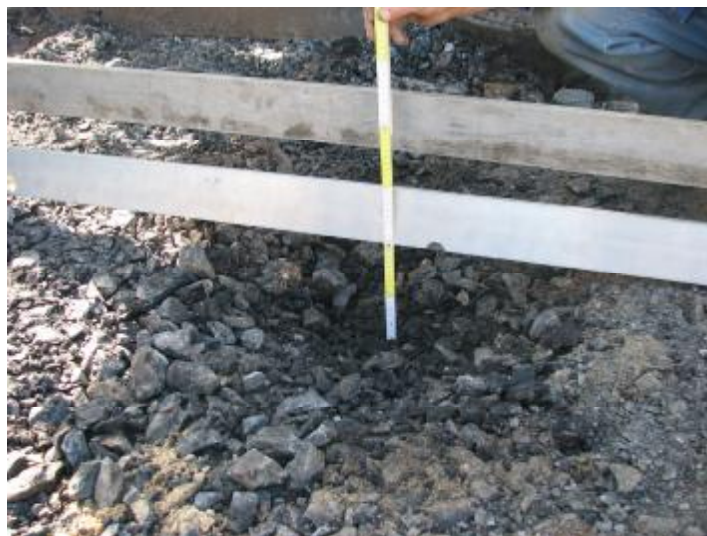
Abbildung 10: Sackungstrichter an der Oberfläche der Tragschicht ohne Bindemittel
