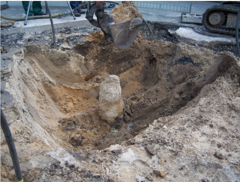
Teilweise freigelegter Injektionskörper (IP5)
