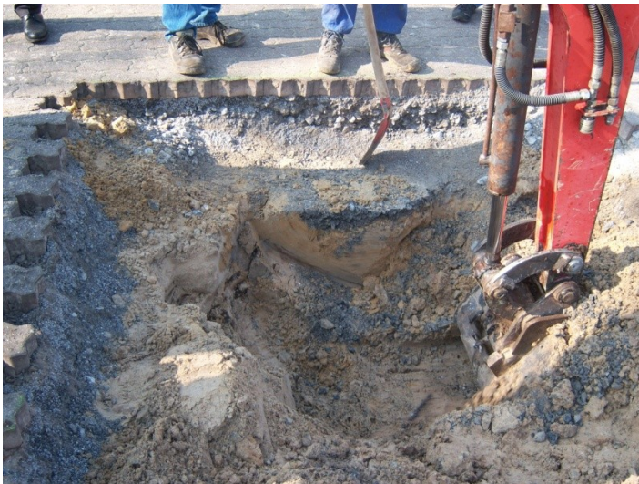
Geschnittener Injektionskörper (IP4)
