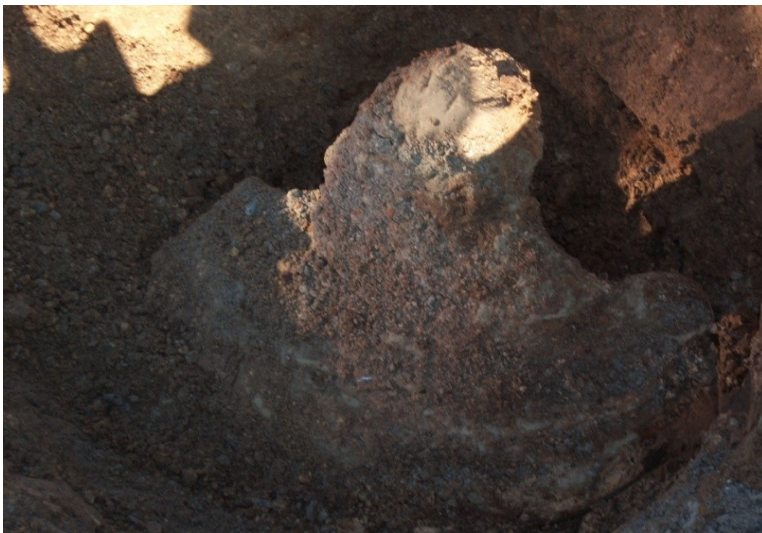
Freigelegter Injektionskörper (IP2)
