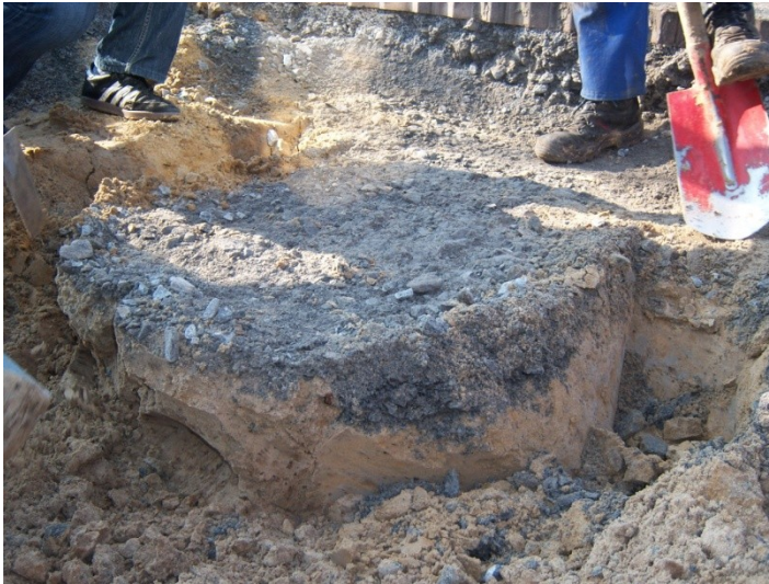
Freigelegter Injektionskörper (IP4)
