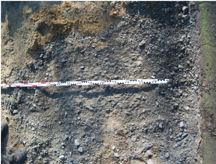
Aufsicht Injektionskörper (IP4)
