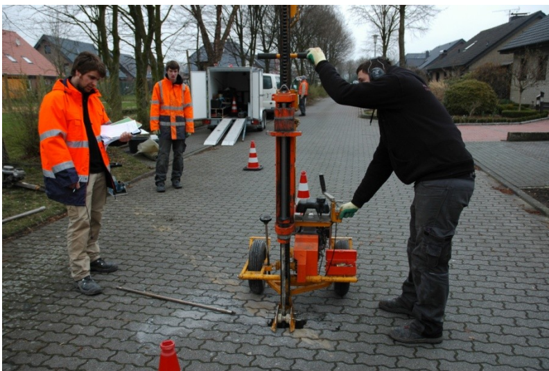
leichte Rammsondierung (DPL), Finkenstraße 17 (IP 3)
