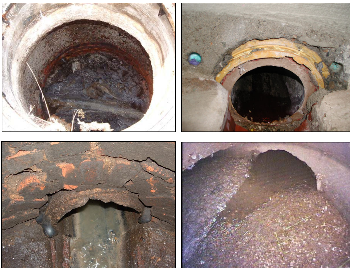
Bild 4.15: Beispiele für Schachtgerinne im bestehenden Kanalnetz [Puhl 2007]
