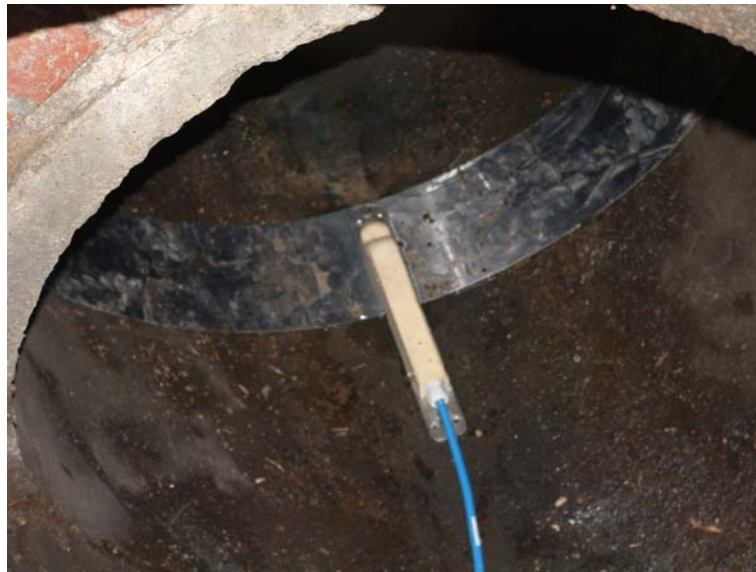
Bild 3.8: Ultraschall-Doppler-Messung / Korrelationsverfahren am Beispiel des PCM Pro der Fa. Nivus AG
