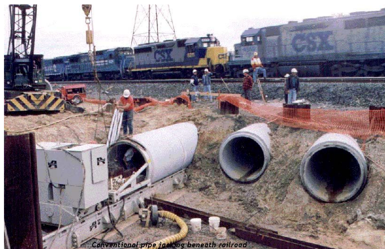
Bild 1-1 Beispiele für flach überdeckte Rohre und / oder hohe Belastungen: Durchlass, Container-terminal, Baufahrzeug über GFK-Rohr, Betonrohre unter Eisenbahnverkehrslasten
