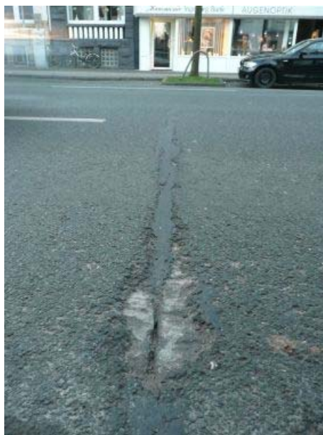
Bild 6-14a) Praxisbeispiele für den Lastfall Kantenpressung, Querrisse im Straßenoberbau und Übergang zwischen unterschiedlichen Fahrbahnaufbauten
