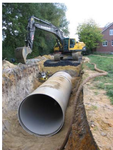
Bild 1-1 Beispiele für flach überdeckte Rohre und / oder hohe Belastungen: Durchlass, Container-terminal, Baufahrzeug über GFK-Rohr, Betonrohre unter Eisenbahnverkehrslasten
