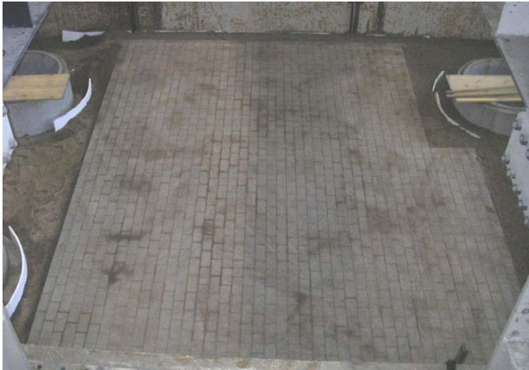
Bild 3-5 Fertiggestellte Pflasterfläche im IKT-Großversuchsstand
