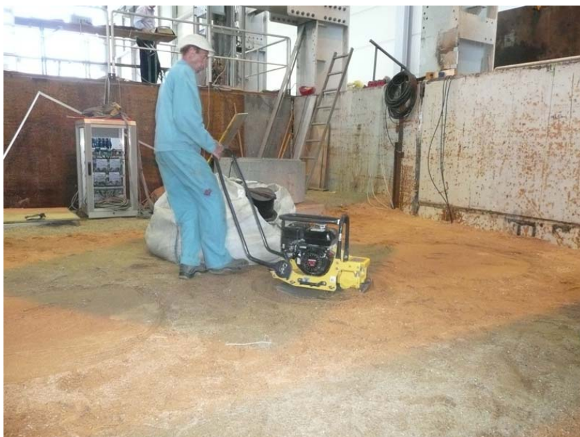
Bild 6-37 Dynamische Belastung infolge Vibrationsverdichter
