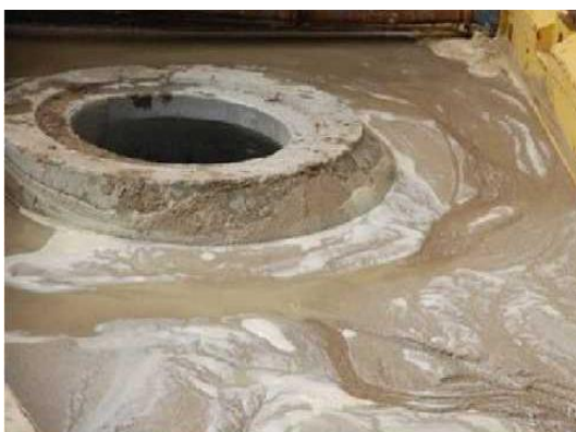
BILD 7: SUSPENSIONSSPIEGEL NACH VERFÜLLEN DES VERBAUTEN GRABENS
