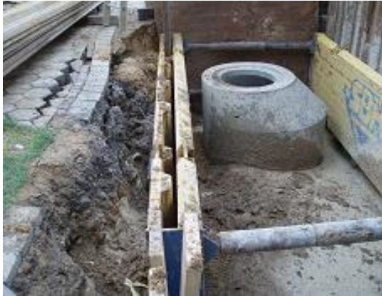
BILD 8: SUSPENSIONSSPIEGEL NACH RÜCKBAU DER DIELEN DES KAMMERDIELENVERBAUS
