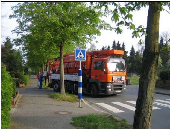
Abb. 22:Reinigung des Schmutzwasserkanals DN 250 vor dem Einsatz der Lindauer Mini-Schere.
