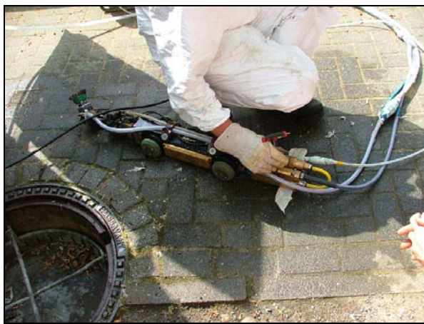
Abb. 13: Pneumatisch betriebener Fräsroboter der Fa. JT-Elektronik mit Topfbürste als Fräswerkzeug (Gesamtansicht)
