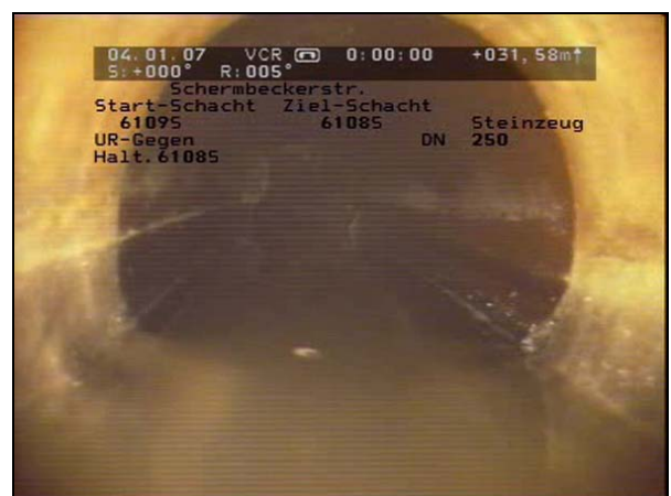
Abb. 10: Wurzeleinwuchs in einem Riss im Hauptkanal (Haltung 6109S – 6108A, 33,13 m). Einzelne Wurzeln sind durch den Spalt zwischen den Scherben des Steinzeugrohres eingewachsen.
