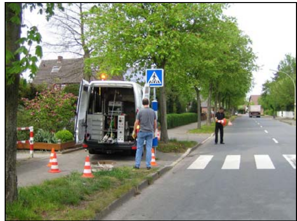
Abb. 23:Einrichten der Baustelle für die Inspektion der Grundstücksentwässerleitungen aus dem Schmutzwasserkanal DN 250
