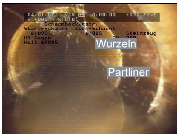
Abb. 9: Wurzeleinwuchs durch eine Rohrverbindung des Hauptkanals. Die Wurzeln haben ein Polster gebildet, das im Hauptkanal ein Abflusshindernis bildet. (Haltung 6109S - 61080S, 15,71 m).
