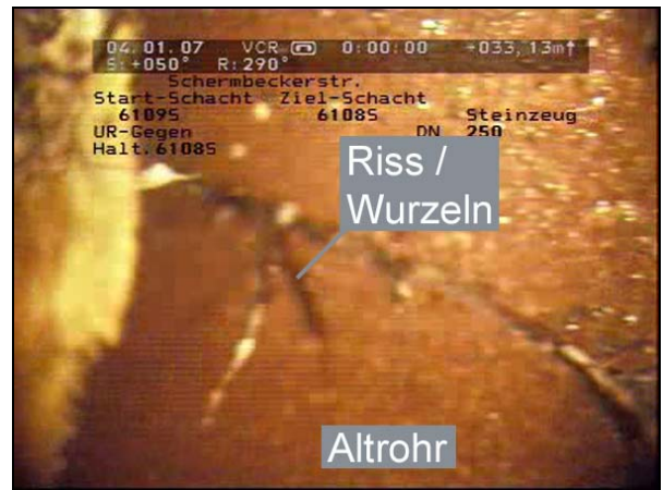
Abb. 10: Wurzeleinwuchs in einem Riss im Hauptkanal (Haltung 6109S – 6108A, 33,13 m). Einzelne Wurzeln sind durch den Spalt zwischen den Scherben des Steinzeugrohres eingewachsen.
