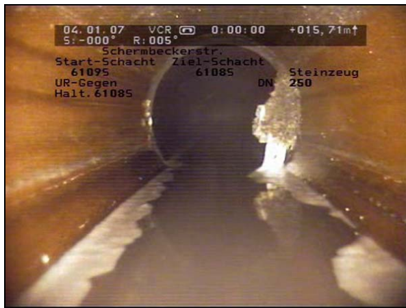
Abb. 9: Wurzeleinwuchs durch eine Rohrverbindung des Hauptkanals. Die Wurzeln haben ein Polster gebildet, das im Hauptkanal ein Abflusshindernis bildet. (Haltung 6109S - 61080S, 15,71 m).
