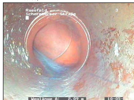
Abb. 36: Werkstoffwechsel in der Leitung mit der laufenden Nr. 3. Hier wurde bereits ein Teil der Grundstücksentwässerungsleitung erneuert.
