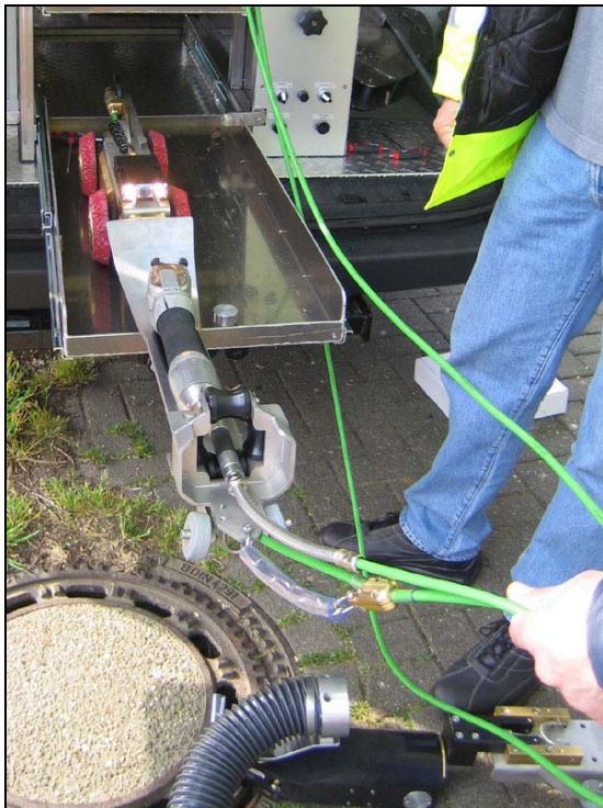
Abb. 24:Lindauer Mini-Schere mit ASYS und Positionierungssystem SPE (unten rechts dargestellt) vor dem Einsatz.
