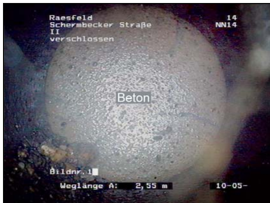
Abb. 31: Verschluss der unbenutzten Anschlüssen mit Beton.
