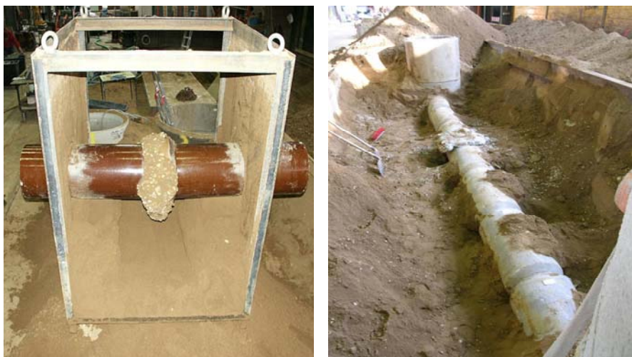
Abbildung 5-1: Sanierte Einzelrohrverbindung (links) und sanierte Teststrecke (rechts)
