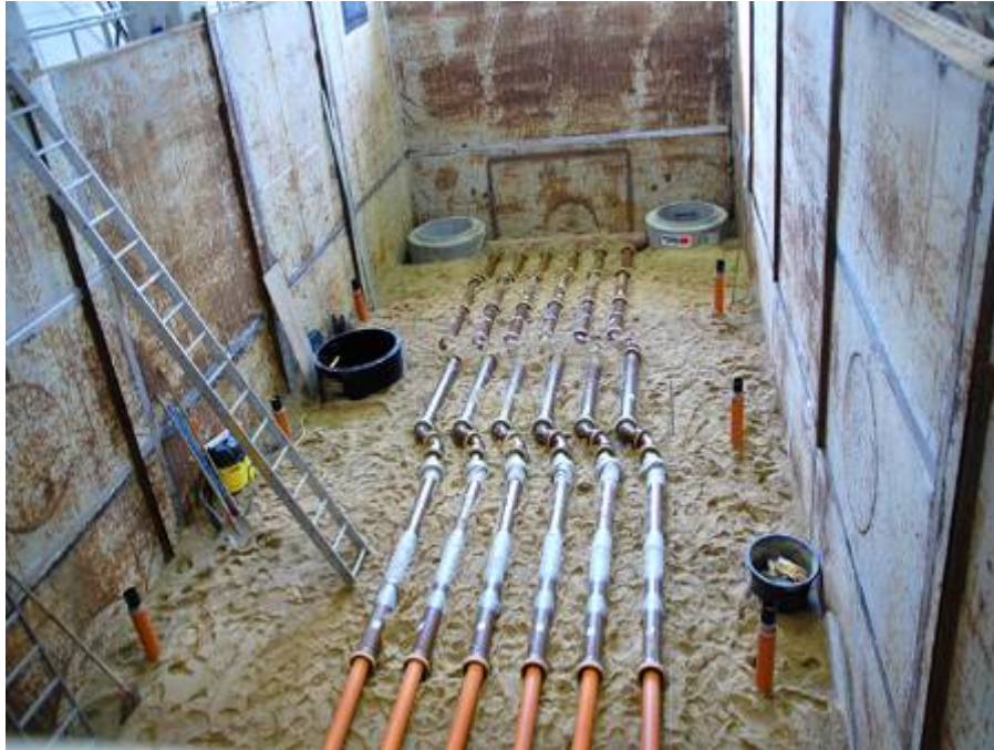
Abbildung 4: Tiefste Rohrlage vor der Überschüttung, Überschüttungshöhe 5 m
