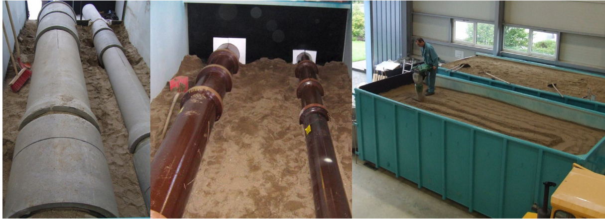
Abb. 1: Teststreckenaufbau für die Injektions- und Spachtel-/Verpressverfahren
