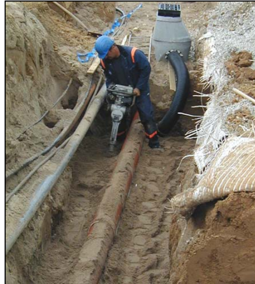
b) Verdichtung mittels Motorstampfer
