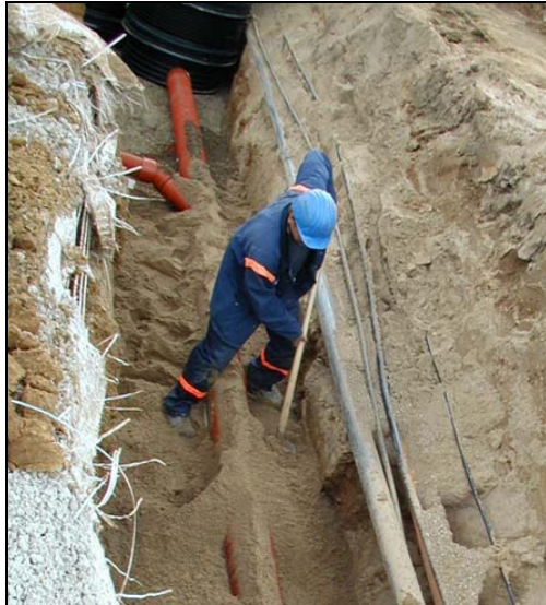
a) Verteilen des Bodens mittels Schaufel
