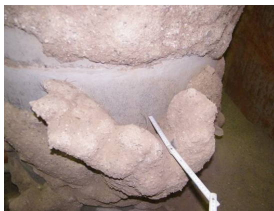
Bild 5 Polyurethan-Injektionskörper an der Schachtaußenseite (links), Detailaufnahme (rechts)
