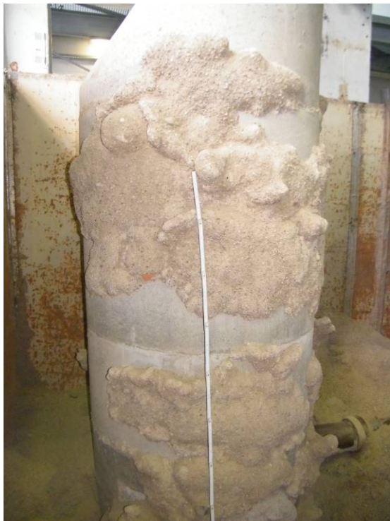
Bild 5 Polyurethan-Injektionskörper an der Schachtaußenseite (links), Detailaufnahme (rechts)
