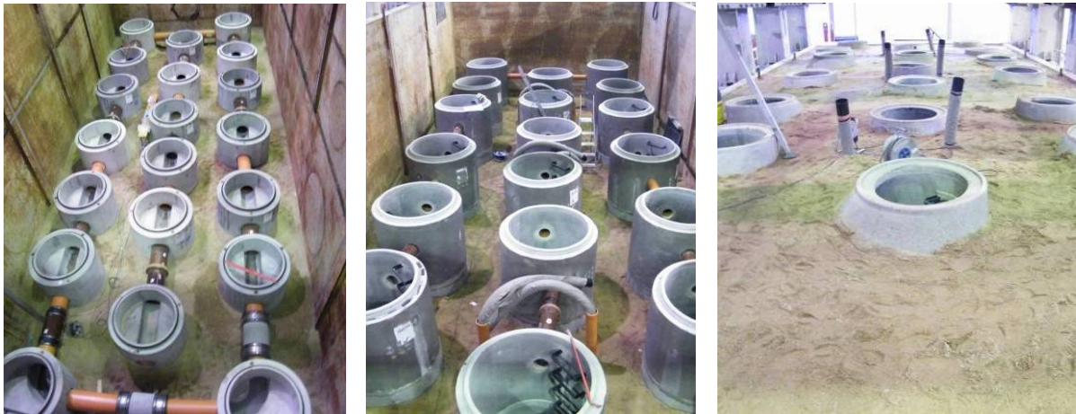
Bild 2 Einbau der Schächte im Großversuchsstand: Untere Rohrlage DN 300 (links); Mittlere Rohrlage DN 150 (mitte); Fertiggestellter Einbau (rechts)
