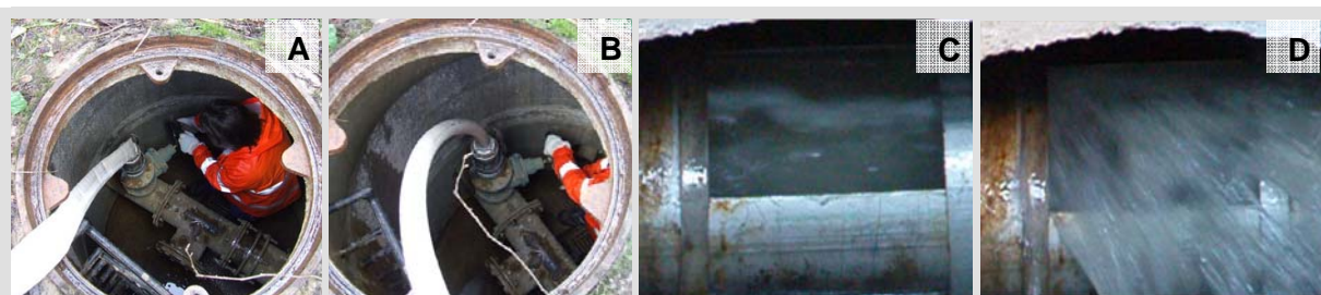
Abb. 6: Bildbeispiel Praxiseinsatz Impuls-Spül-Verfahren: A Druckluftschlauch zwischen den impulsartigen Druckluftzugaben; B Druckluftschlauch während der Druckluftzugaben; C Normalabfluss in einer Leitung und D Spülschwallaustritt unter Druckluftzugaben
