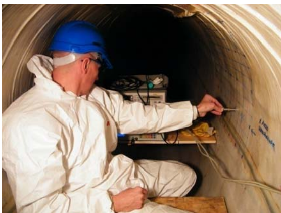
a) Messung im Kanal (IBMT)
