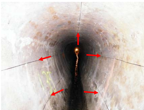
a) Installierte Messkabel am Altrohr Abb. 4: Baubegleitende Temperaturmessung (OSSCAD, Bergisch Gladbach)
