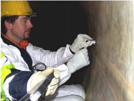
a) Messung im Kanal
