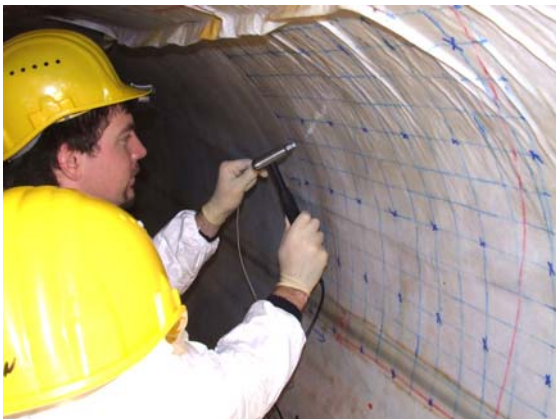
a) Messung im Kanal
