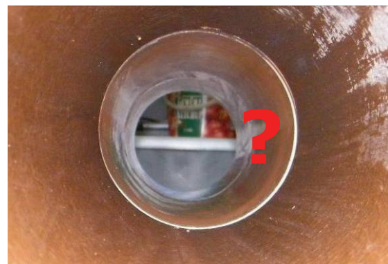
Abb. 54: Werkstoffwechsel von Steinzeugrohr auf PVC-Rohr; Außenansicht (links) und Innenansicht, bei der das Bauteil nicht sichtbar ist (rechts)
