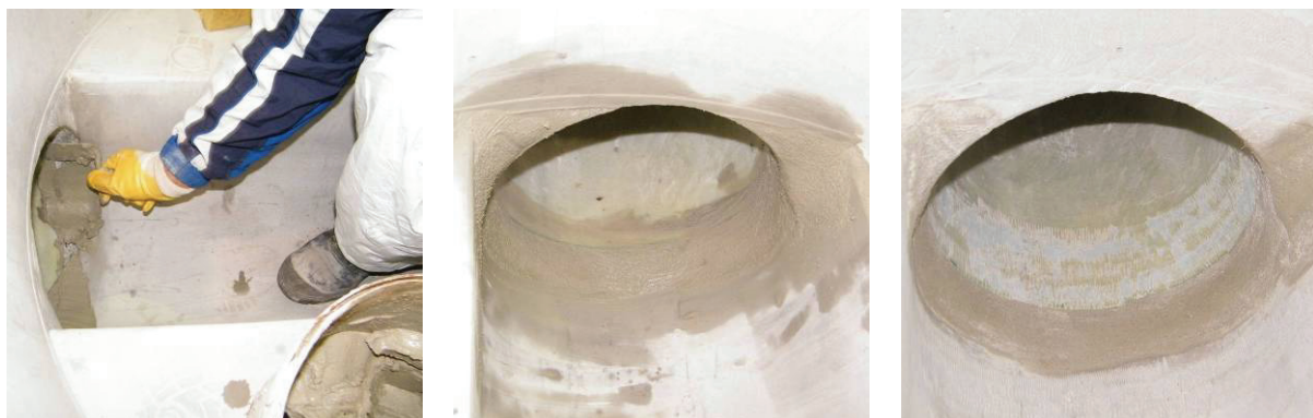
Abb. 42: Untergrundvorbereitung für die Handlaminat; Auftragen einer Ausgleichsschicht Mörtel (links); komplett angeglichoener Anbindungsbereich (mittig); aufgeraute Schlauchlineroberfläche (rechts)
