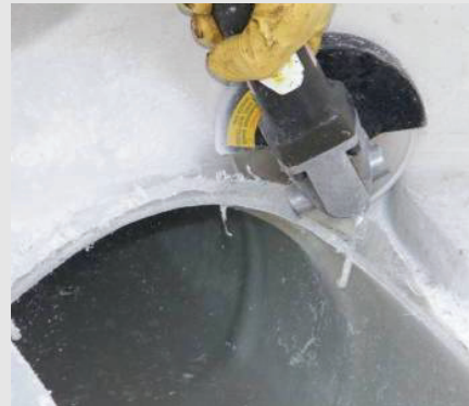
Freischneiden des Schachtgerinnes
