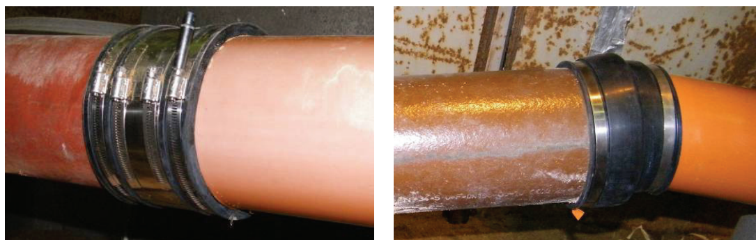
Abb. 31: Untersuchte Manschettdichtung (links) und Kupplung (rechts)
