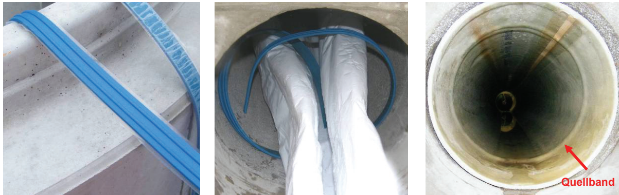
Abb. 37: Eingesetztes Quellband an einer Anbindung - Rechteckprofil mit zwei Höckern (links); Preliner mit Quellband umwickelt vor Einbau des Schlauchliners (mittig); Quellband unter dem ausgehärteten Schlauchliner (rechts)
