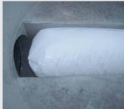
Invertieren des Preliners mit Luftdruck
