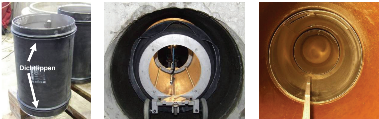
Abb. 19: Innenmanschette mit Gummi-Ummantelung vor dem Einbau (links); Innenmanschette auf dem Versetzpacker (Mitte); eingebaute Innenmanschette (rechts)
