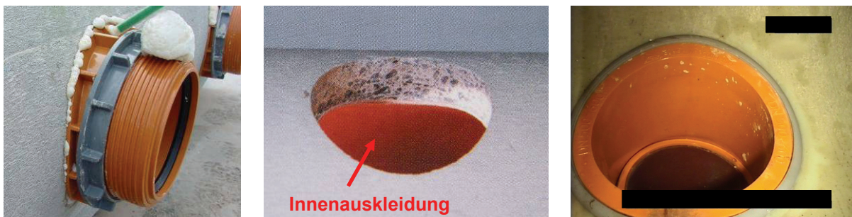
Abb. 7: Außenansicht eines Stutzensystems für Kanäle mit Innenauskleidung (links); erstelltes Bohrloch für den Einbau in den Kanal mit Innenauskleidung (Mitte) [28]; Innenansicht eines Stutzensystems für Kanäle mit Innenauskleidung (rechts)
