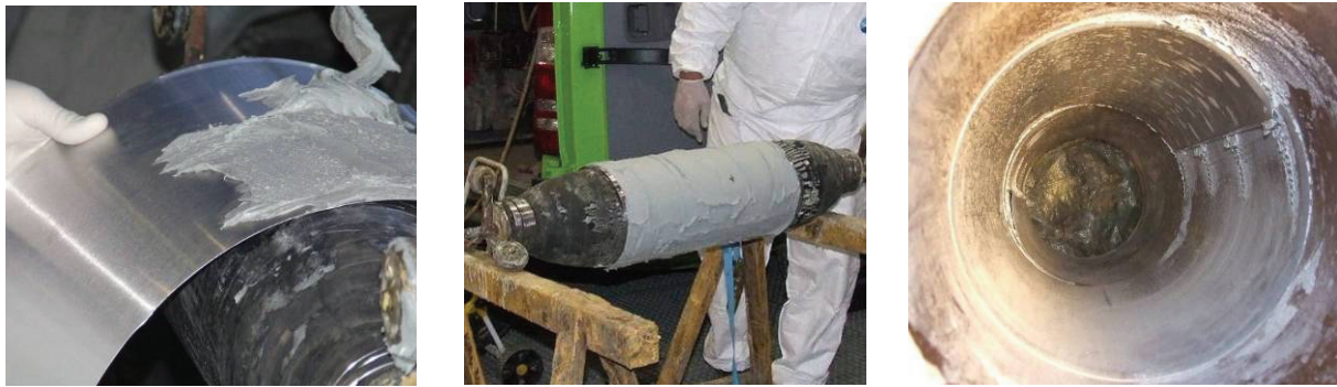
Abb. 20: Beschichten einer Edelstahlmanschette mit Reaktionsharz (links); vollständig vorbereitete Innenmanschette auf dem Versetzpacker (Mitte); im Kanal installierte Innenmanschette (rechts)
