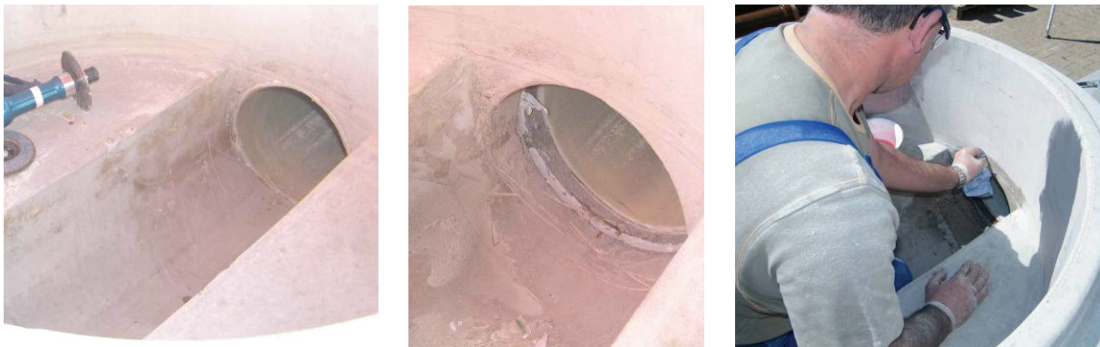
Abb. 44: Ausgangszustand mit ca. 1 cm in den Schacht einragendem Linerende (links); Linerende bis über die Schachtanschlussmuffe zurückgeschnitten (Mitte); Auftragen der Haftbrücke (rechts)
