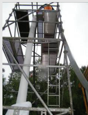
Invertieren des Schlauches
