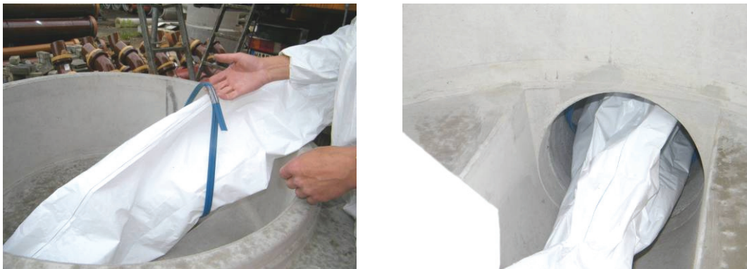
Abb. 38: Positionierung des Quellbandes um den Preliner vor Einbau des Liners (links); in der Haltung eingelegtes Quellband – Abstand zum Schacht ca. 20 cm (rechts)
