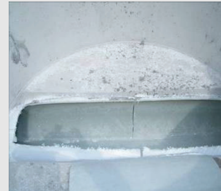
Ansicht des geöffneten Schachtgerinne
