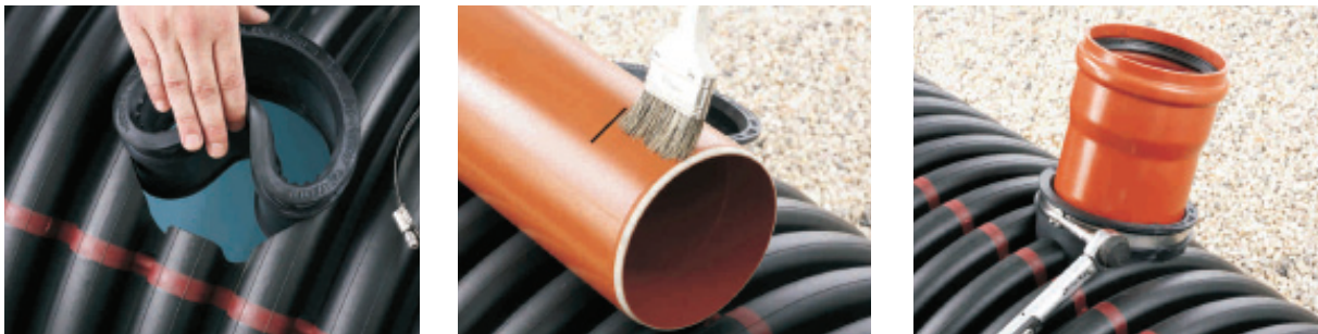
Abb. 9: Einlegen der Anschlussdichtung (links); Einfetten des Rohrendes (Mitte); Montage des Spannbandes mit Drehmomentschlüssel (rechts) [29]
