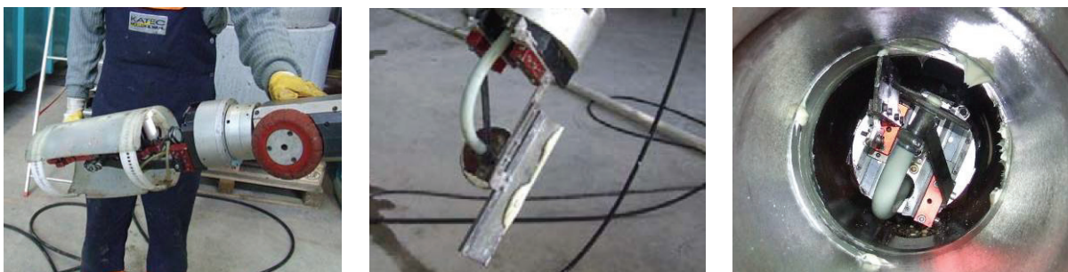
Abb. 22: Setzgerät mit Schalungsmanschette (links); Verpressschuh mit Radialspachtel (Mitte); Sanierungsroboter beim Verspachteln im Rohr (rechts) [38]
