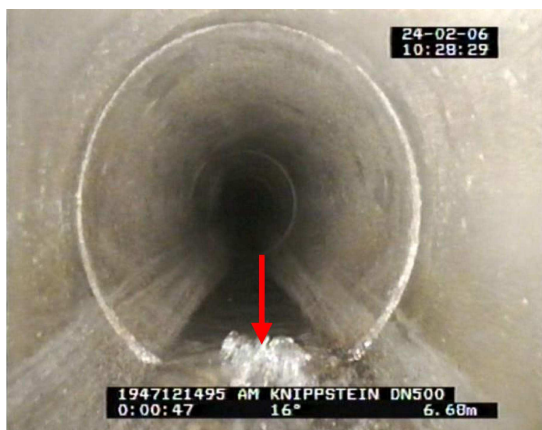
Bild 126: Links: undichte Rohrverbindung in der Sohle; rechts: undichte Rohrverbindung im Scheitel (253)
