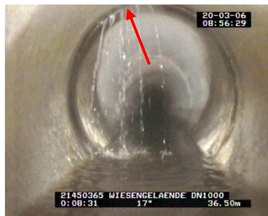
Bild 126: Links: undichte Rohrverbindung in der Sohle; rechts: undichte Rohrverbindung im Scheitel (253)
