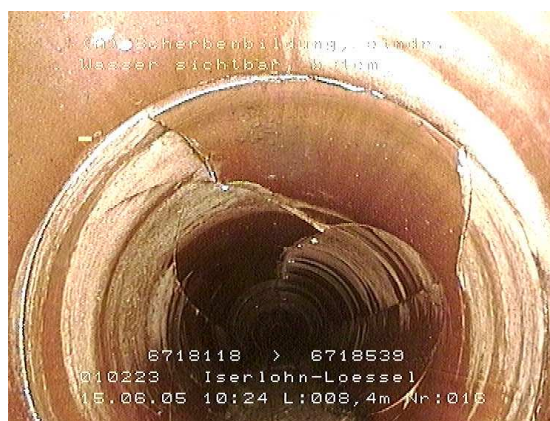
Bild 74: Deformierter Kanal (307)
