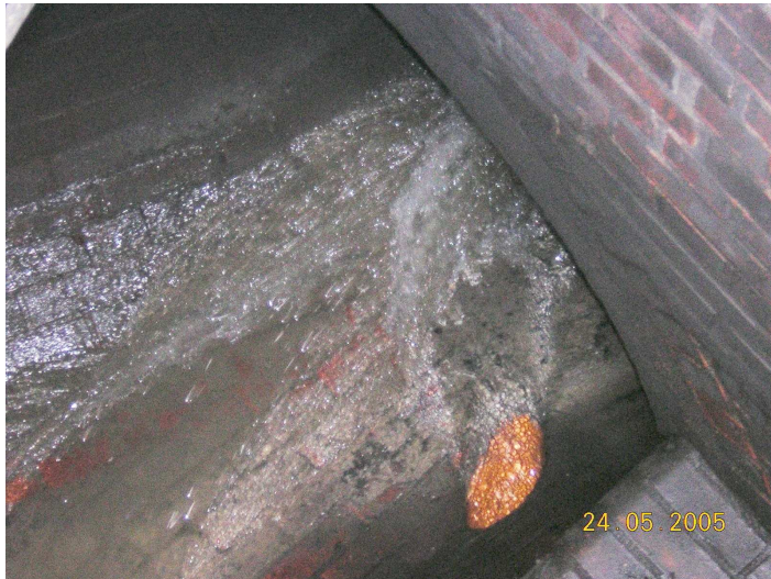
Bild 50: Baudranage in Schacht 74240 (176)
