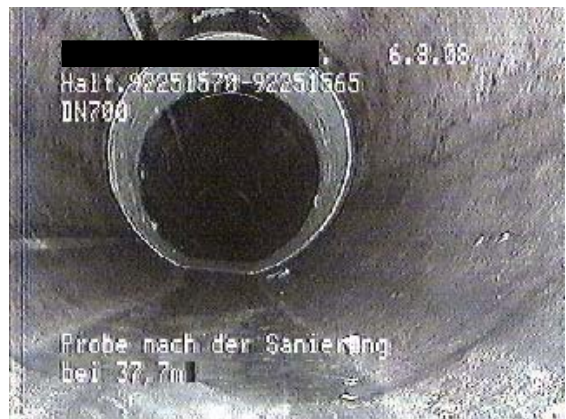
f) Reparatur der Entnahmestelle mit einem GFK-Kurzliner
