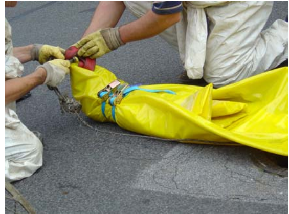
d) Vorbereiten des Schlauchs zum Einzug
