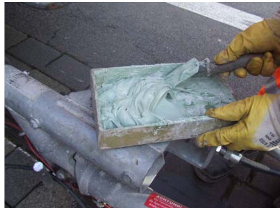
d) Anmischen eines zwei Komponenten Epoxid-Harzes zur Reparatur
