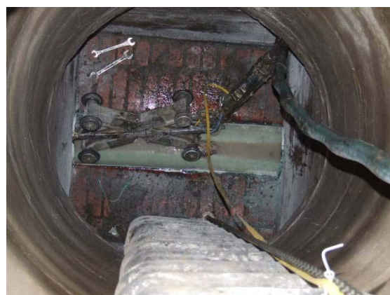
h) Entnahme einer Haltungsprobe, Fräsroboter im Kanal
