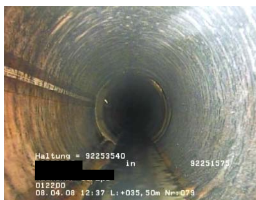
d) Fleckenartige Verfärbungen, Ansicht Querschnitt
