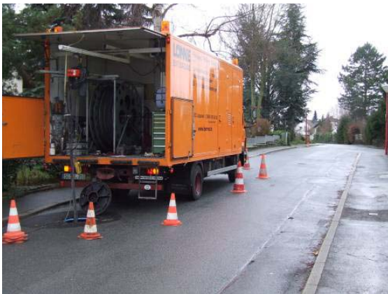
c) Fräsarbeiten zur Probenentnahme, Ansicht von der Straßenoberfläche
