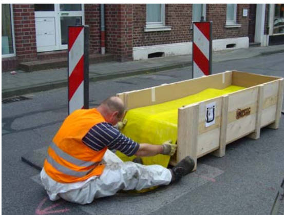
e) Einzug des Schlauchliners
