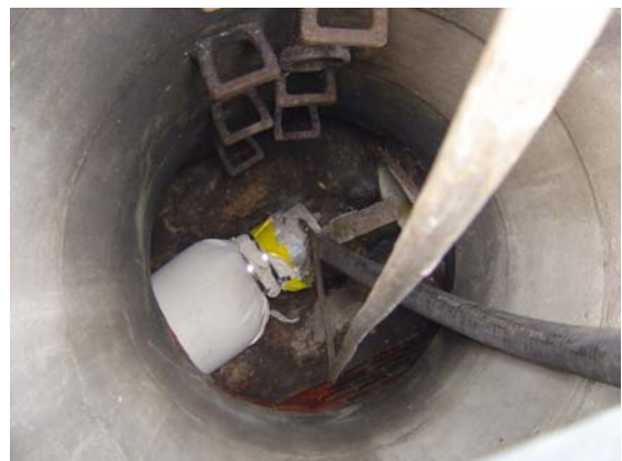
f) Aufstellen des Liners mit Luftdruck
