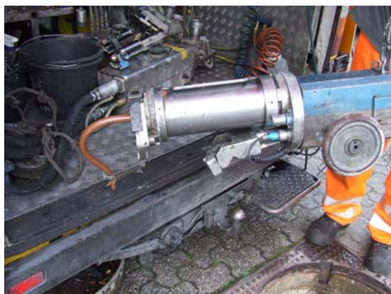
d) Kartusche am Kanalroboter zum Verpressen des Harzes in die Schalung
