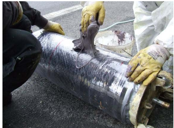
d) Reparatur der Entnahmestelle mittels Packer und Epoxid-Harz
