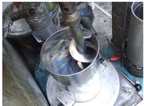
d) Anmischen des Verpressharzes, Zwei-Komponenten Epoxid-Harz
