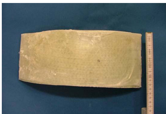
b) Außenseite der Materialprobe aus der Bauabnahme (DN 500, ein Liner)
