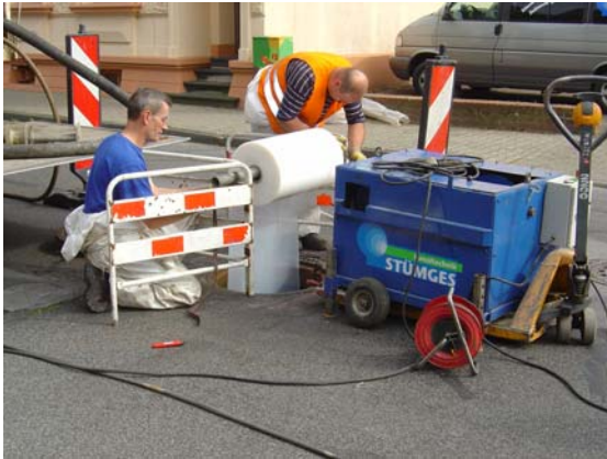
c) Einzug der Schutzfolie
