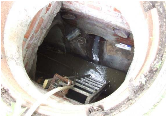
a) Probenentnahme aus der Haltung im begehbaren Bereich
