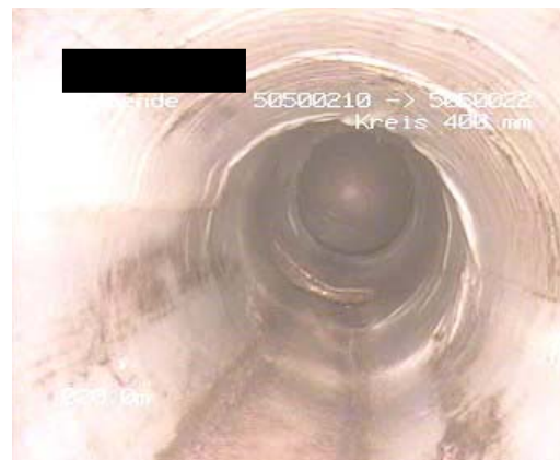
b) Wellige Oberflächenstruktur im Scheitel
