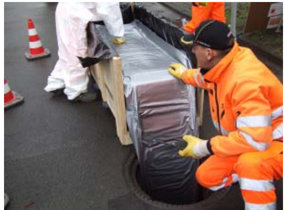
b) Einzug des Schlauchliners
