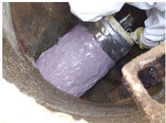
f) Einschieben des Packers in die Haltung zur Reparatur der Entnahmestelle
