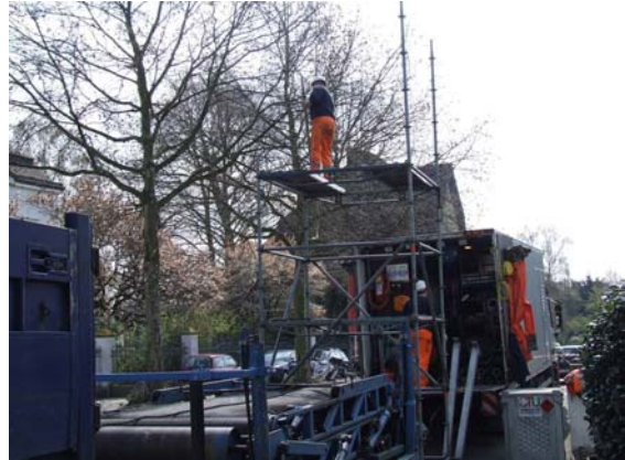
b) Aufbau des Inversionsturms
