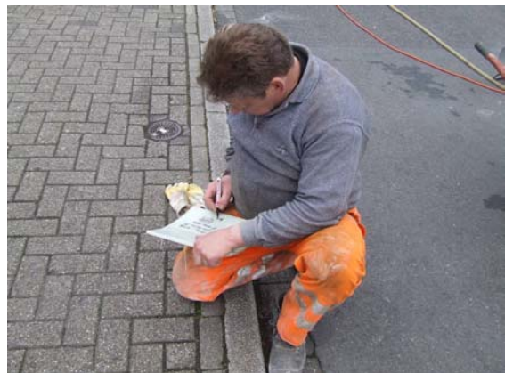
f) Beschriftung einer Baustellenprobe
