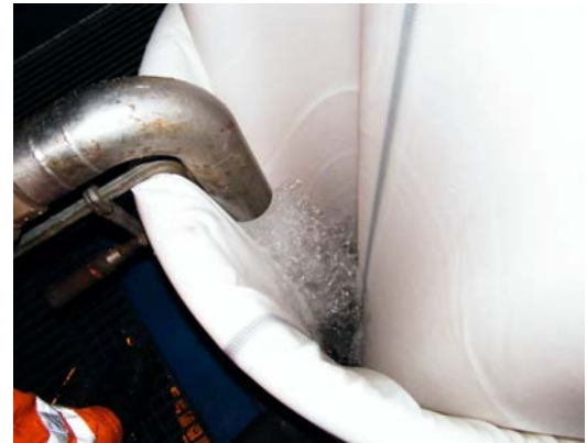
f) Inversion des Liners mit Wasserdruck
