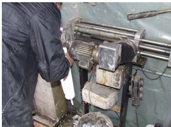
d) Anmischen der Verspachtelmasse, Zwei Komponenten Epoxid-Harz
