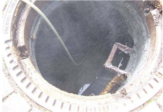
b) Staubbildung bei Probenentnahme aus der Haltung
