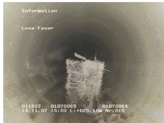
b) Ablösungen der Faserschicht, Ansicht 2
