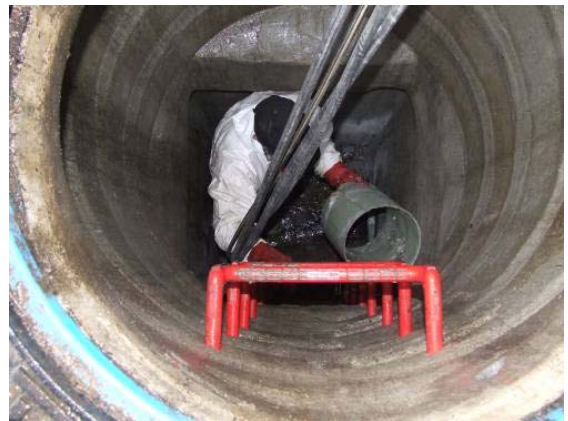
d) Entnahme des Probekörpers nach erfolgter Fräsung mit dem Roboter
