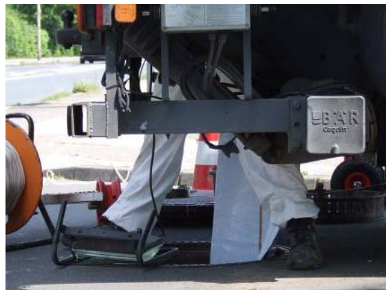
d) Einziehen des Schlauchliners, Ansicht Startschacht
