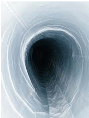
d) Preliner im Kanal
