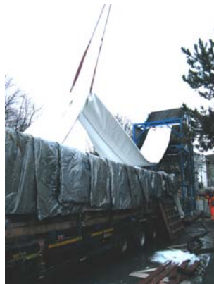
e) Anheben des Liners mit einem Kran
