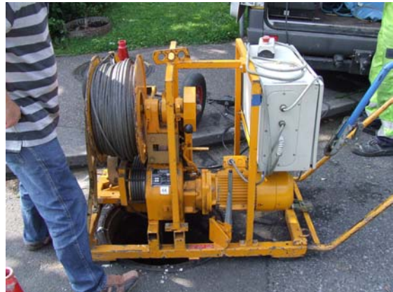
b) Einziehen des Schlauchliners, Ansicht der Seilwinde
