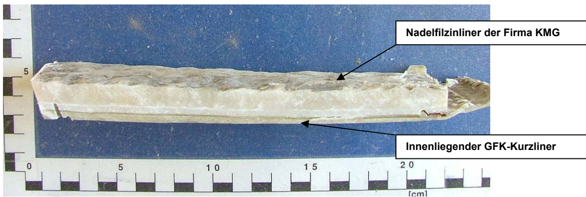
c) Seitenansicht Haltungsprobe L2, Kurz- und Schlauchliner
