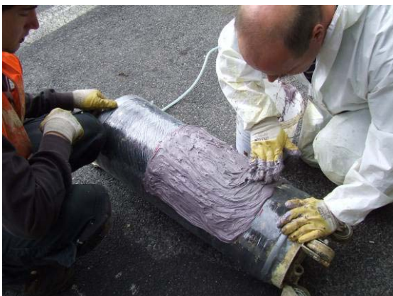
e) Händisches Auftragen des Epoxid-Harzes auf den Packer
