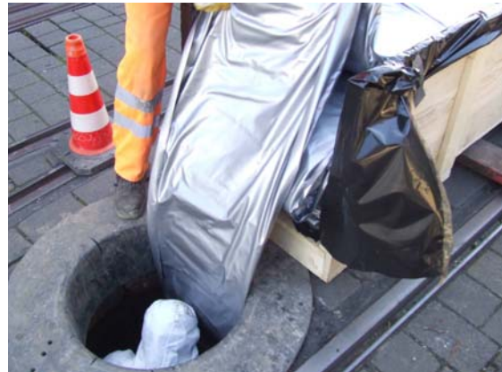
b) Einzug des Schlauchliners
