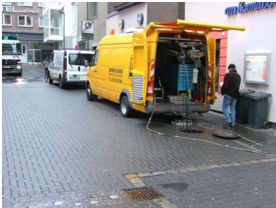
a) Fräsarbeiten zur Probenentnahme, Ansicht von der StraÙeoberfläche
