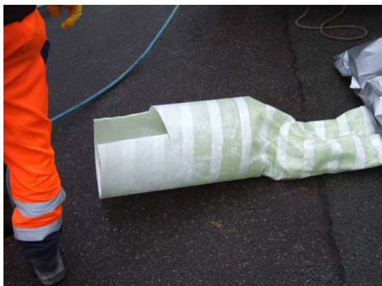
g) Darstellung des (teil-)ausgehärteten Liners (Baustellenprobe)
