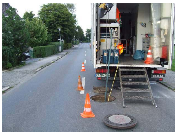
g) Entnahme einer Haltungsprobe, Ansicht von der Straßenoberfläche
