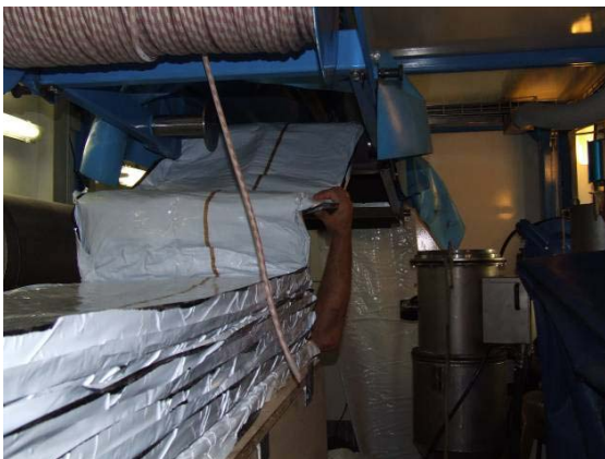
c) Einziehen des Schlauchliners, Ansicht Hebevorrichtung
