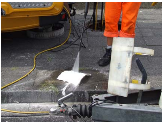
a) Reinigung eines Probekörpers nach Entnahme
