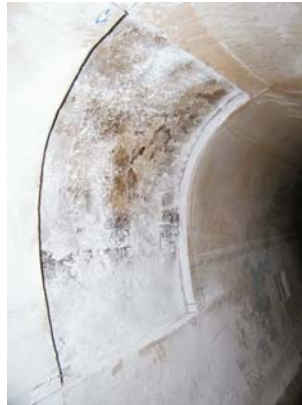
k) Baustellenprobe, Entnahmestelle 1
