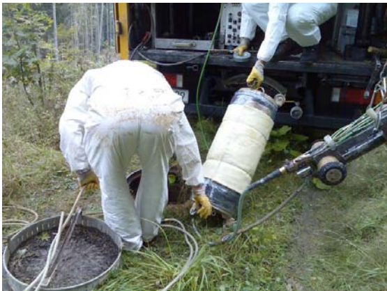
e) Reparatur der Probenentnahmestellen, Kurzliner auf Packer
