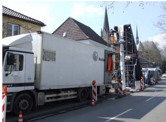
d) Inversion des Schlauchliners
