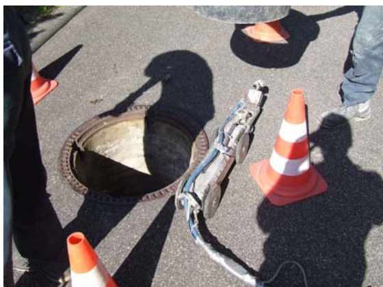
c) Fräsroboter zur Entnahme von Haltungsproben
