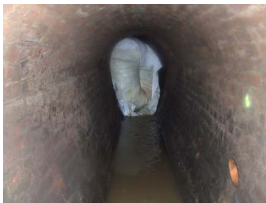
h) Inversion des Liners, Ansicht im Kanal
