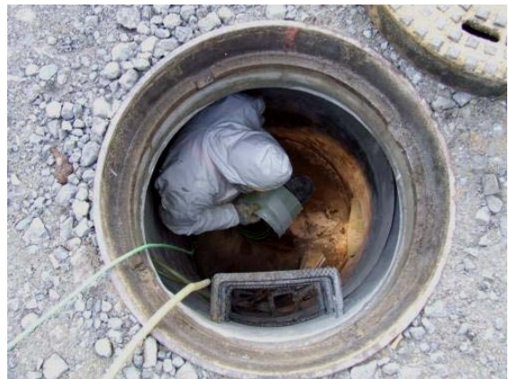
d) Bergung einer Haltungsprobe
