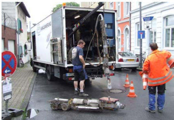
a) Baustelleneinrichtung, Vorbereitung des Kanalroboters zur Probenentnahme
