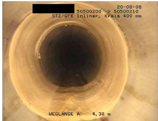
f) GFK-Kurzliner zur Reparatur, Ansicht im Kanal
