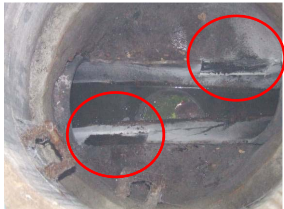
d) Materialproben L5-1 und L5-2, Entnahme aus dem Schachtgerinne
