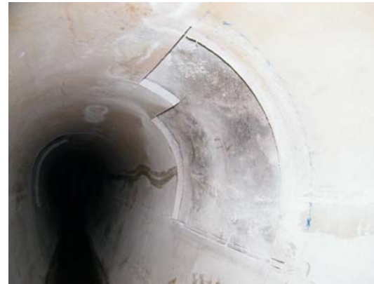
l) Baustellenprobe, Entnahmestelle 2
