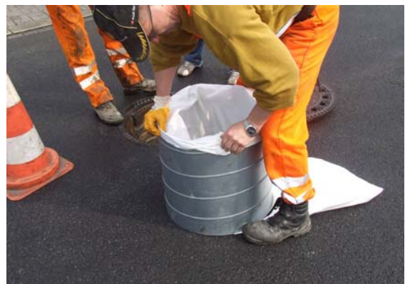
b) Vorbereitungen für eine Schachtprobe, Jeanskappe und Stützrohr
