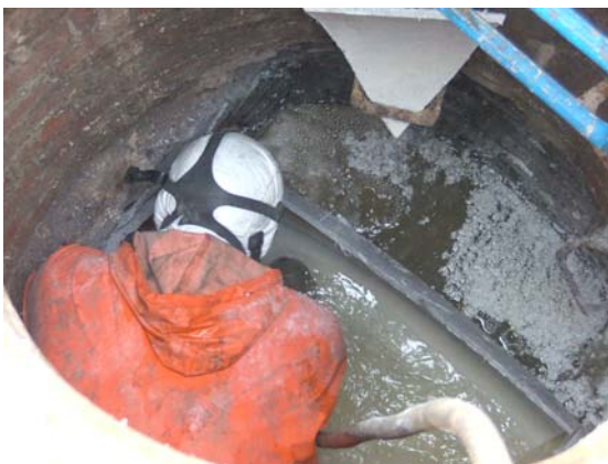
e) Öffnen des Schlauchliners nach Härtung und Abkühlung
