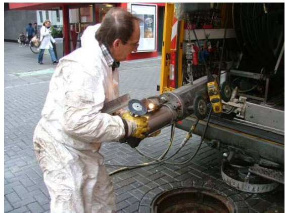
d) Umrüstung des Kanalroboters zur Reparatur der Entnahmestellen
