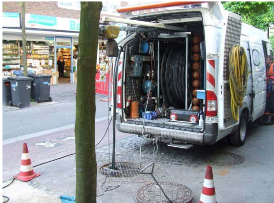
a) Probenentnahme aus der Haltung, Ansicht von der Straßenoberfläche
