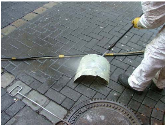
c) Reinigung eines Probekörpers nach der Entnahme aus der Haltung
