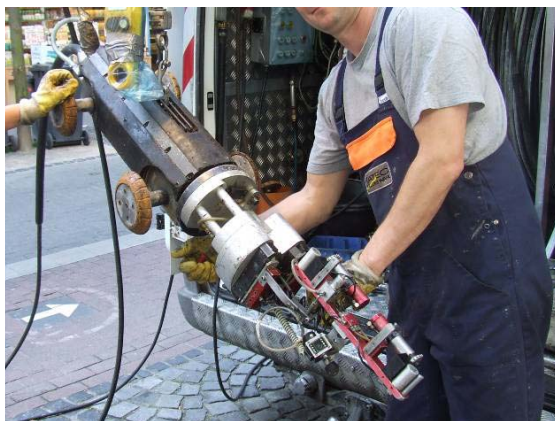
c) Umrüstung des Kanalroboters zum Setzen der Schalungen
