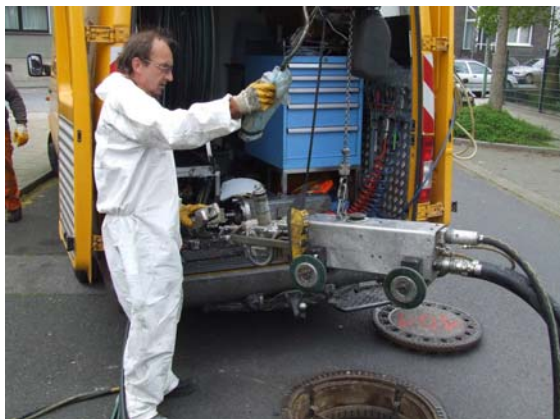
e) Fräsroboter zur Entnahme von Haltungsproben
