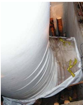
g) Inversion des Liners, Ansicht Startschacht
