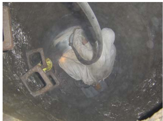
h) Entnahme der Schachtprobe
