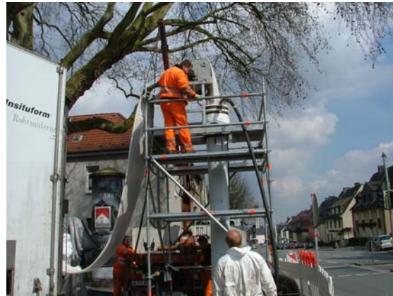
d) Inversion des Schlauchliners
