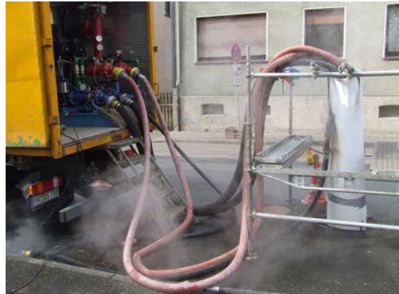
d) Mobile Heizanlage zur Warmwasser-Härtung des Liners
