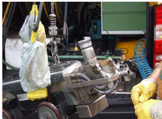
b) Fräsroboter zur Vorbereitung der Reparatur einer Entnahmestelle
