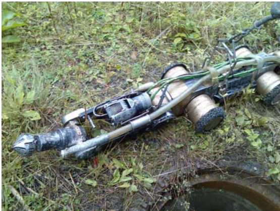
c) Kanalroboter zum Fräsen von Linerproben aus der Haltung
