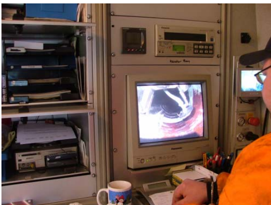
e) Reparatur einer Entnahmestelle, Ansicht Kanalinspekteur
