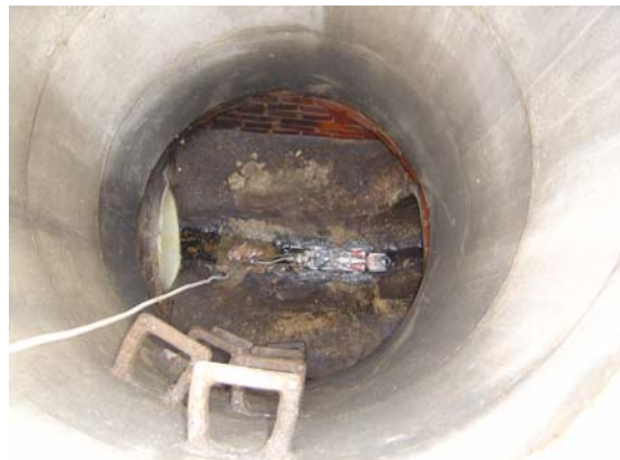
b) Inspektion des Kanals vor dem Einbau mittels TV-Fahrwagenkamera
