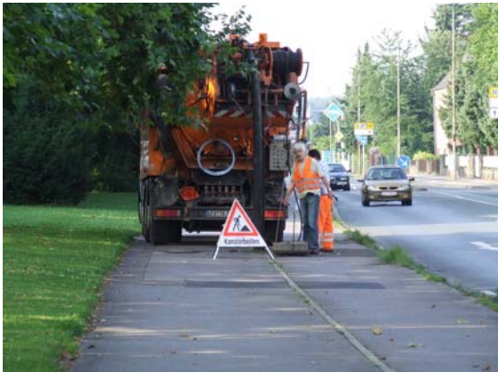
a) Kanalreinigung vor der Sanierung
