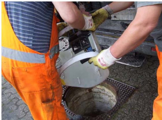
a) Setzen des Schalungselements am Kanalroboter
