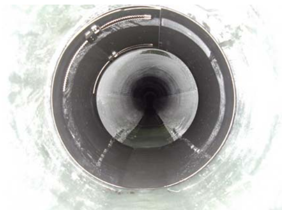
a) Innenmanschette zur Reparatur
