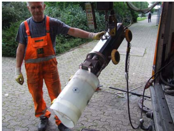
b) Schalung zur Injektion von Verpressharz, Reparatur der Entnahmestellen
