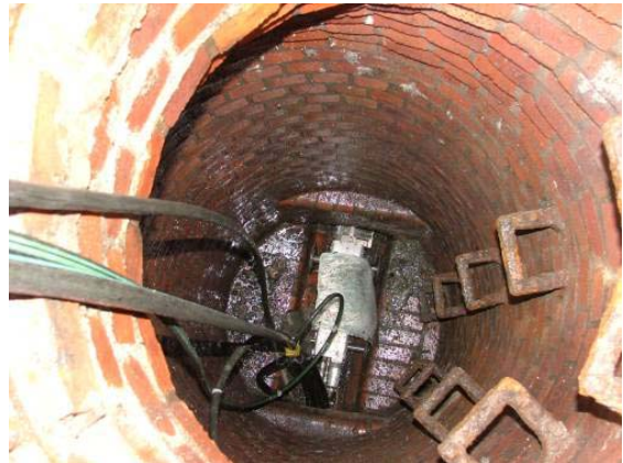
b) Bergung eines Probekörpers aus dem Schacht nach erfolgter Fräsung
