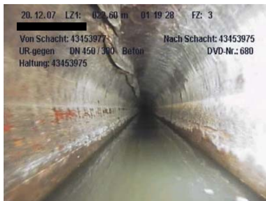
a) Längsfalte im Scheitel, L4
