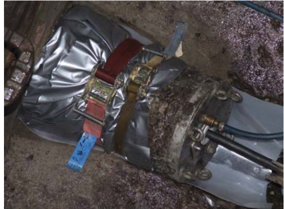
d) Ansicht der Schleuse am Schlauchanfang
