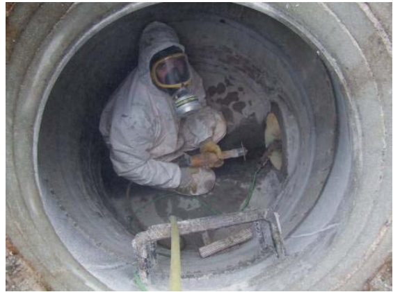
b) Trennschleifer ohne Halteverlängerung zur Entnahme von Haltungsproben
