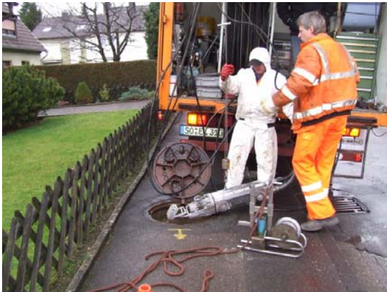
a) Vorbereitungen zur Probenentnahme, Einlass des Fräsroboters in den Schacht
