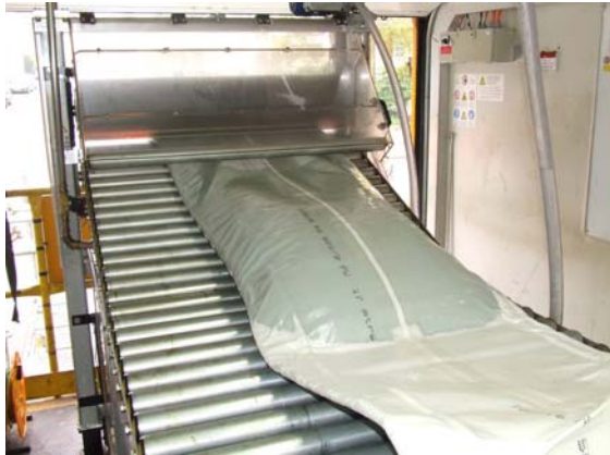
c) Imprägnierung des Liners mit einer mobilen Tränkungsanlage
