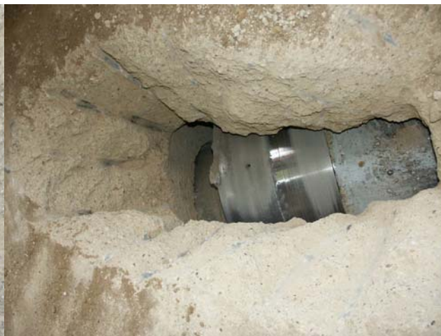
Bild 4-15: freigelegte Aufweitungsstufe
