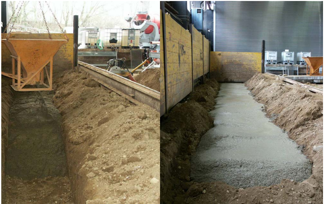
Bild 4-12: Einbau des Betons zur Simulation eines Felsgesteins
