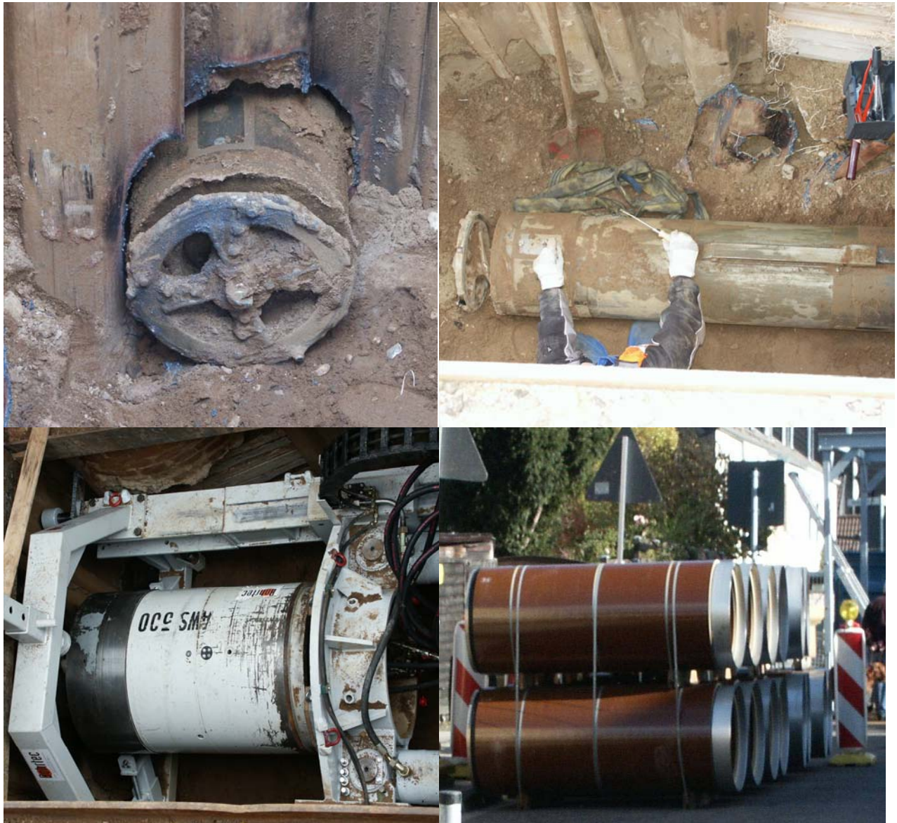
Bild 5-4: Durchstoß des Steuerkopfes im Zielschacht, Montage der aktiven Aufweitungsstufe, Vortriebsrohre Stz DN600
