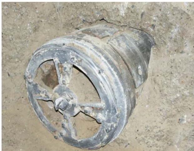
Bild 4-14: Steuerkopf im Beton
