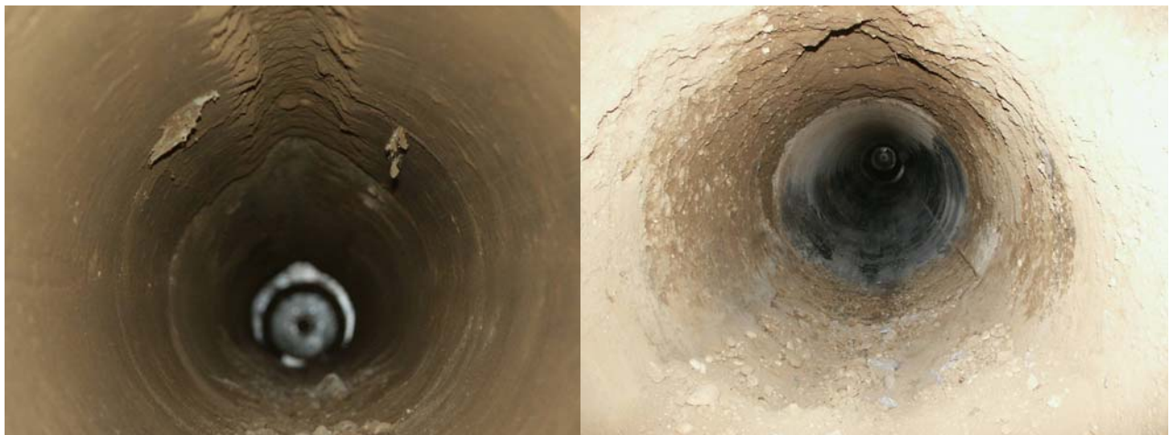
Bild 4-8: Blick in den Hohlraum, der mit dem Steuerkopf (links) und der Aufweitungsstufe (rechts) aufgefahren wurde
