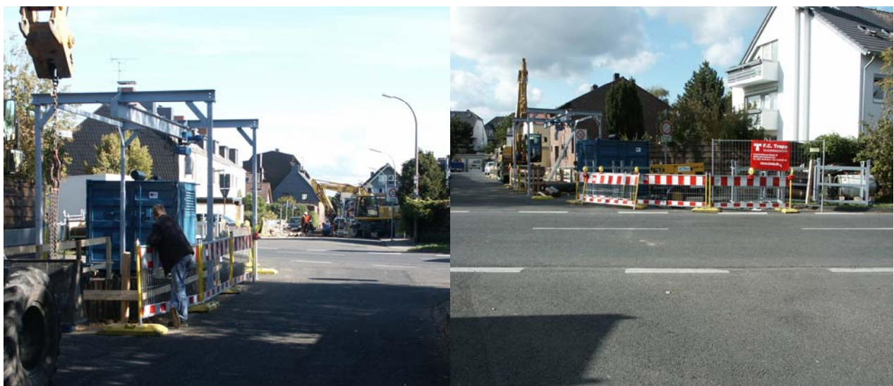
Bild 5-2: Baustelleneinrichtung des ersten Vortriebs
