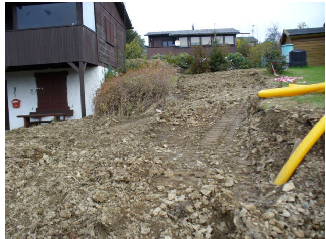
Abbildung 10: Oberirdische Auswirkungen der Erneuerung der Hausanschlüsse
