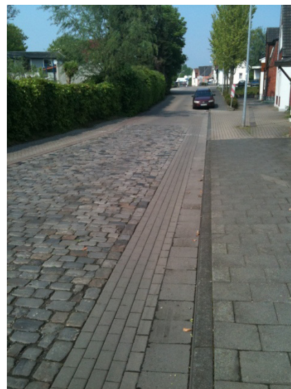
Abbildung 37: Anwohnerstraße mit vorgeschriebener Fahrrichtung
