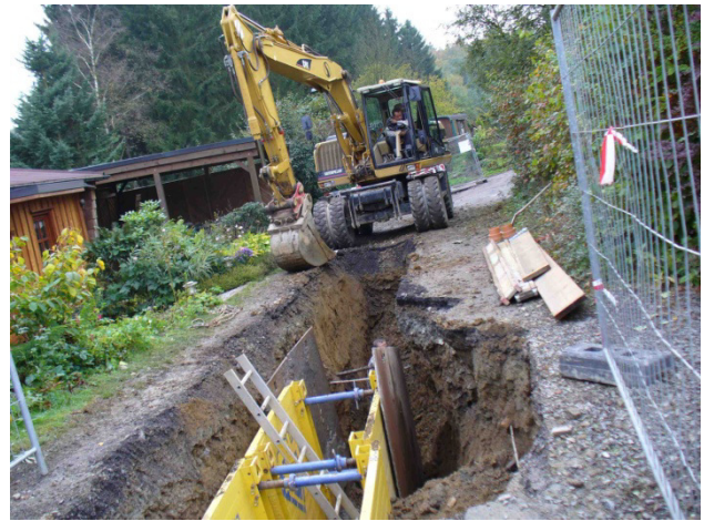
Abbildung 8: Vollsperrung von Anwohnerstraßen bei offener Bauweise
