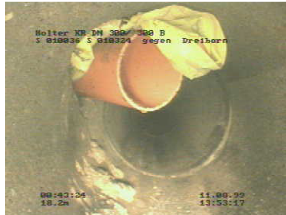
Abbildung 4: Von einem Grundstückseigen-tümer unsachgemäß hergestellter Anschluss an einen öffentlichen Sammler.
