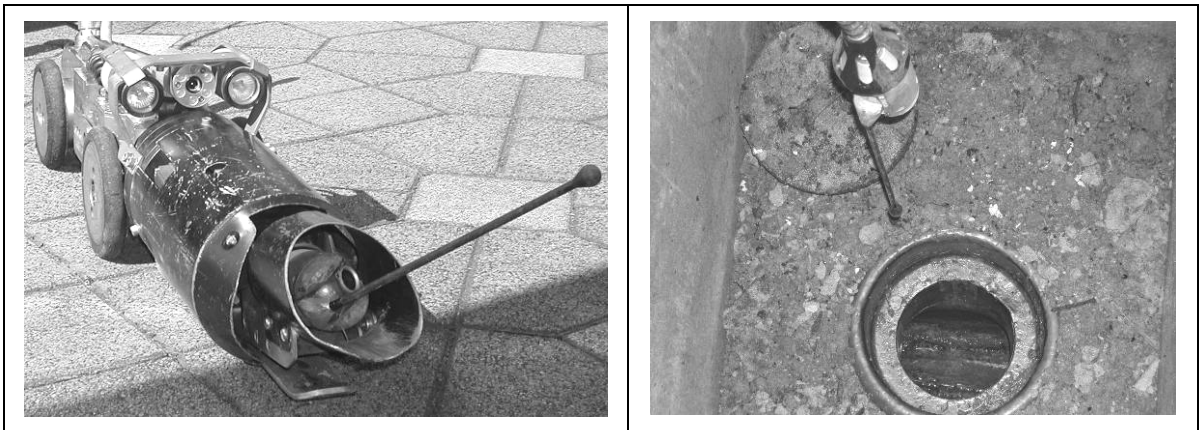
Bild 3.3: IBAK ORION L und geöffnete Revisionsöffnung zur Inspektion
