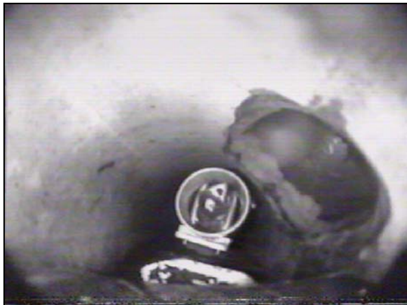
Abb. 68: Einsatz des Systems SPE [20] zur Positionierung einer Reinigungsdüse mit Vorstrahl im Einmündungsbereich einer Grundstücksentwässerungsleitung, vor dem Einschwenken in die HAL.
