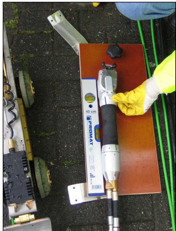
Abb. 66: Horizontale Ausrichtung der Lindauer Mini-Schere zur Kalibrierung des unterirdischen Ortungs- und Kanalverlaufsmeßsystems ASYS.
