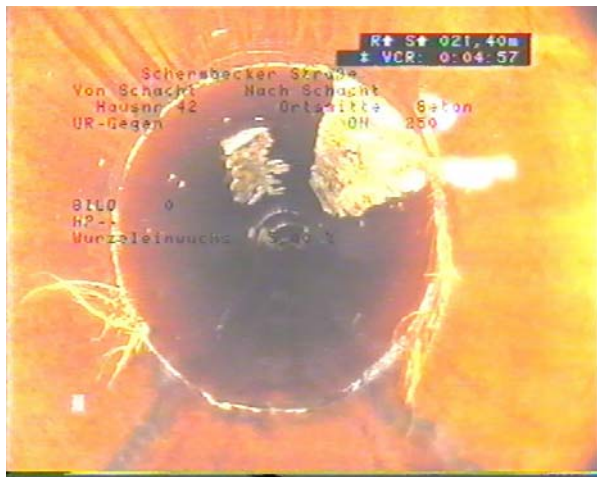
Abb. 26: Wurzeleinwuchs im Hauptkanal (Haltung 6109S - 6108S, 16,7 m). Zustand am 03.03.1999.
