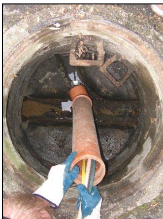
Abb. 21: Einführung der ORION L über ein PVC-Rohr
