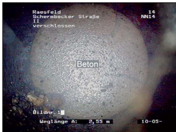
Abb. 76: Verschluss der unbenutzten Anschlüsse mit Beton.
