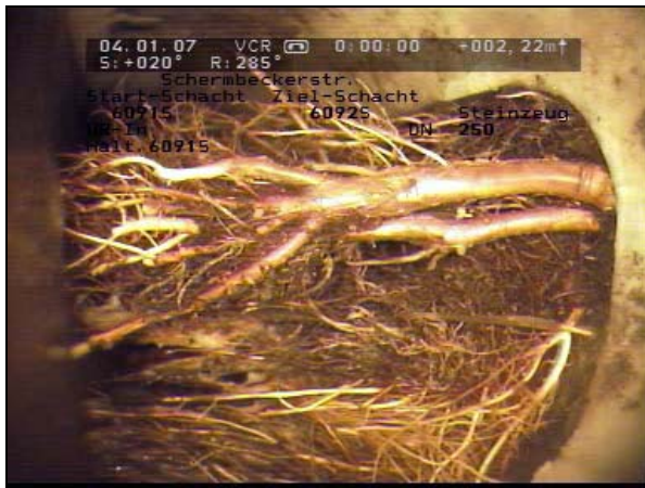
Abb. 60: Durch den Stutzen einer Grundstücksentwässerungsleitung sind Wurzeln eingewachsen und verschließen den Querschnitt der Anschlussleitung nahezu vollständig.
