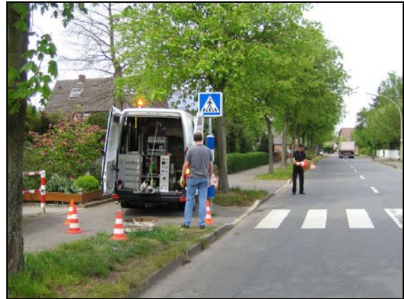
Abb. 64: Einrichten der Baustelle für die Inspektion der Grundstücksentwässerungsleitungen aus dem Schmutzwasserkanal DN 250
