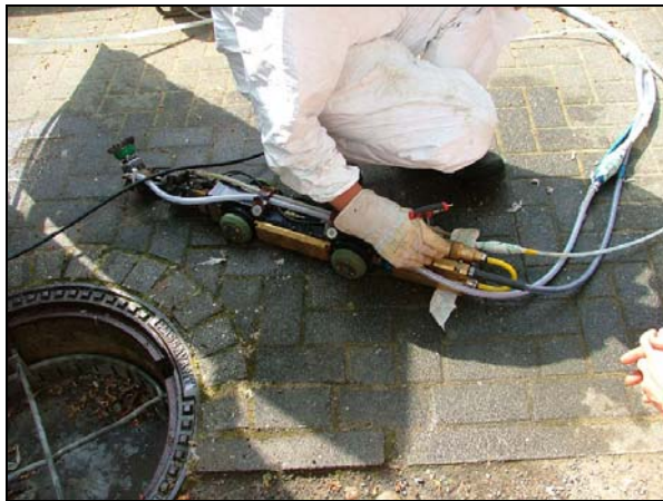
Abb. 49: Pneumatisch betriebener Fräsroboter der Fa. JT-Elektronik mit Topfbürste als Fräswerkzeug (Gesamtansicht)
