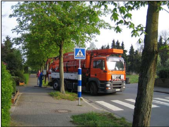
Abb. 63: Reinigung des Schmutzwasserkanals DN 250 vor dem Einsatz der Lindauer Mini-Schere.
