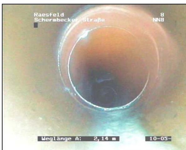
Abb. 82: Werkstoffwechsel in der Leitung mit der laufenden Nr. 8. Hier wurde bereits ein Teil der Grundstücksentwässerungsleitung erneuert und ein Revisionsschacht eingebaut.
