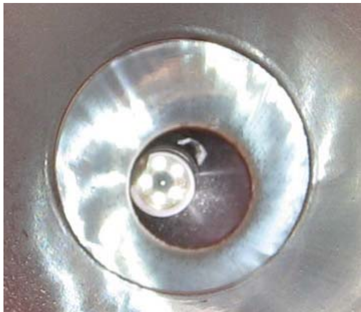
Abb. 12: Seitwärtsbewegung des Aaligators im Rohr durch die Düsen im Kamerakopf
