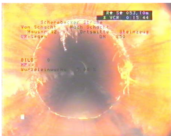
Abb. 28: Wurzeleinwuchs im Hauptkanal (Haltung 6108S, 21,4 m). Zustand am 03.03.1999.
