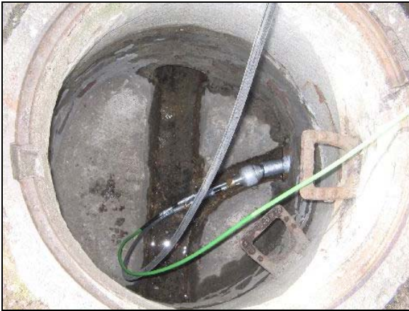
Abb. 18: Einführung der Lindauer Schere (mini) in einen Abzweig
