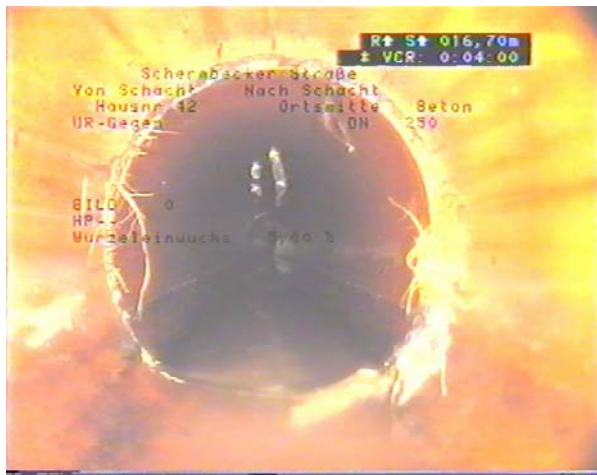
Abb. 26: Wurzeleinwuchs im Hauptkanal (Haltung 6109S - 6108S, 16,7 m). Zustand am 03.03.1999.
