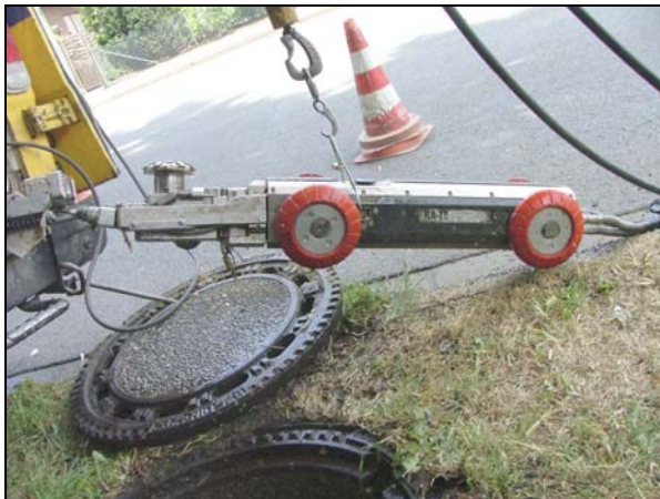
Abb. 41: Einbringen des Fräsroboter zur Wurzelentfernung in einen Schacht des Hauptkanals in der Schermbecker Straße in Raesfeld.
