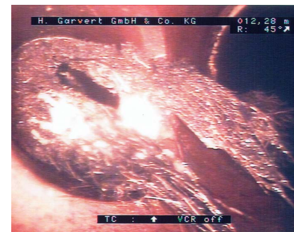
Abb. 29: Wurzeleinwuchs im Hauptkanal (Haltung 6109S - 6108S, 27,3 m). Zustand am 03.03.1999.
