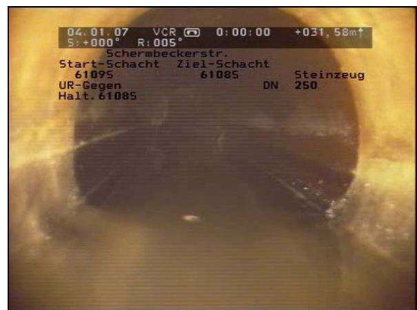
Abb. 40: Rand eines Kurzschlauchs ohne das Auftreten von Wurzeln. (Haltung 6109S – 6108S, 31,58 m).
