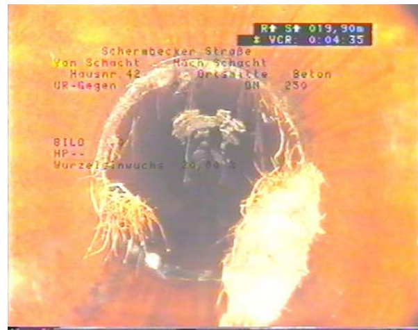
Abb. 27: Wurzeleinwuchs im Hauptkanal (Haltung 6109S - 6108S, 19,9 m). Zustand am 03.03.1999.
