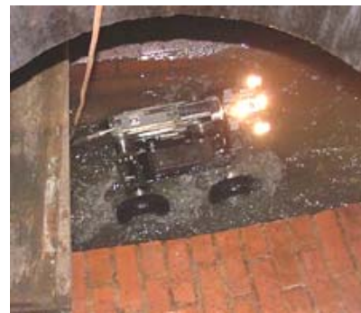
c) Roboter im Schachtgerinne
