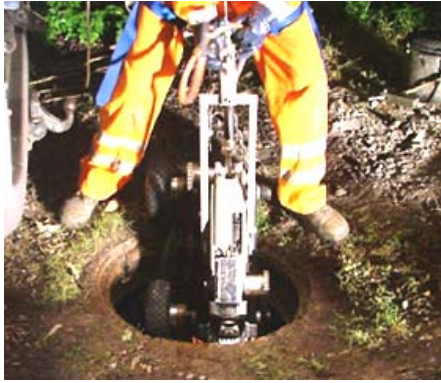
a) Absenken des Roboters
