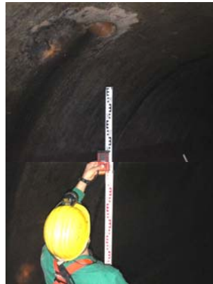
b) Einmessen eines Zulaufes
