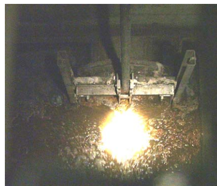
a) Spindel mit aufgesetzter Bohrmaschine b) Schieber geschlossen
