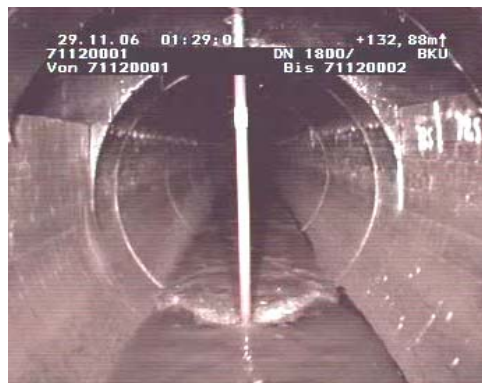
b) Sicherungspunkt: senkrecht verspannte Baustütze im Zielschacht
