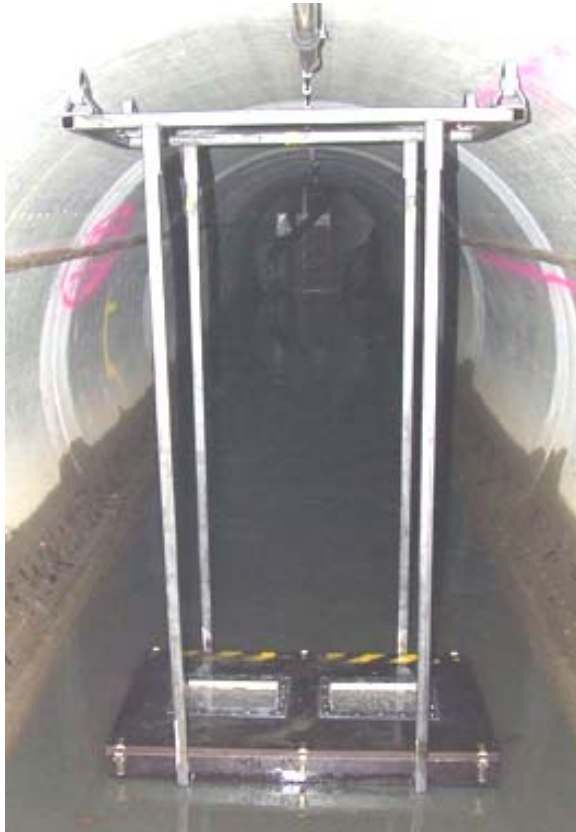
a) Gesamtansicht in Rohrlängsrichtung, Wasserstandshöhe ca. 37 cm
