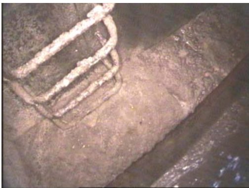
c) Sedimente auf der Berme, H ≈ 10 cm
