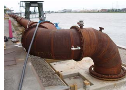
b) geflanschter Anschluss an ein Zulaufbauwerk
