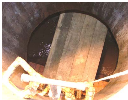
a) Einbringen der Holzbohlen b) Arbeitsplattform aus 4 Holzbohlen
