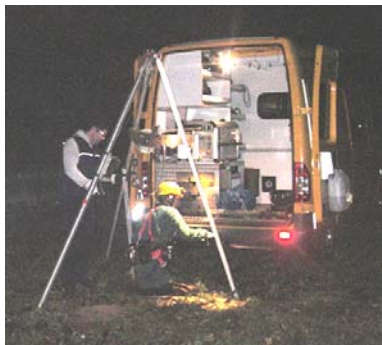
a) Inspektionsfahrzeug am Zugangsschacht
