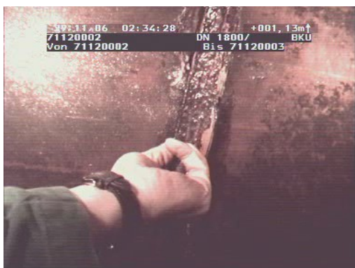
Abb. 76: Beispiele für manuelle Untersuchungen von Rohrverbindungen, Fotos: [100]*
