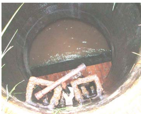
a) tangentialer Zugangsschacht, Schachtöffnung Ø 62,5cm
