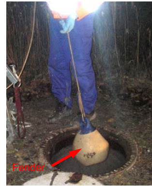
c) Einbringen des Vorseils
