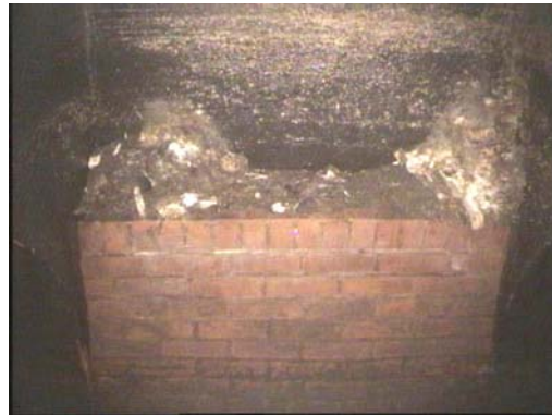
d) Sedimente auf der Berme, H ≈ 15 cm
