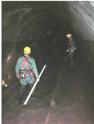
a) Inspekture im Kanal
