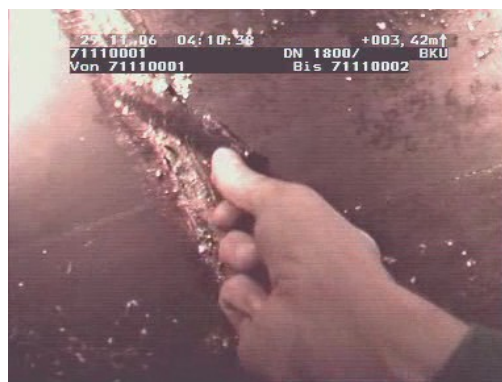
Abb. 76: Beispiele für manuelle Untersuchungen von Rohrverbindungen, Fotos: [100]*
