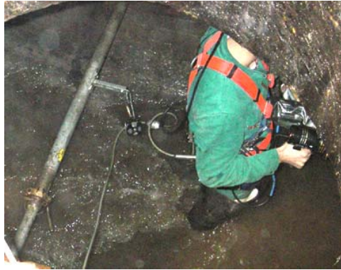
d) Umlenkrolle für Datenkabel über der Rohrsohle
