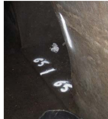
c) Markierung eines Schachtmittelpunktes
