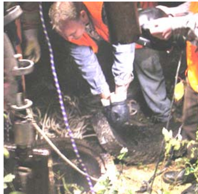
b) Bergung der Segmente des Schachtkonus
