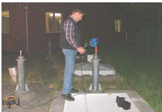
a) Spindel mit aufgesetzter Bohrmaschine b) Schieber geschlossen
