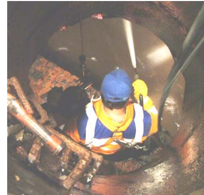
a) Reinigung der Steigeisen b) Aufstellen eines Dreibeins c) Reinigung der Bermen
