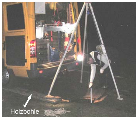
a) provisorische Untergrundbefestigung mit Holzbohlen
