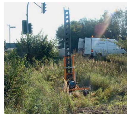
b) Situation vor Ort, Foto: IKT
