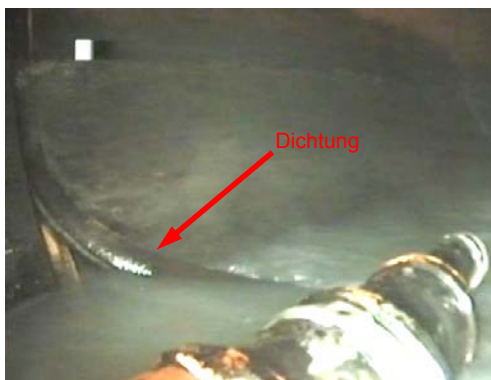
a) einragende Sekundärdichtung
