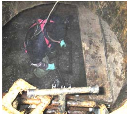
e) Montage des Fahrwagens im Startschacht der Inspektion
