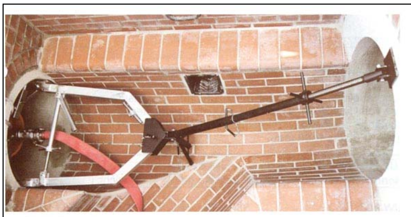
Abb. 3: Verbau von Absperrvorrichtungen [67]
