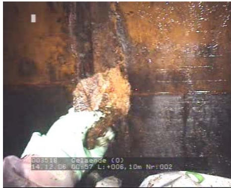
a) Probe der Rohrinnauskleidung
