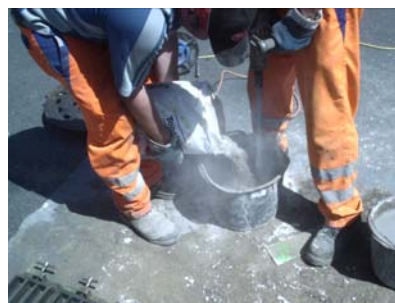
Abb. 124: Anrühren des Mörtels unter Baustellenbedingungen
