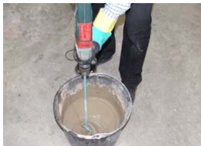
Abb. 117: Mischen des Mörtels
