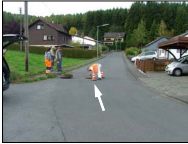
Abb. 35: Schachtabdeckung in einem Wohngebiet, geringes Verkehrsaufkommen
