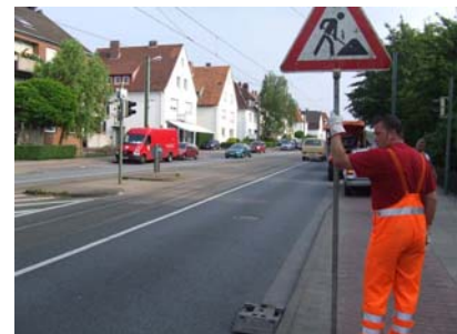
Abb. 104: Aufstellen der Beschilderung auf einer Hauptverkehrsstraße (innerorts)
