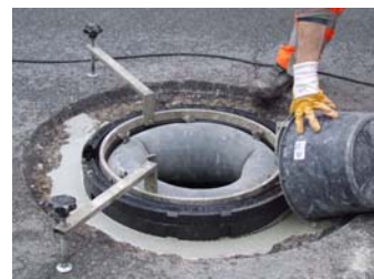
Abb. 25: Verfüllung mit Vergussmörtel
