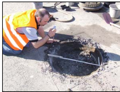
Abb. 45: Inspektion einer freigelegten Mörtelfuge
