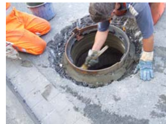
Abb. 22: Glätten der Mörtelfuge
