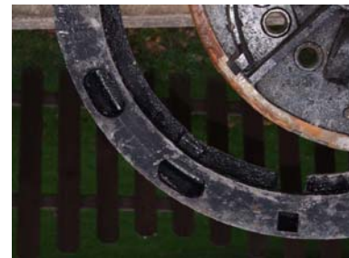
Abb. 31: Ausschnitt eines vertikal aufgerichteten Guss-Rahmens einer Hydrotec-Schachtabdeckung mit Öffnungen an der Unterseite
