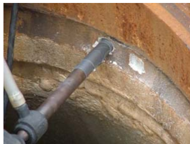
Abb. 58: Entnahme von Bohrmehl (Detail)
