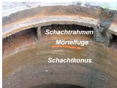
Abb. 99: verschmutzte Mörtelfuge
