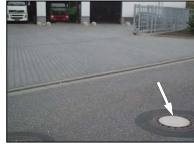
Abb. 37: Schachtabdeckung im Kurvenbereich unmittelbar vor der Einfahrt zu einem Werksgelände
