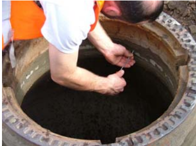
Abb. 62: Installation des Messfühlers
