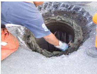
Abb. 20: Aufbringen des Mörtels
