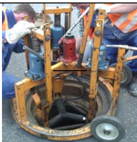
Abb. 6: Anheben der Schachtabdeckung mittels Schachtrahmenhebergerät
