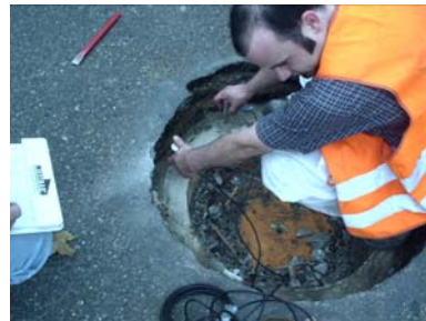
Abb. 54: Ultraschallmessung an der Kontaktfläche einer freigelegten Mörtelfuge
