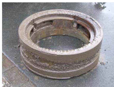
Abb. 69: Ausgebohrte Schachtabdeckung mit Mörtelfuge und Ausgleichsring
