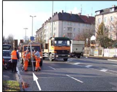
Abb. 36: Schachtabdeckung im Innenstadtbereich, hohes Verkehrsaufkommen
