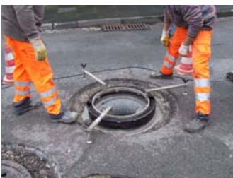
Abb. 23: Ausrichten der Schachtabdeckung mittels Nivellierahmen
