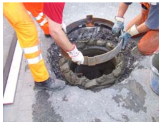
Abb. 21: Setzen der Schachtabdeckung
