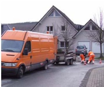
Abb. 102: Absicherung einer Baustelle in einer 30er-Zone eines Wohngebiet
