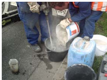
Abb. 106: 2. Arbeitsschritt: Mischvorgang
