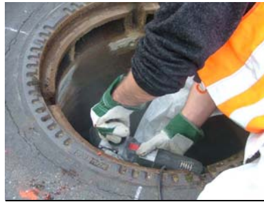
Abb. 100: Anschleifen der Oberfläche
