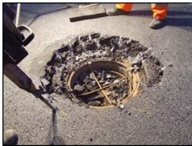
Abb. 44: Herkömmliche Freilegung einer Mörtelfuge durch Stemmen
