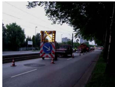
Abb. 103: Absicherung einer Nachtbaustelle auf einer Hauptverkehrsstraße (4-spurig)
