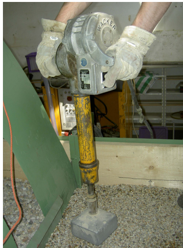
Abbildung 7.7: Einsatz des leichten Verdichtungsgeräts beim Einbau des nichtbindigen Lockergesteins
