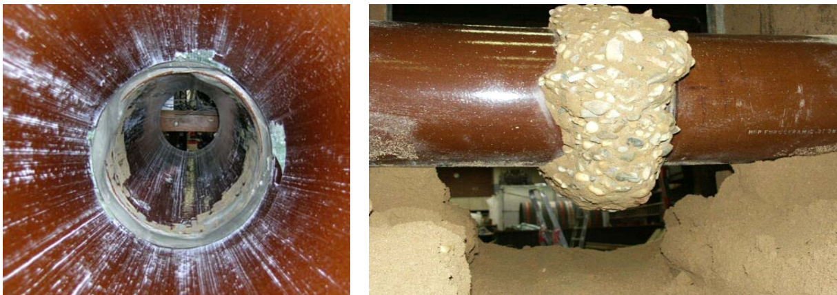
Abbildung 5-10: Sanierte Steinzeugrohrverbindung
