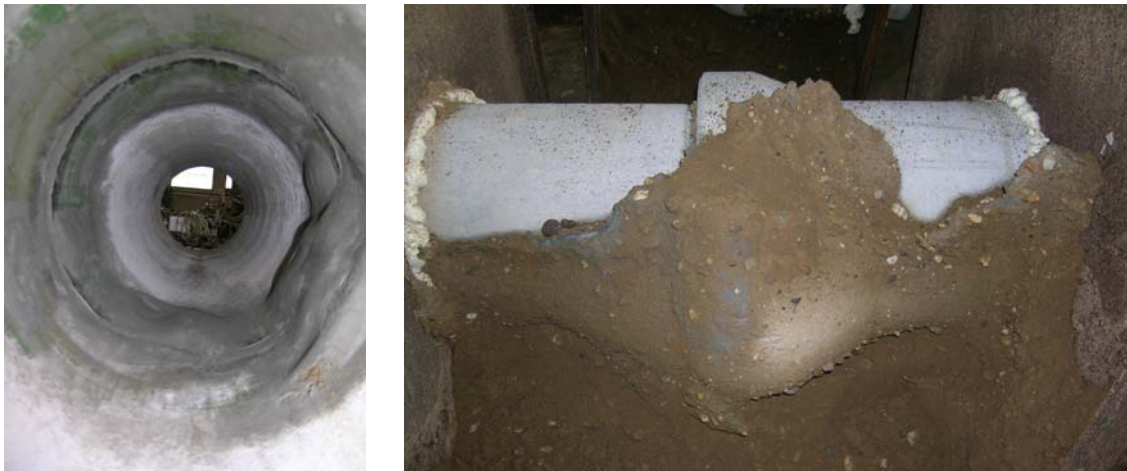
Abbildung 5-8: Sanierte Betonrohrverbindung
