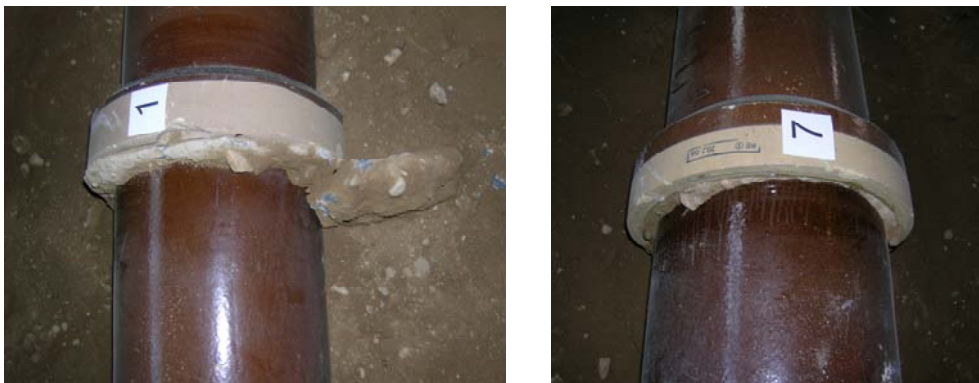
Abbildung 5-22: Freigelegte Rohrverbindungen der Sanierungsstrecke 4
