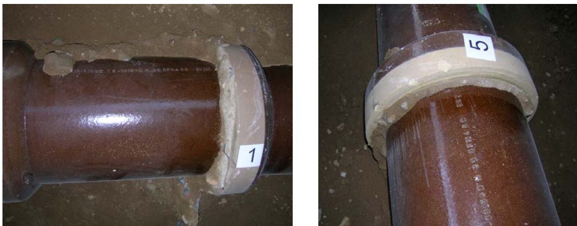
Abbildung 5-19: Freigelegte Rohrverbindungen der Sanierungsstrecke 2
