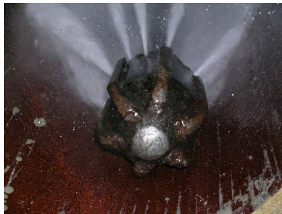
Abbildung 5-24: Spülfahrzeug (links) und Spüldüse im Steinzeugrohr (rechts)
