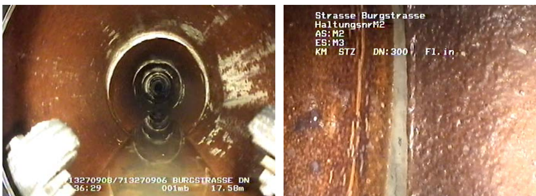
Abbildung 6-4: Kanalkamera - Befahrung nach der Sanierung (links), gut verfüllter Muffenspalt (rechts)
