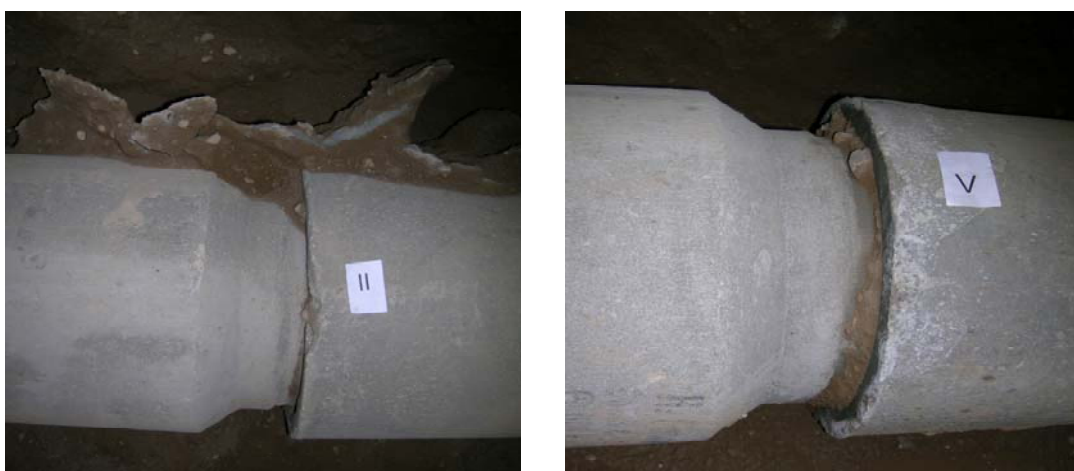
Abbildung 5-20: Freigelegte Rohrverbindungen der Sanierungsstrecke 3
