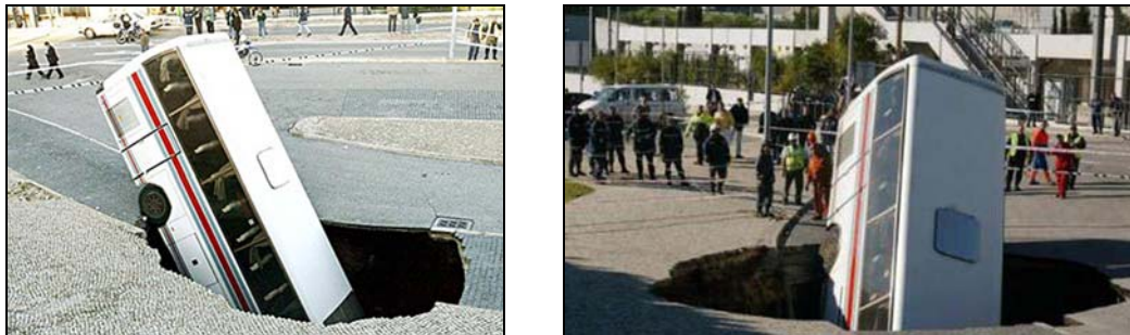
Abbildung 6: Tagesbruch in Lissabon am 25.11.2003 [16]
