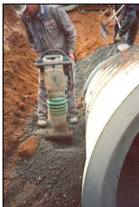
Abbildung 41: Verdichtung der Seitenverfüllung und Abdeckung [48]
