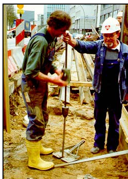
Abbildung 48: Verdichtungskontrolle durch Rammsondierung [44]
