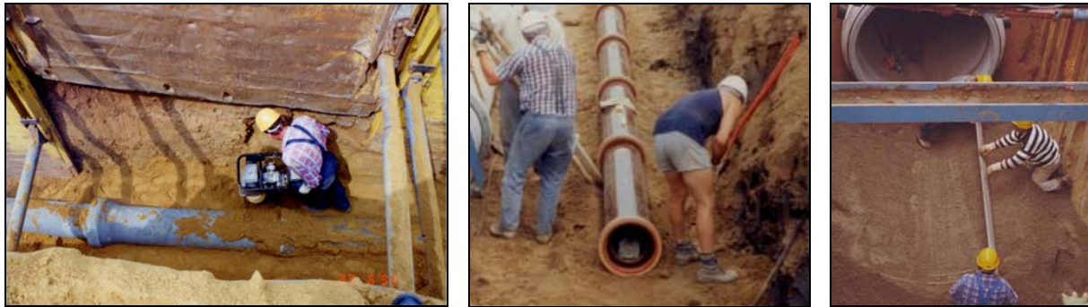
Abbildung 40: Herstellung der Verdichtung der Rohrbettung (Zwickelbereich) [44]
