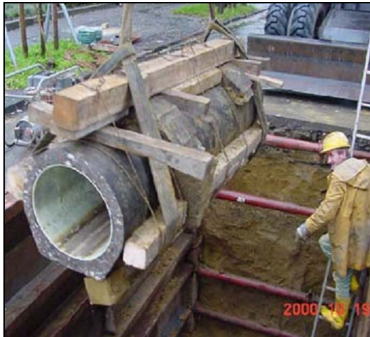
Abbildung 38: Ausbau eines Rohres mit einem 10 Jahre alten Schlauchliner, Detaildarstellung des Kontaktbereiches zwischen Schlauchliner und Altrrohr ohne Ringspalt [41]
