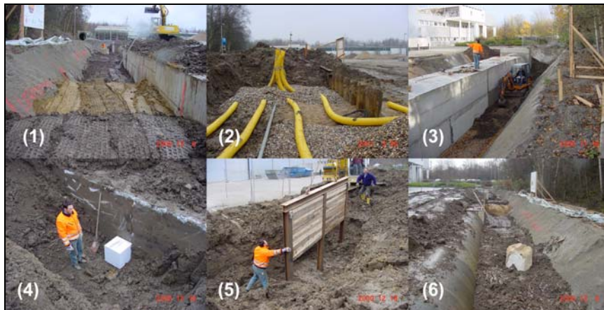
Abbildung 25: Einbau verschiedener Bodenarten und Anomalien in der Versuchshaltung [22]
