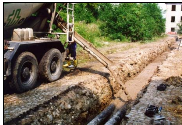
Abbildung 42: Einbau eines flüssigen, selbstverdichtenden Verfüllmaterials [49]
