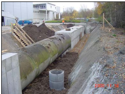
Abbildung 23: Versuchsstrecke auf dem Gelände des IKT – Institut für Unterirdische Infrastruktur in Gelsenkirchen; vor Bodeneinbau und Überschüttung [22]
