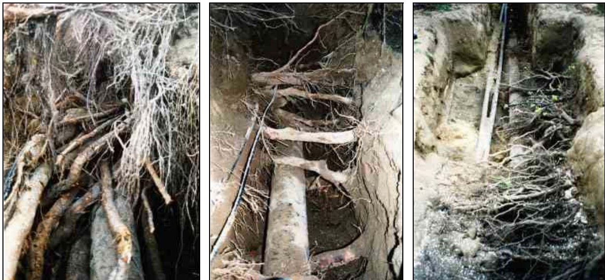
Abbildung 47: Wurzeleinwuchs in der Leitungszone [50]
