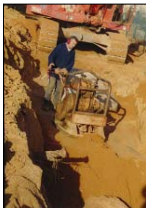
Abbildung 41: Verdichtung der Seitenverfüllung und Abdeckung [48]
