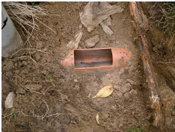
Abb. 24: Untersuchungsstelle A: A Wurzeln des Kirschbaums im oberflächennahen Bereich direkt an der Leitung am Regenfallrohr B Feineres Wurzelwerk an derselben Stelle.
