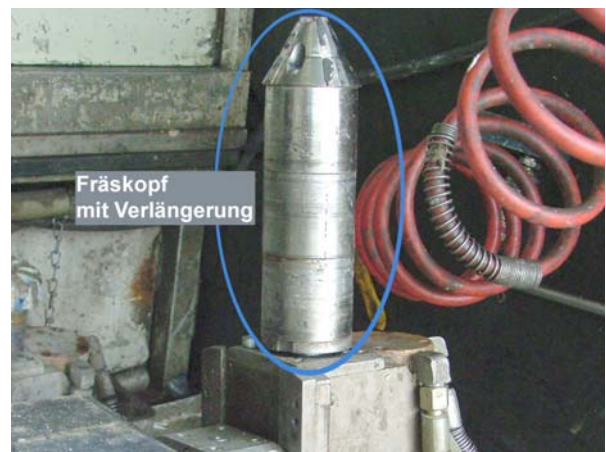
Abb. 61: Zur Entfernung von Wurzelpolstern im Einmündungsbereich der Anschlussleitungen (Abzweige) wurde ein Fräskopf mit einer Verlängerung eingesetzt.
