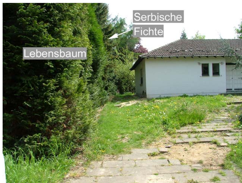
Abb. 26: Untersuchungsobjekt 4, Vorderansicht. Die Reihe Nadelbäume auf der linken Bildseite befindet sich im Abstand von 1,6 m zur Leitung (Leitung im Bild nicht erkennbar, zur Lage der Leitung vgl. Abb. 27). Die Bepflanzung besteht aus Serbischer Fichte ( Picea omorika (Panč.) Purk.) und Abendländischem Lebensbaum ( Thuja occidentalis L.).
