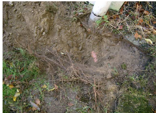
Abb. 24: Untersuchungsstelle A: A Wurzeln des Kirschbaums im oberflächennahen Bereich direkt an der Leitung am Regenfallrohr B Feineres Wurzelwerk an derselben Stelle.
