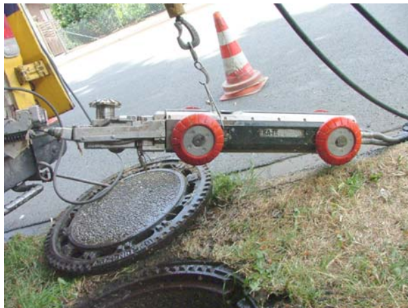
Abb. 58: Einbringen des Fräsroboters zur Wurzelentfernung in einen Schacht des Hauptkanals in der Schermbecker Straße in Raesfeld.
