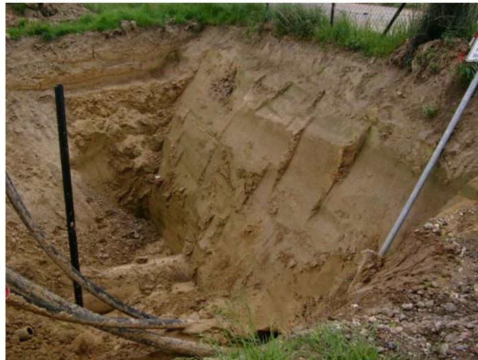
Abb. 3: Oberflächennahe Bodenschichten im Bereich Otzenrath (ca. 4 bis 5 m unter der Geländeoberkante) [3]
