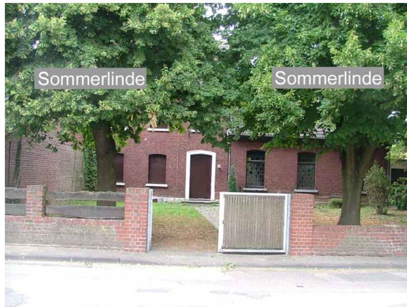
Abb. 40: Vorderansicht Untersuchungsobjekt 7. Im Bild zwei der vier Sommerlinden. Die Leitung verläuft parallel zum Gehweg im Vorgarten.
